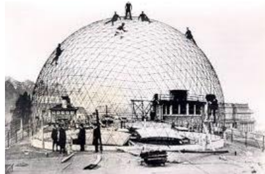
Imatge 3: Construcció del Planetari Zeiss
