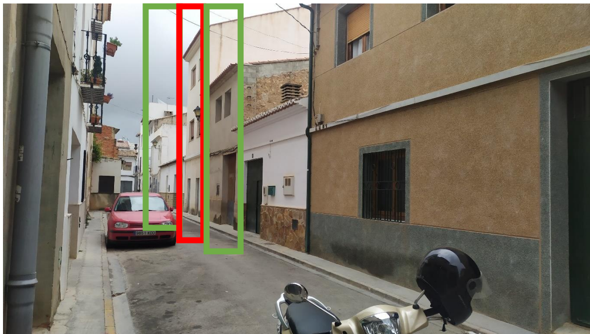
Imagen 9. Edificios colindantes fachada C/Leonardo Aparicio (Propia)
