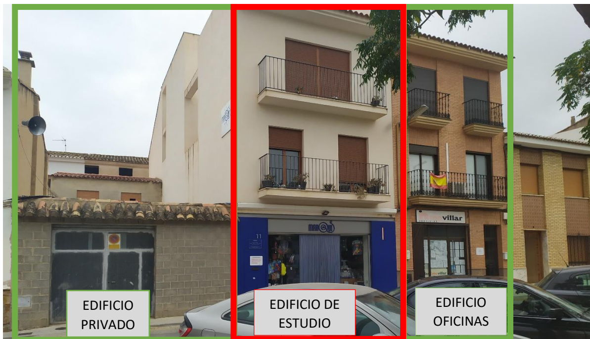
Imagen 8. Edificios colindantes fachada C/Maestro José Ranea (Propia)
