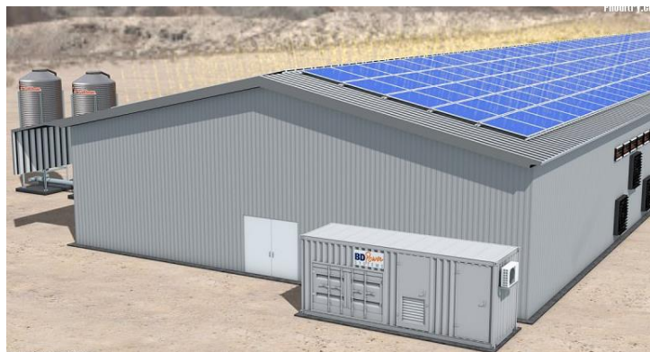
Imagen 8. Instalación fotovoltaica sobre cubierta
