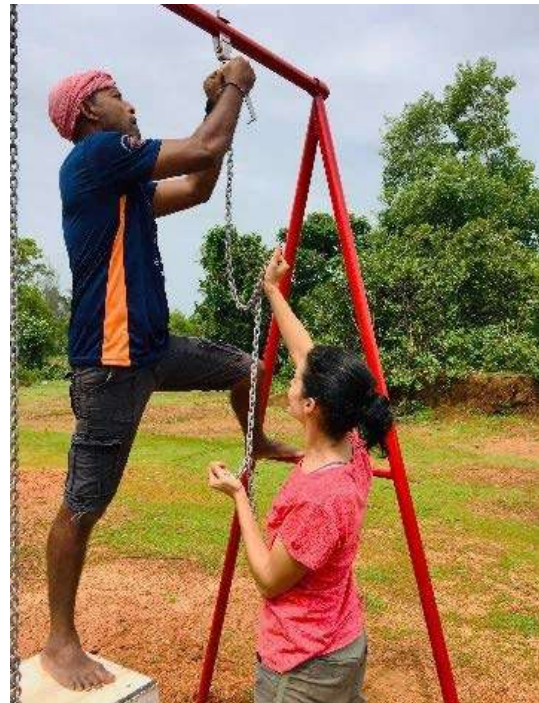
Ilustración 257: Colocación cadenas en los bulones. Fuente: propia
