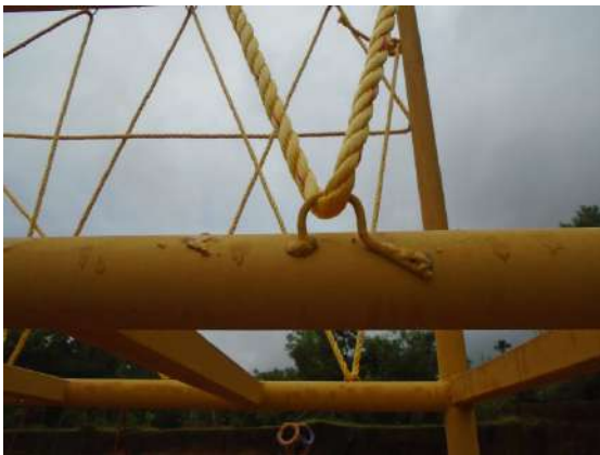
Ilustración 274: Detalle ganchos soldados para colocación de cuerda de seguridad. Fuente: propia
