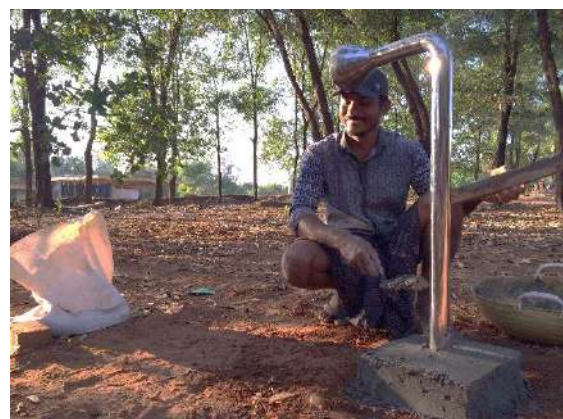
Ilustración 184: Chandra finalizando la cimentación del teléfono. Fuente: propia
