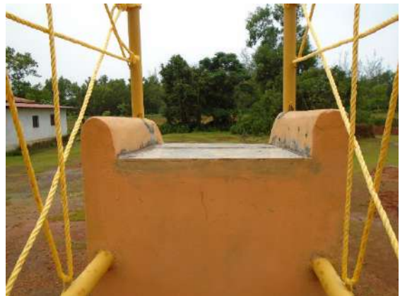
Ilustración 275: Detalle parte superior del tobogán. Fuente: propia
