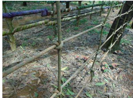
Ilustración 218: Detalle cuerdas anudadas. Fuente: propia
