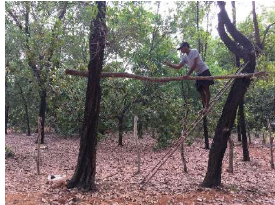
Ilustración 216: Corte de ramas que sobresalen del travesaño. Fuente: propia
