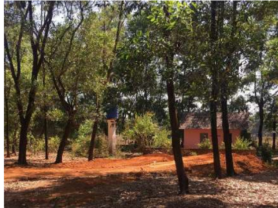
Ilustración 119: Zona del kindergarten nivelada por la máquina. Fuente: propia
