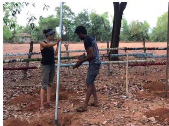
Ilustración 235: Colocando hormigón en las zanjas. Fuente: propia
