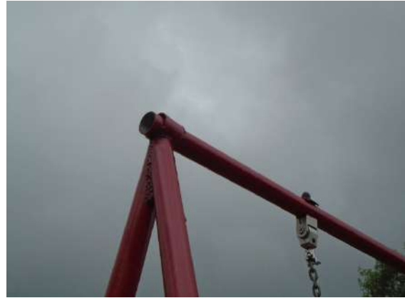
Ilustración 259: Detalle bulón fijado al travesaño. Fuente: propia
