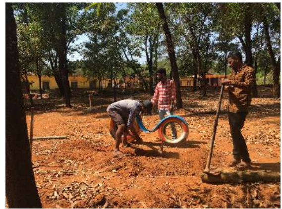
Ilustración 166: Excavación para instalación de Motocicleta. Fuente: propia
