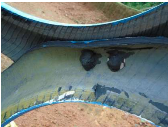
Ilustración 294: Detalle masilla aplicada sobre tornillería. Fuente: propia
