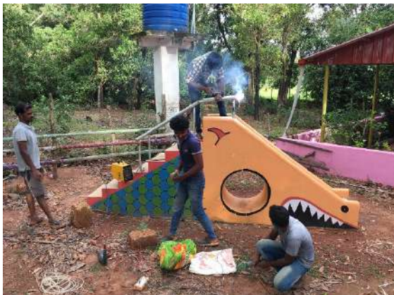
Ilustración 155: Proceso de soldadura. Fuente: propia
