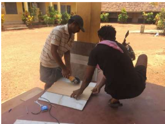
Ilustración 151: Corte de baldosas con radial. Fuente: propia
