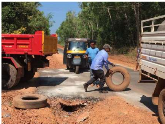
Ilustración 132: Recogida de neumáticos abandonados por la aldea. Fuente: propia
