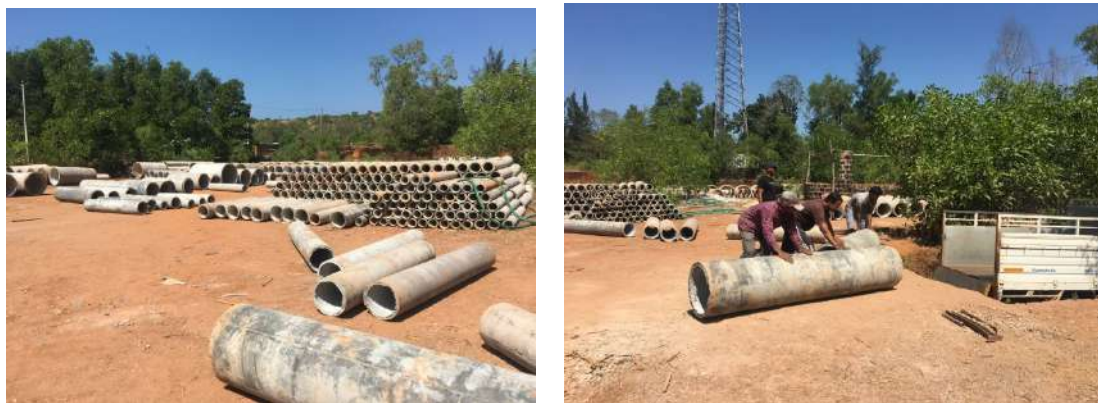
Ilustración 91: Fabrica local de tubos de hormigón
