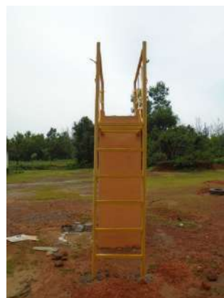
Ilustración 277: Detalle escalera de acceso. Fuente: propia
