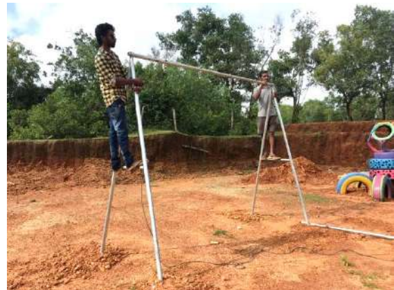
Ilustración 255: Proceso de soldadura del travesaño. Fuente: propia
