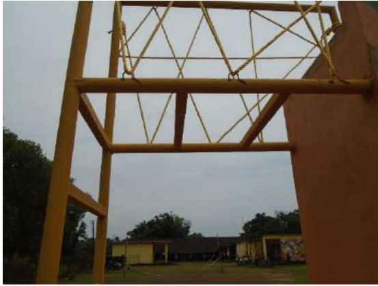
Ilustración 272: Detalle plataforma de acceso al tobogán. Fuente: propia
