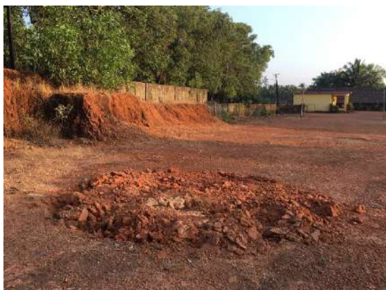
Ilustración 278: Detalle excavación para instalación del octopus. Fuente: propia
