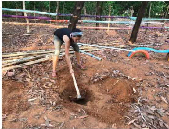
Ilustración 234: Cavando zanja para cimentación de columpio. Fuente: propia
