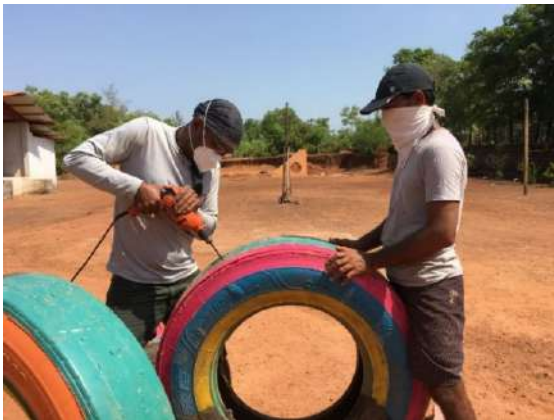
Ilustración 290: Taladrado de neumáticos para Octopus. Fuente: propia
