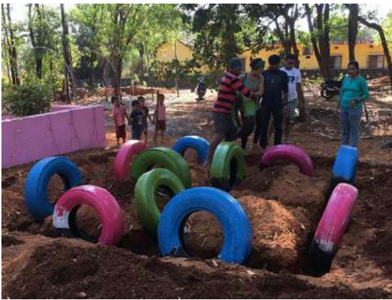
Ilustración 140: Colocando las ruedas en la zanja. Fuente: propia
