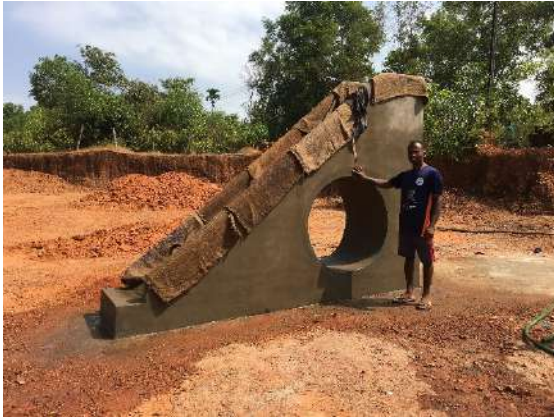
Ilustración 266: Estructura de tobogán con capa de cemento. Fuente: propia
