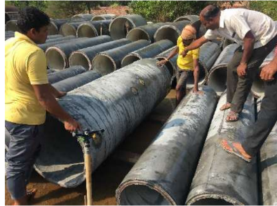
Ilustración 191: Recogida del tubo con agujeros. Fuente: propia
