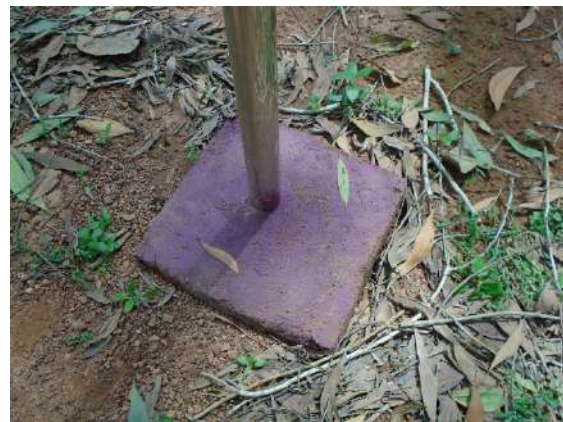
Ilustración 188: Detalle base del teléfono cimentado. Fuente: propia
