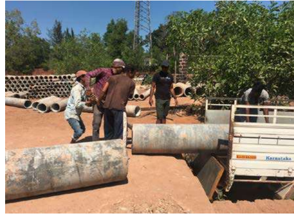
Ilustración 123: Cargando las tuberías que se usarán para la canalización del kindergarten. Fuente: propia
