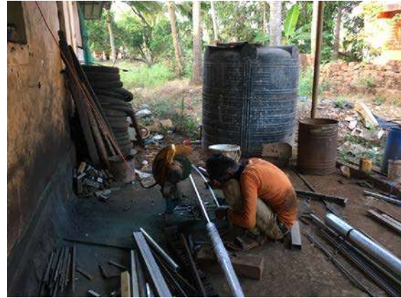
Ilustración 174: Soldador cortando piezas para la fabricación del elemento Speaking phone. Fuente: propia
