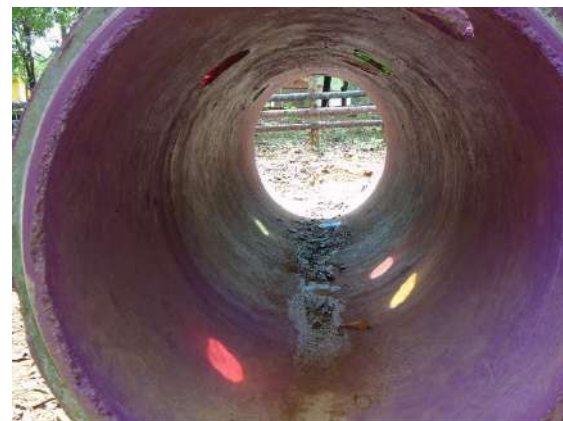
Ilustración 198: Detalle luz de colores incidiendo en el túnel. Fuente: propia
