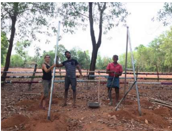
Ilustración 236: Instalación de los laterales del columpio. Fuente: propia
