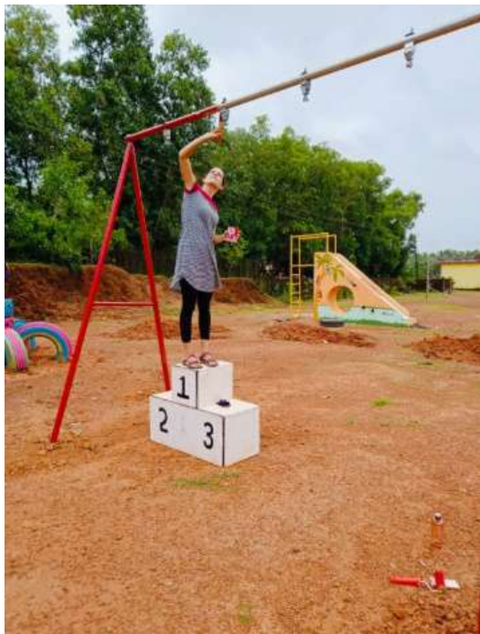
Ilustración 256: Pintado de la estructura del columpio. Fuente: propia
