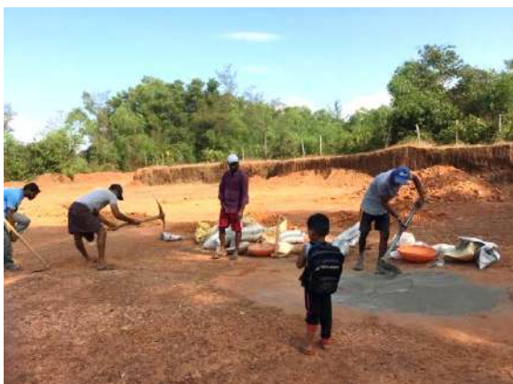
Ilustración 262: Preparando zanja y cemento para construcción del tobogán. Fuente: propia
