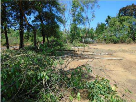
Ilustración 120: Talado de árboles en la zona del campo de cricket. Fuente: propia
