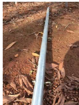
Ilustración 237: Detalle travesaño con anillas colocadas. Fuente: propia
