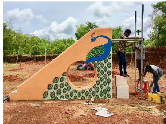
Ilustración 269: Trabajo de soldadura de plataforma de acceso. Fuente: propia
