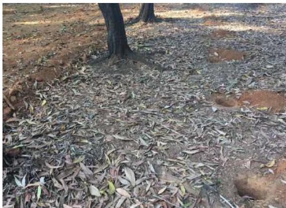
Ilustración 250: Perforaciones realizadas para los pilares del vallado. Fuente: propia
