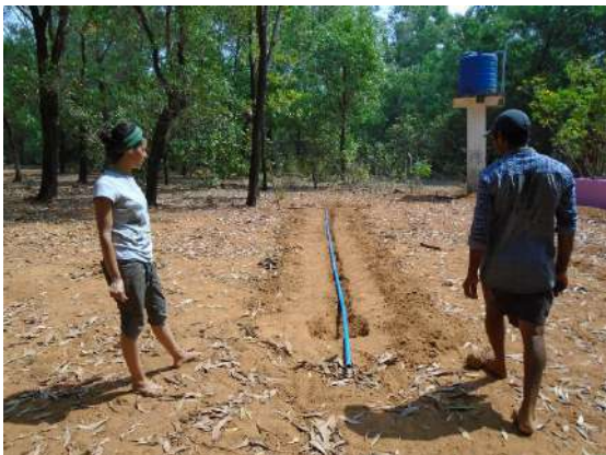
Ilustración 181: Comprobando las dimensiones del tubo en la zanja. Fuente: propia
