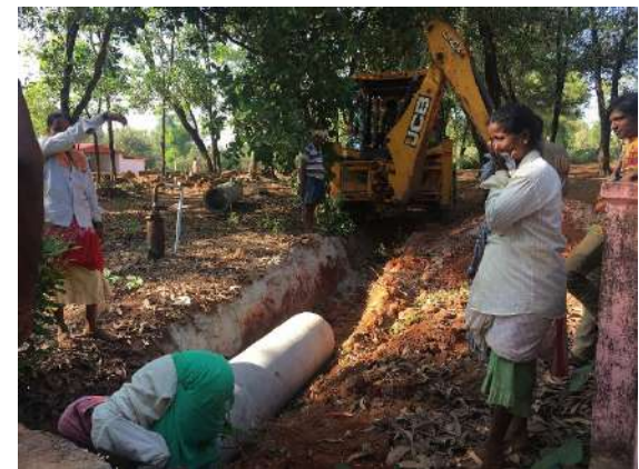
Ilustración 125: Mujeres colocando los tubos en la zanja para la canalización. Fuente: propia
