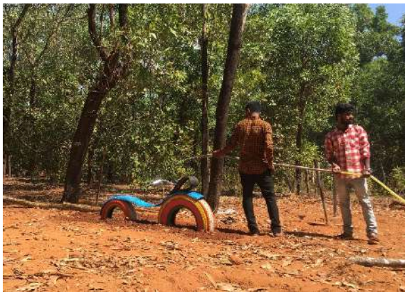
Ilustración 167: Proceso de compactado del terreno. Fuente: propia
