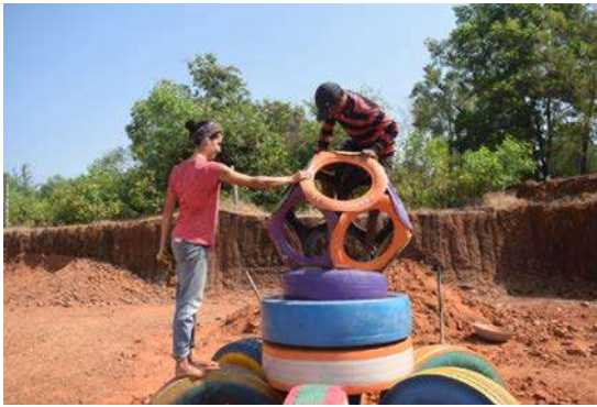
Ilustración 292: Montaje de dodecaedro. Fuente: propia
