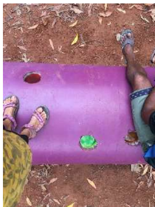
Ilustración 197: Detalle láminas acrílicas colocadas en las perforaciones. Fuente: propia
