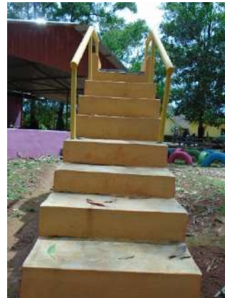
Ilustración 156: Detalle barandilla y escalera de acceso. Fuente: propia
