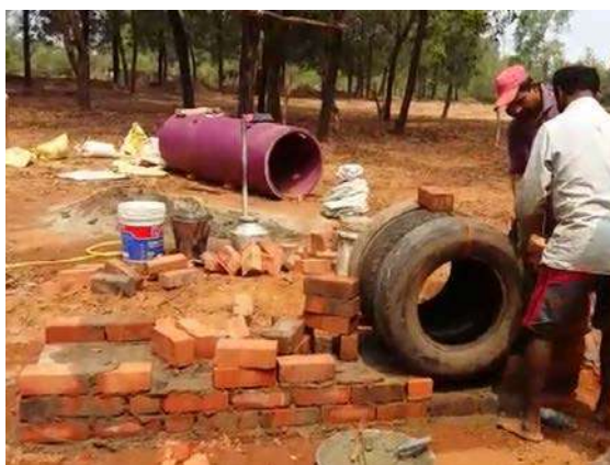
Ilustración 145: Inicio construcción tobogán de ladrillo. Fuente: propia
