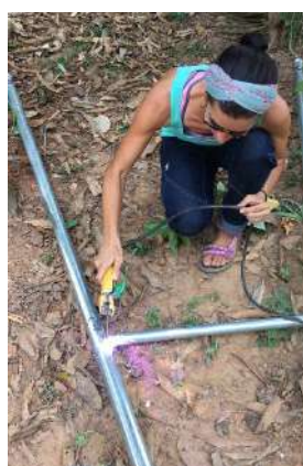
Ilustración 232: Soldando los tirantes laterales.
