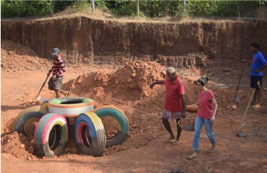
Ilustración 291: Proceso de instalación enterrada del Octopus. Fuente: propia
