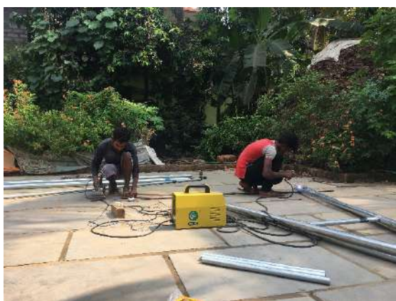
Ilustración 231: Soldando dos piezas de hierro para la cimentación. Fuente: propia
