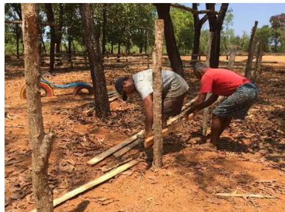
Ilustración 251: Proceso de fijación de las lamas del vallado. Fuente: propia
