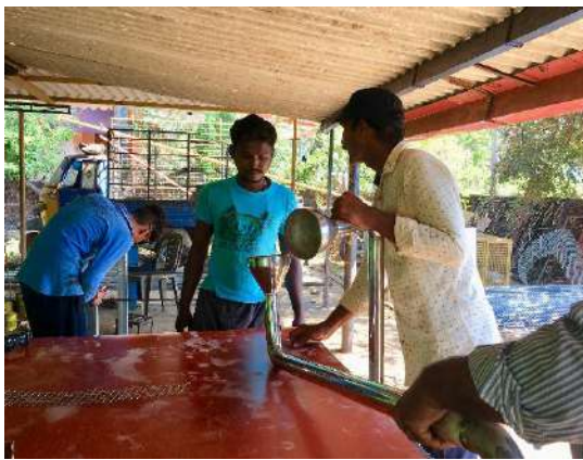
Ilustración 175: Chandra explicando soldadura de rejilla en interior de alcachofa para evitar que se introduzcan objetos y evitar el atasco de tubería y posibles daños.
