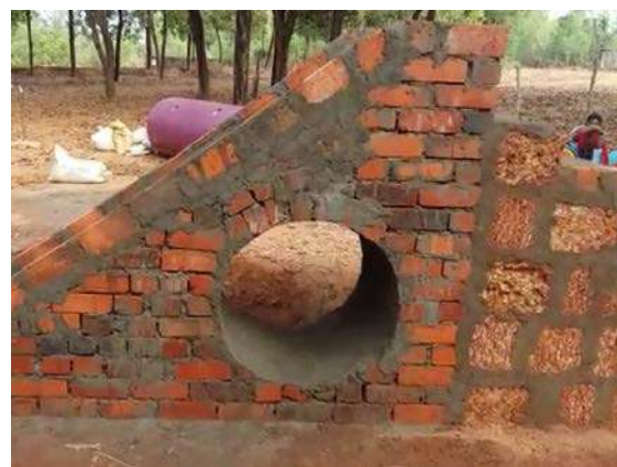
Ilustración 146: Estructura de tobogán y escalera de acceso construida. Fuente: propia
