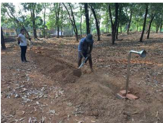
Ilustración 183: Enterrando el tubo PVC. Fuente: propia
