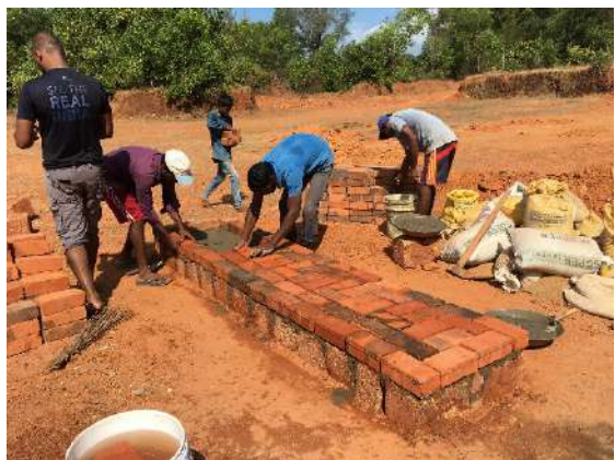
Ilustración 264: Construcción de la base del tobogán. Fuente: propia
