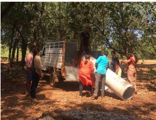
Ilustración 124: Descargando los tubos de hormigón para la canalización del kindergarten. Fuente: propia
