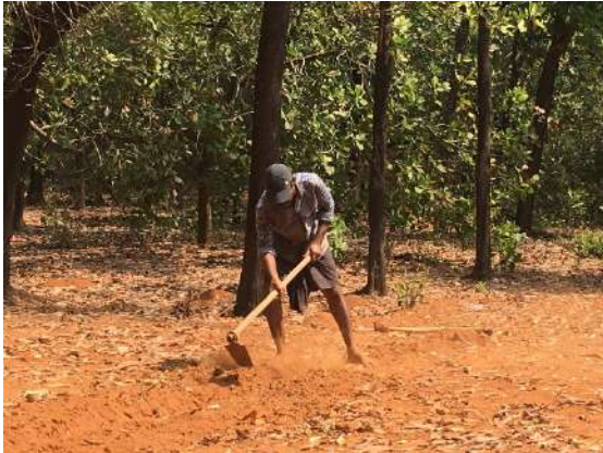
Ilustración 179: Excavando la zanja para la instalación del Speaking phone. Fuente: propia
