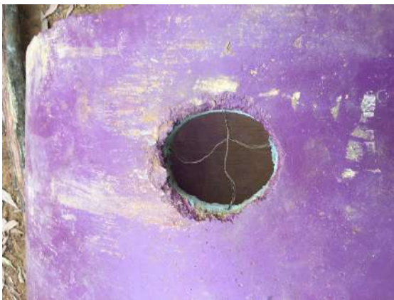
Ilustración 195: Detalle de una perforación en el túnel de hormigón. Fuente: propia
