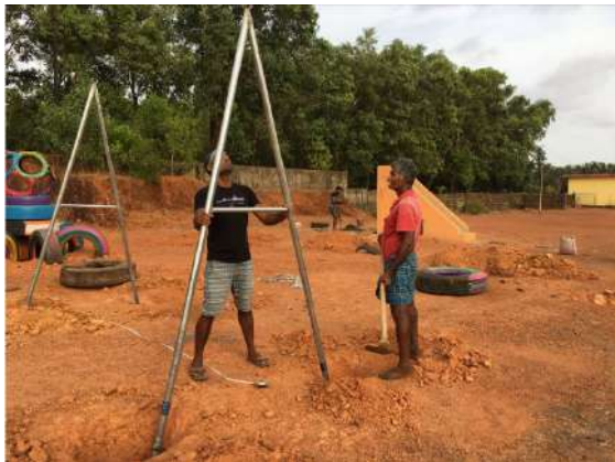
Ilustración 254: Instalación laterales de columpio. Fuente: propia
