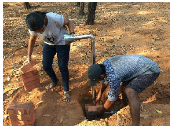
Ilustración 182: Anushree y Chandra colocando una estructura de ladrillos alrededor del tubo. Fuente: propia
