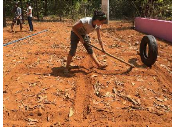
Ilustración 139: Marcando las dimensiones de la zanja para las Ruedas saltarinas. Fuente: propia
