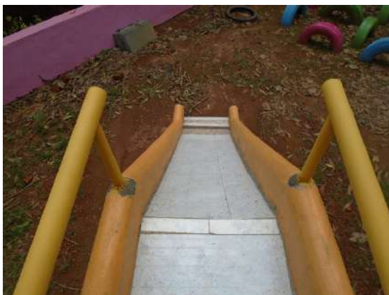
Ilustración 157: Detalle barandilla y deslizadera. Fuente: propia
