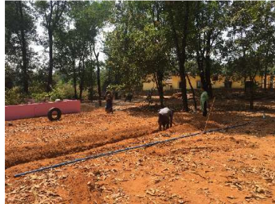
Ilustración 180: Excavando la zanja para la instalación del Speaking phone. Fuente: propia
