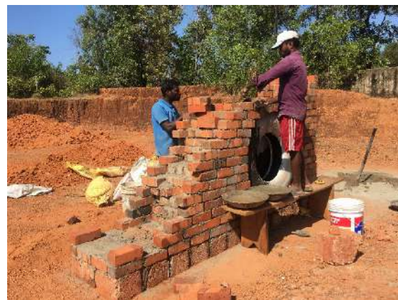
Ilustración 265: Construcción estructura con rueda para el túnel. Fuente: propia
