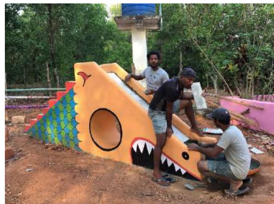
Ilustración 152: Hermanos Poojari colocando las baldosas deslizantes. Fuente: propia
