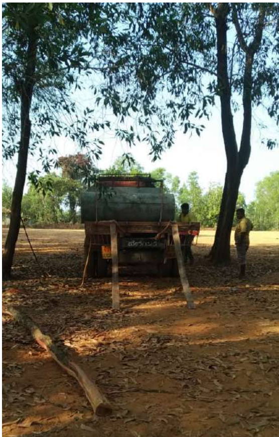
Ilustración 192: Proceso de descarga del tubo de hormigón en Kindergarten. Fuente: propia
