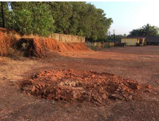
Ilustración 126: Escavación realizada por la máquina para la colocación del elemento octopus. Fuente: propia
