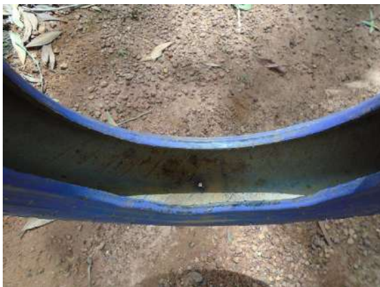
Ilustración 224: Detalle perforación para drenaje. Fuente: propia
