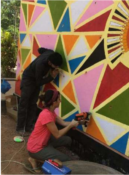
Ilustración 305: Proceso de taladrado y soplido de perforaciones. Fuente: propia
