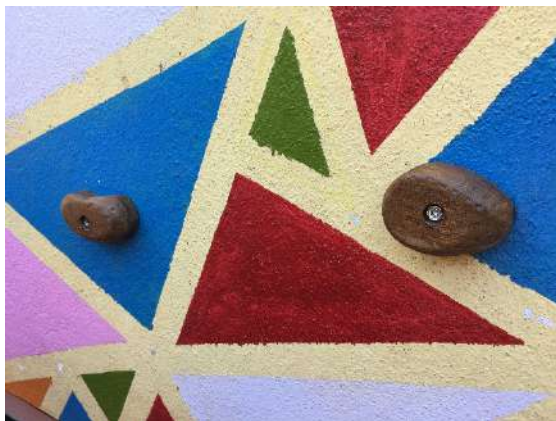
Ilustración 308: Detalle presas instaladas. Fuente: propia
