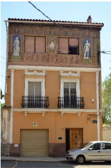
Fig. 1: Fachada de la casa.
