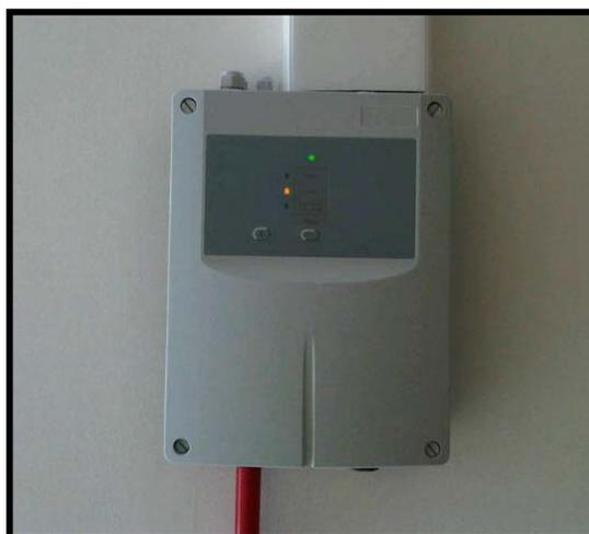
Figura 48: Sistema detección aspiración.
