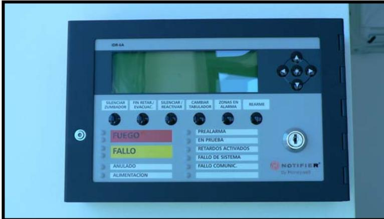
Figura 3: Repetidor
