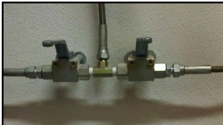
**Figura 37: Válvulas de corte gases FE-13.**
