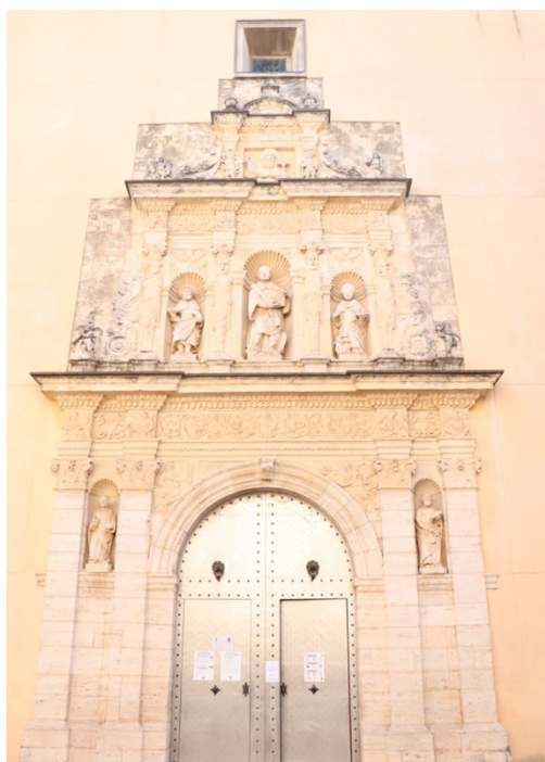
Figura 34. General de la fachada renacentista
