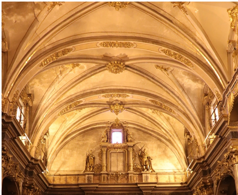
Figura 29. Vista general de los arcos de la bóveda.
