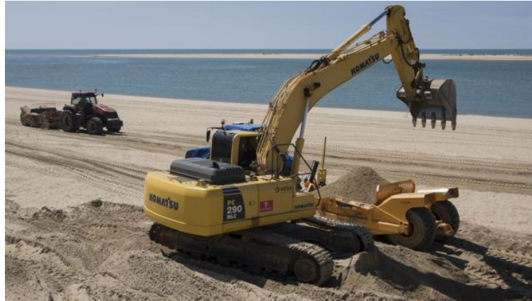
Figura 70. Maquinaria para extensión de arena.
