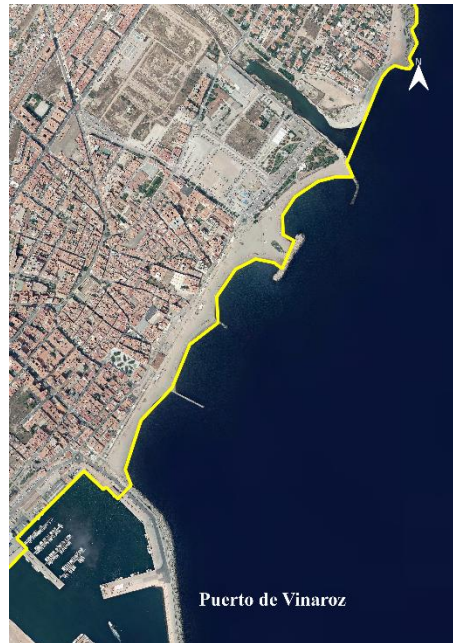
Figura 87. Obras de defensa en la zona de Vinaroz. Fuente: PNOA (2020).
