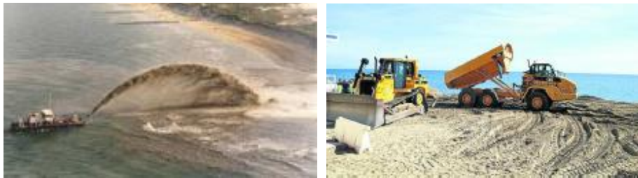
Figura 71. Vertido y extensión de arena.
