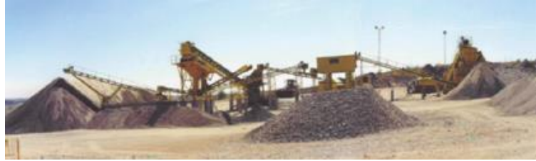
Figura 93. Vista general de una planta de reciclado de escombros.
