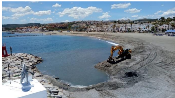
Figura 84. Ejemplo de trasvase por vía terrestre.
