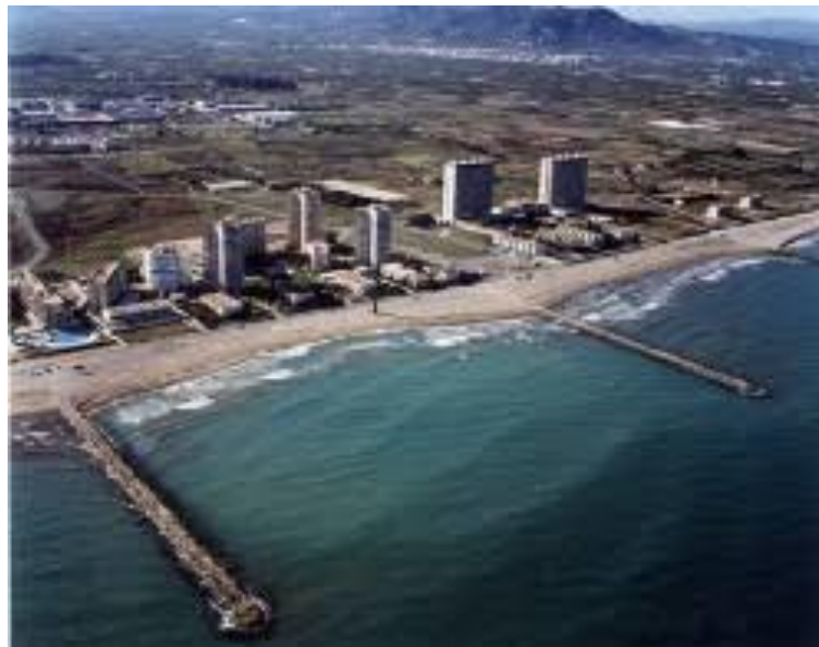
Figura 86. Ejemplo de obras de defensa en El Puig.
