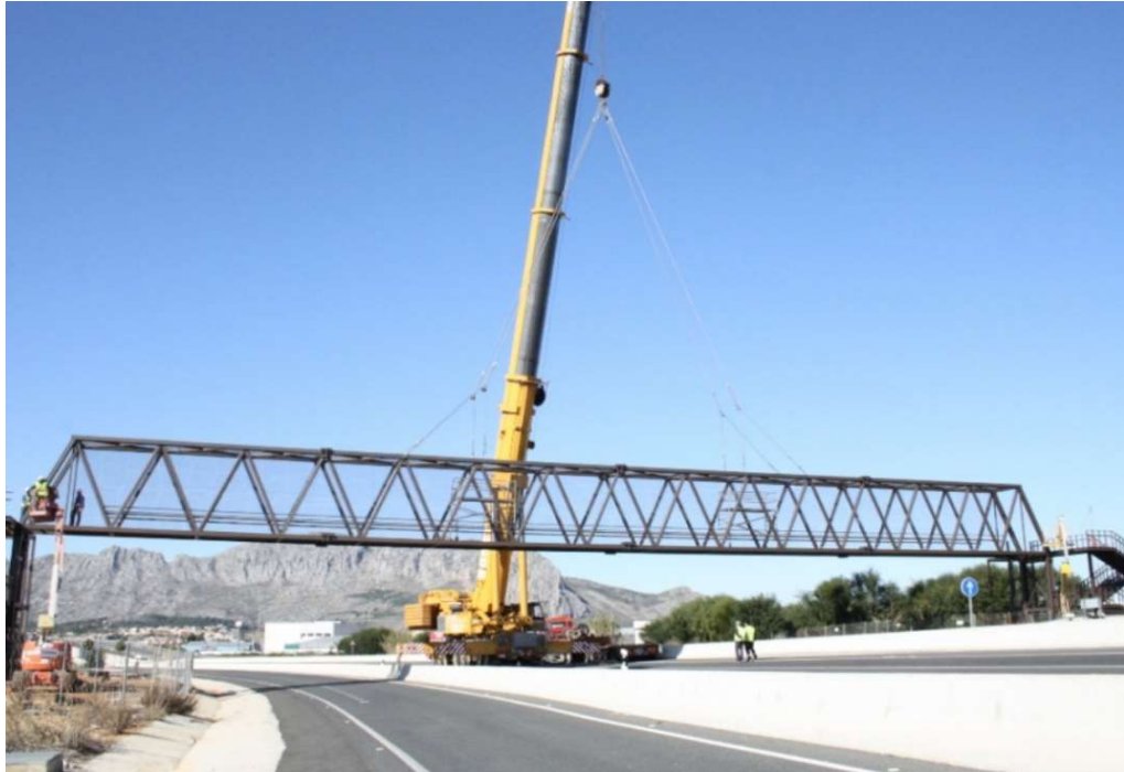
Pasarela metálica peatonal en Ondara (Alicante).
