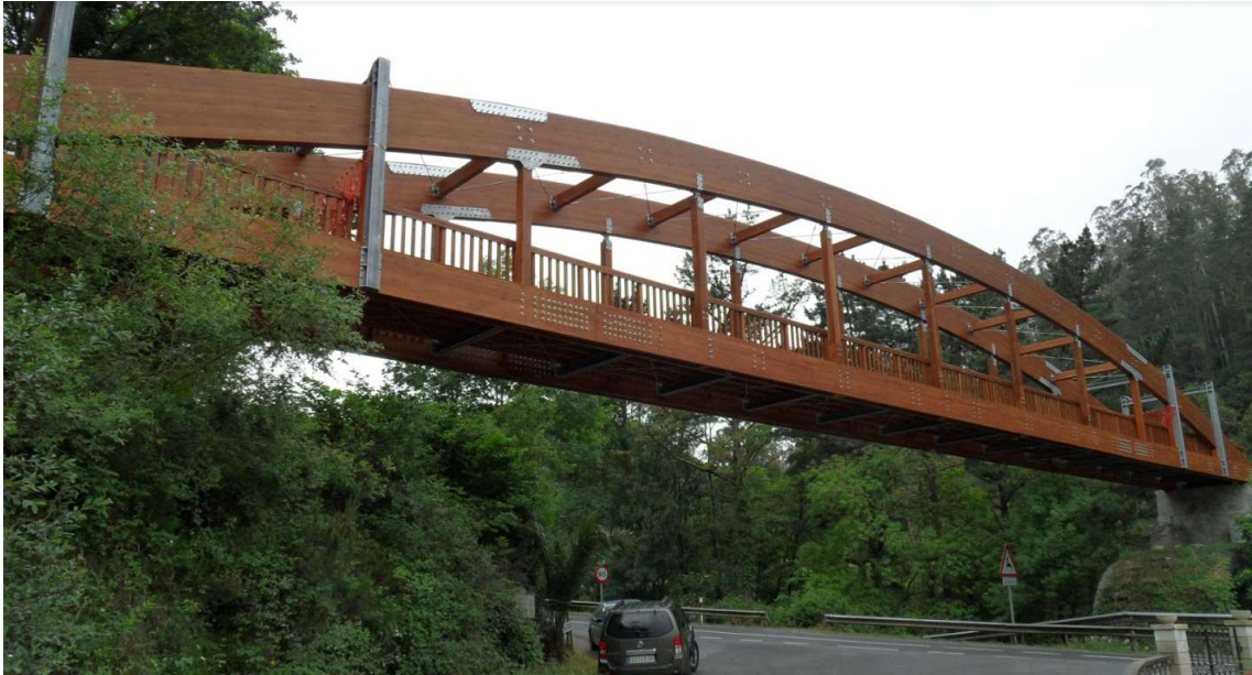
Pasarela sobre la carretera BI-2701 en Sopuerta-Galdames, Vizcaya
