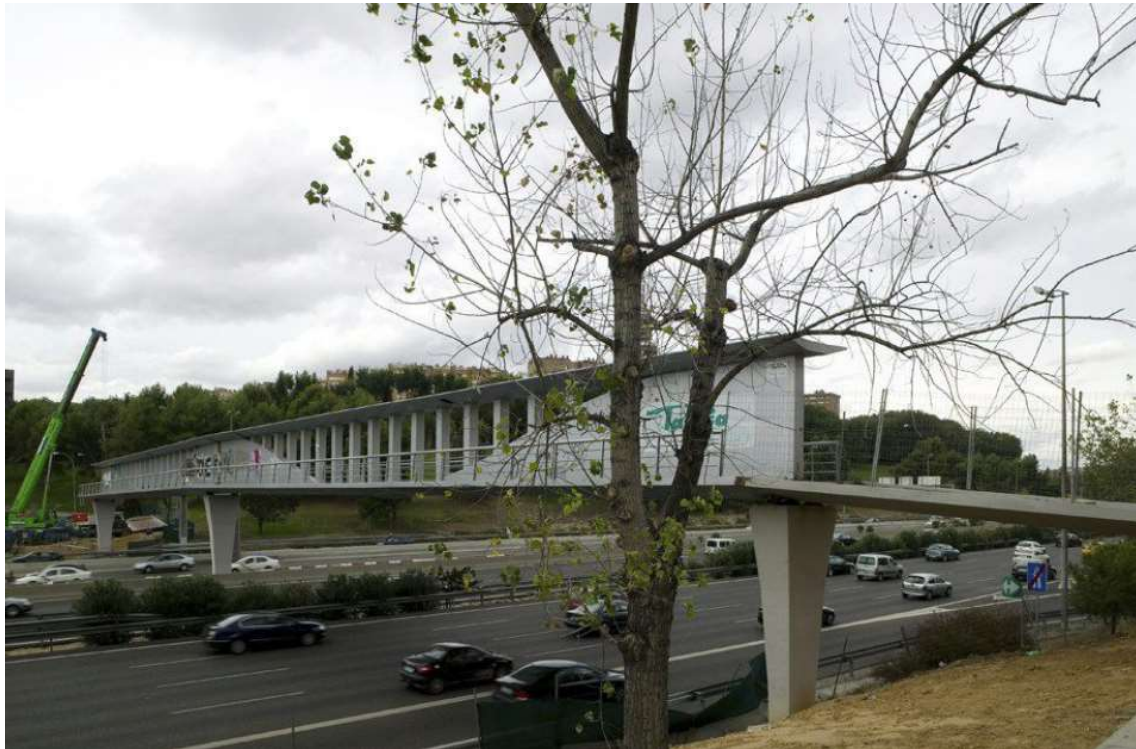
Pasarela sobre la M-30, Madrid
