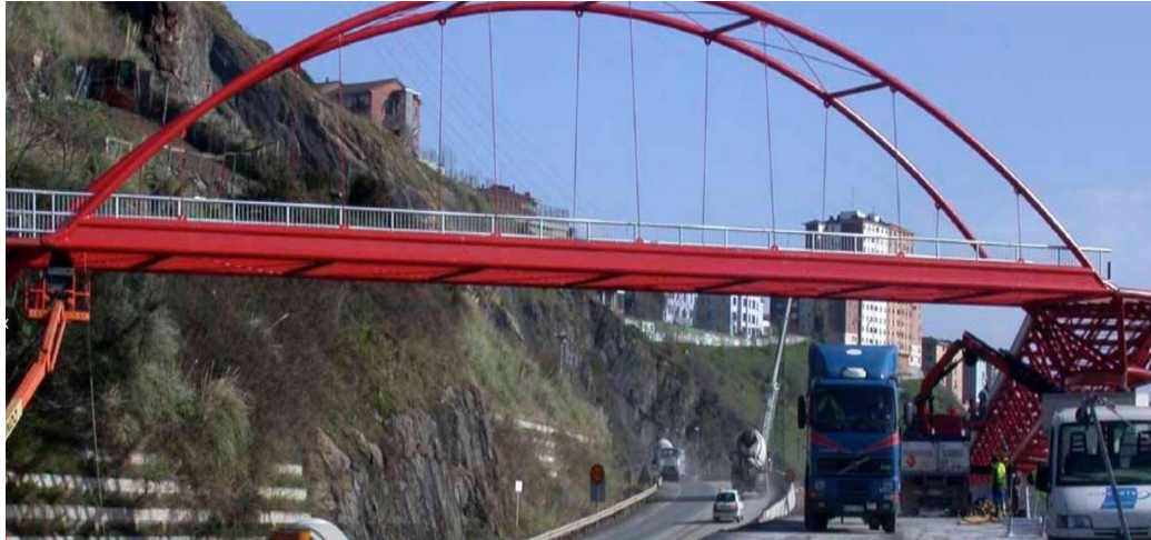
Pasarela metálica peatonal en Bilbao
