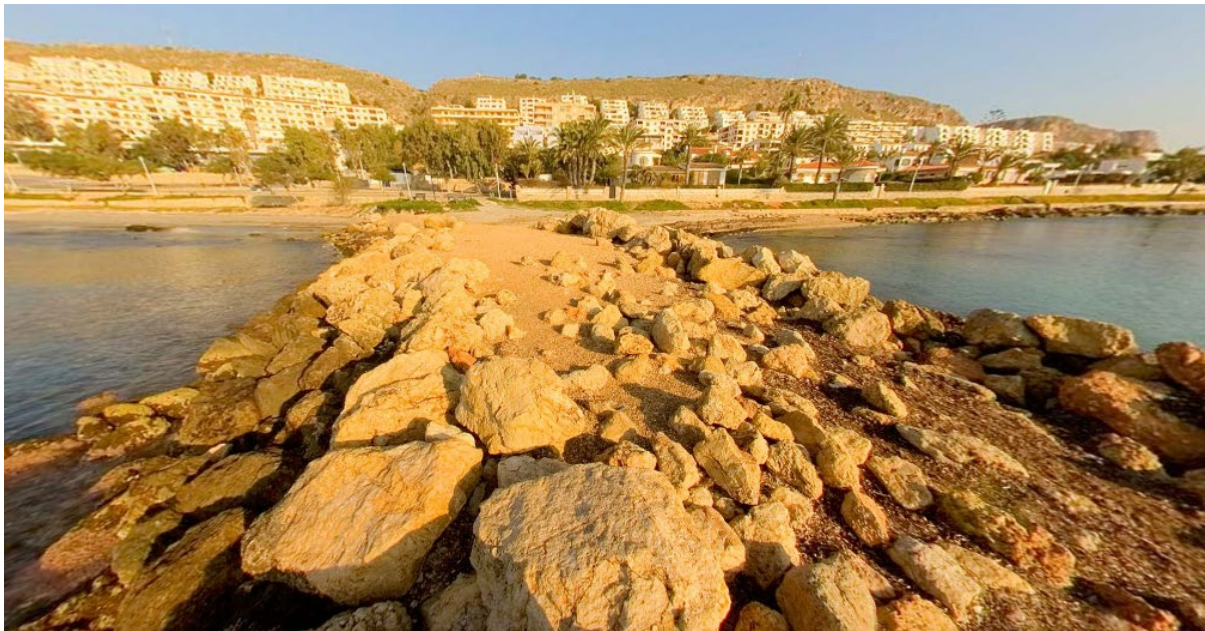
Il·lustració 126: Peces de escollera de un espigón Fuente: Elaboración propia.
