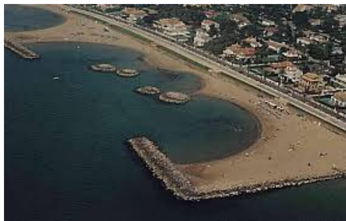
Ilustración 74: Imagen isla. Fuente: Asignatura Obras marítimas.
