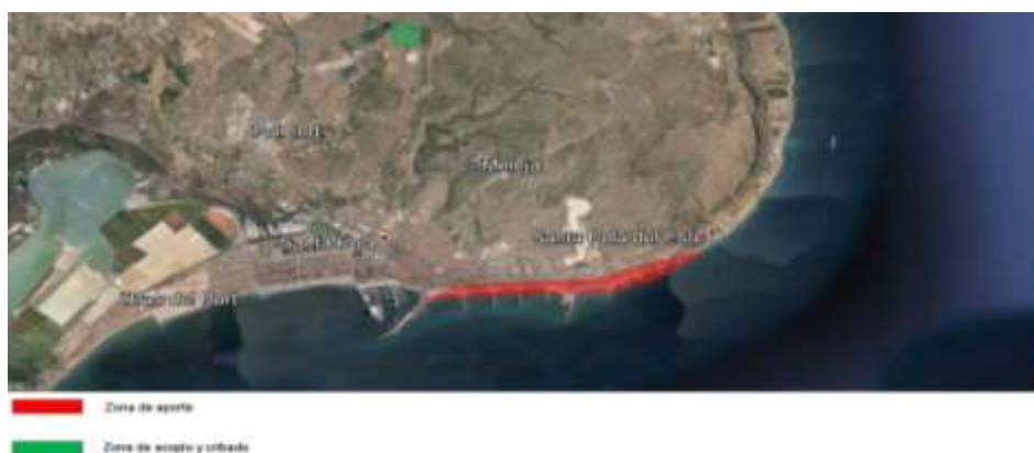
Ilustración 7: Zona de actuación. Fuente: Ministerio de Fomento.
