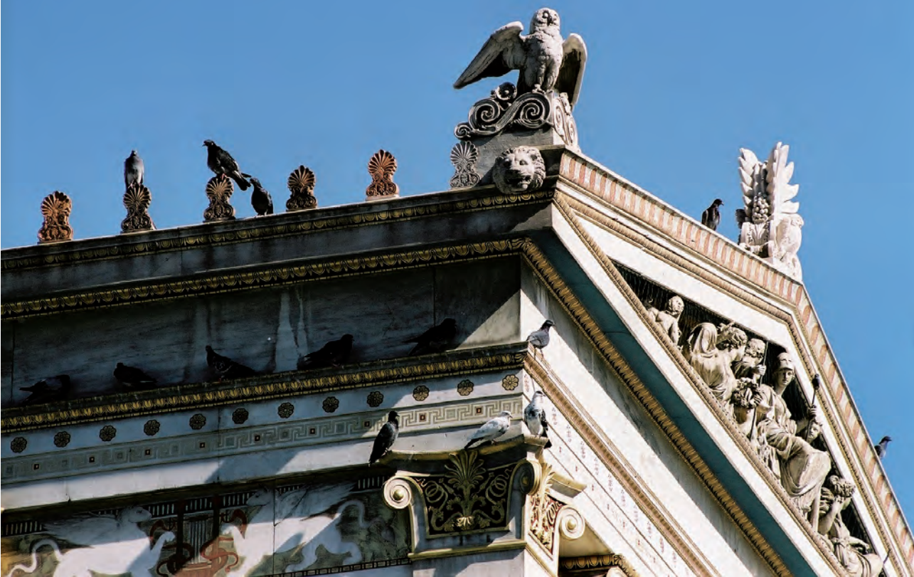
Figura 5. Fachada de la Academia de las Artes de Atenas, diseñada por Theofil Hansen y completada en 1887, Grecia.
