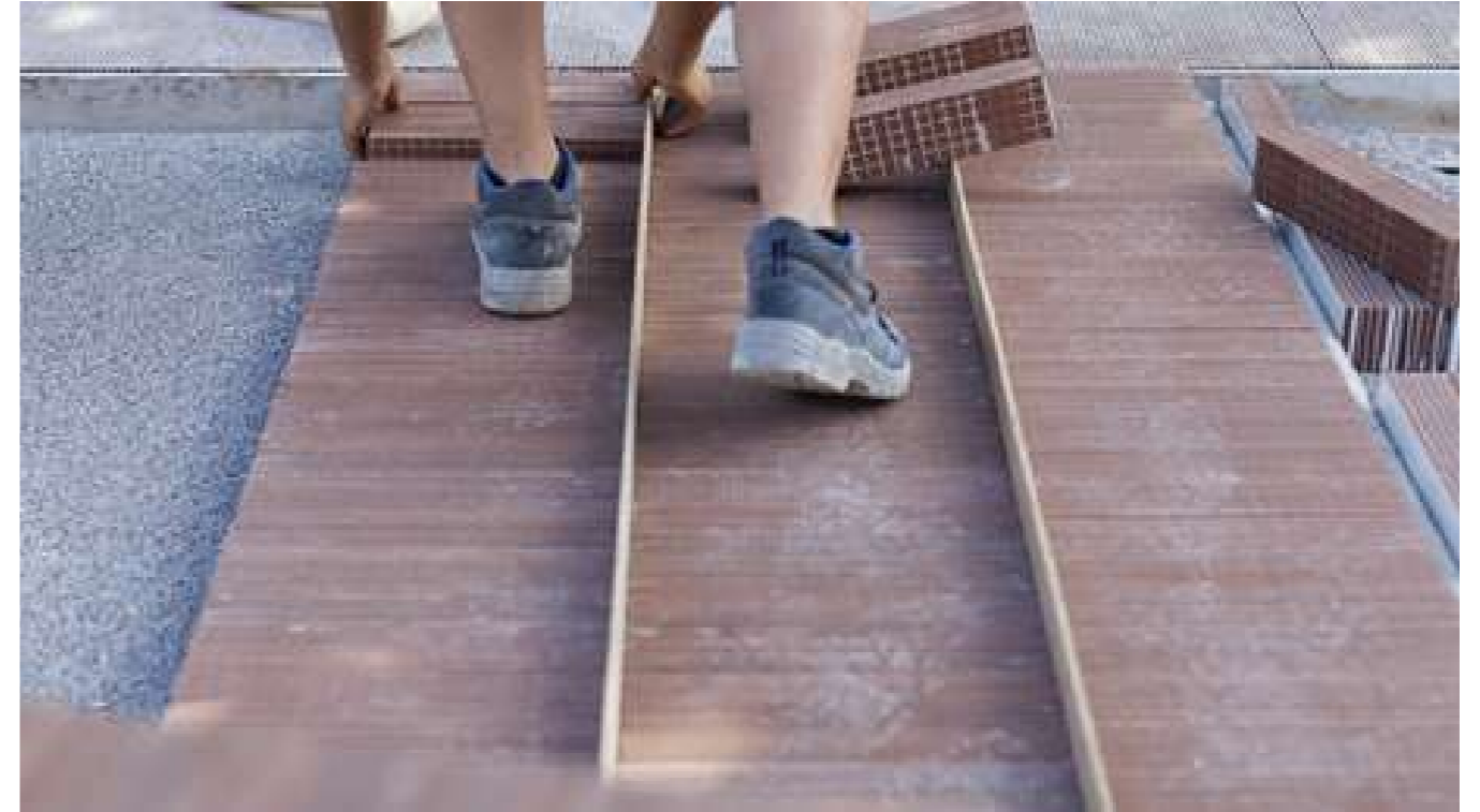
img.90 Detalles del proyecto LifeCerSuds de Benicasim (Castellón) 1. Encuentro del pavimento cerámico con un alcorque | 2. Puesta en obra de los módulos cerámicos [Arquitectos: Eduardo de Miguel y Enrique Fernández-Vivancos]
