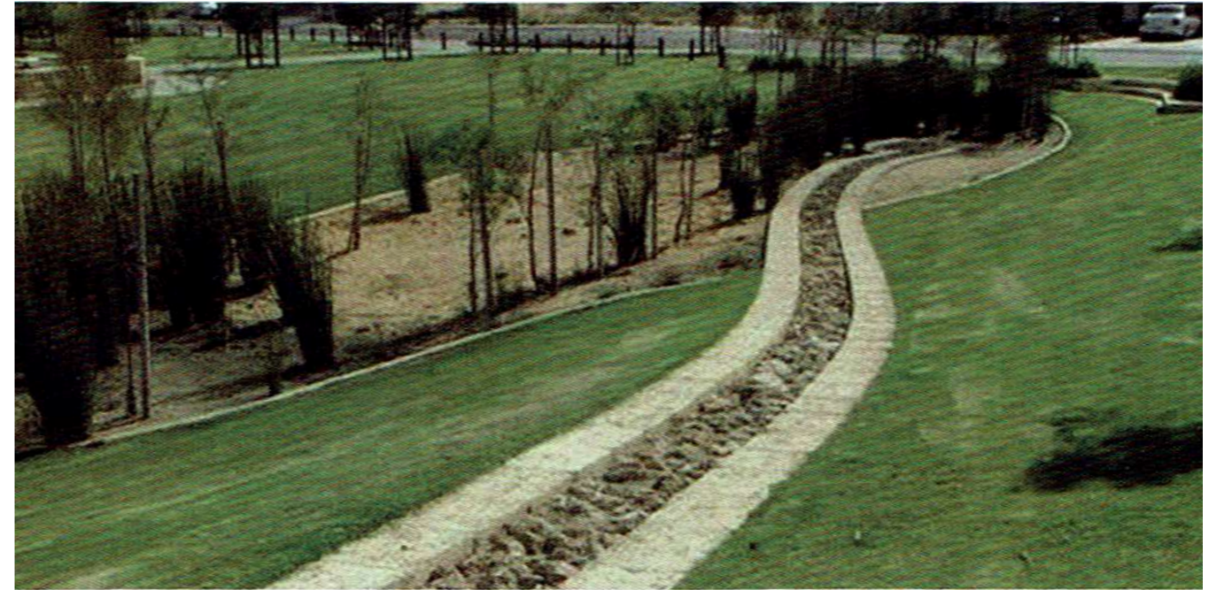
img.77 Dren filtrante Parque en Alcantarilla (Murcia) [Estudio arquitectura: Viviendo gota a gota, 2016]
