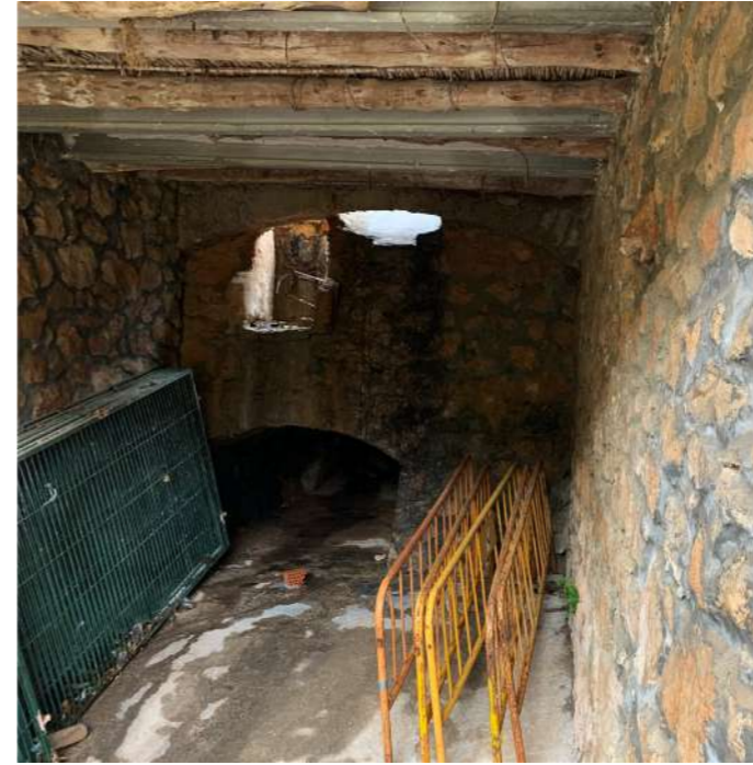
img.79 Desembocadura de la canalización del barranco suburbano a la altura del lavadero. 1. Inicio canalización del barranco | 2. Puerta metálica entrada al barranco | 2. Interior del final de la canalización del barranco | 3. Rejilla de cierre en la calle acequia [Fotografías propias, 2020]
