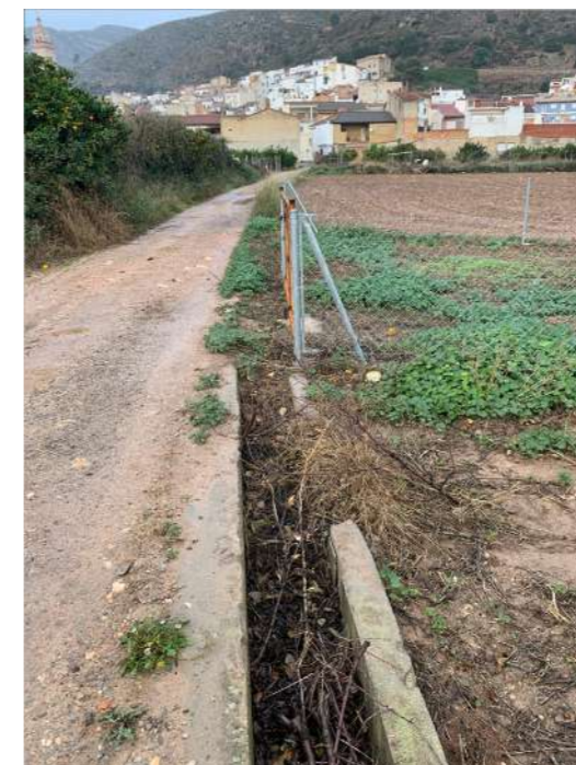
img.84 Estado actual de las acequias de la huerta del lugar, en desuso y con la presencia de la instalación de riego por goteo [Fotografías propias, 2020]
