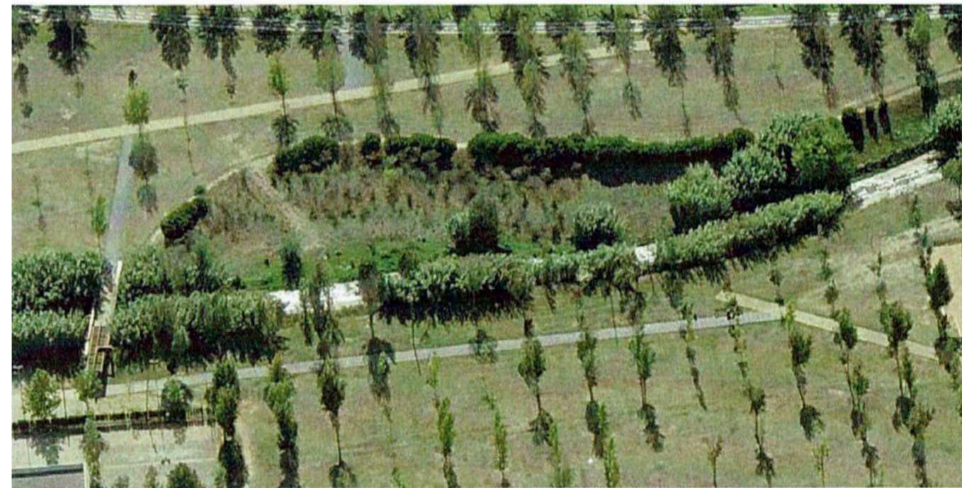
img.78 Depósitos de detención del Parque de La Riera, Viladecans (Barcelona) [Arquitectos: Batlle i Roig]
