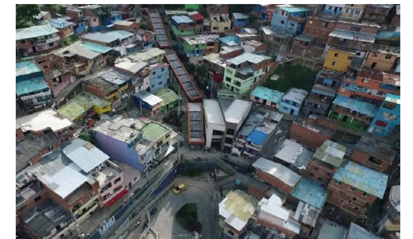
Inicio escaleras eléctricas Comuna 13
