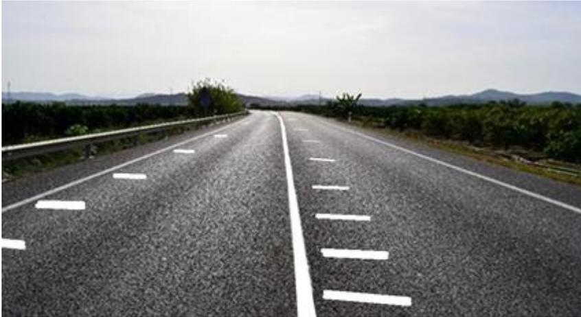
**Figura XX: Ejemplo. Marcas transversales de alerta en la parte interior de los carriles
