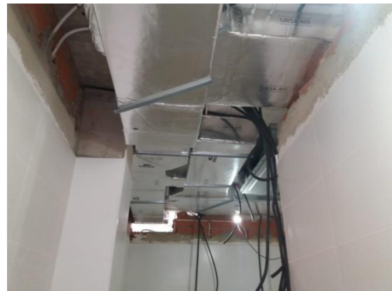
Figura 26_ Zona donde se ubican las rejillas de ventilación (vista interior y exterior del edificio)
