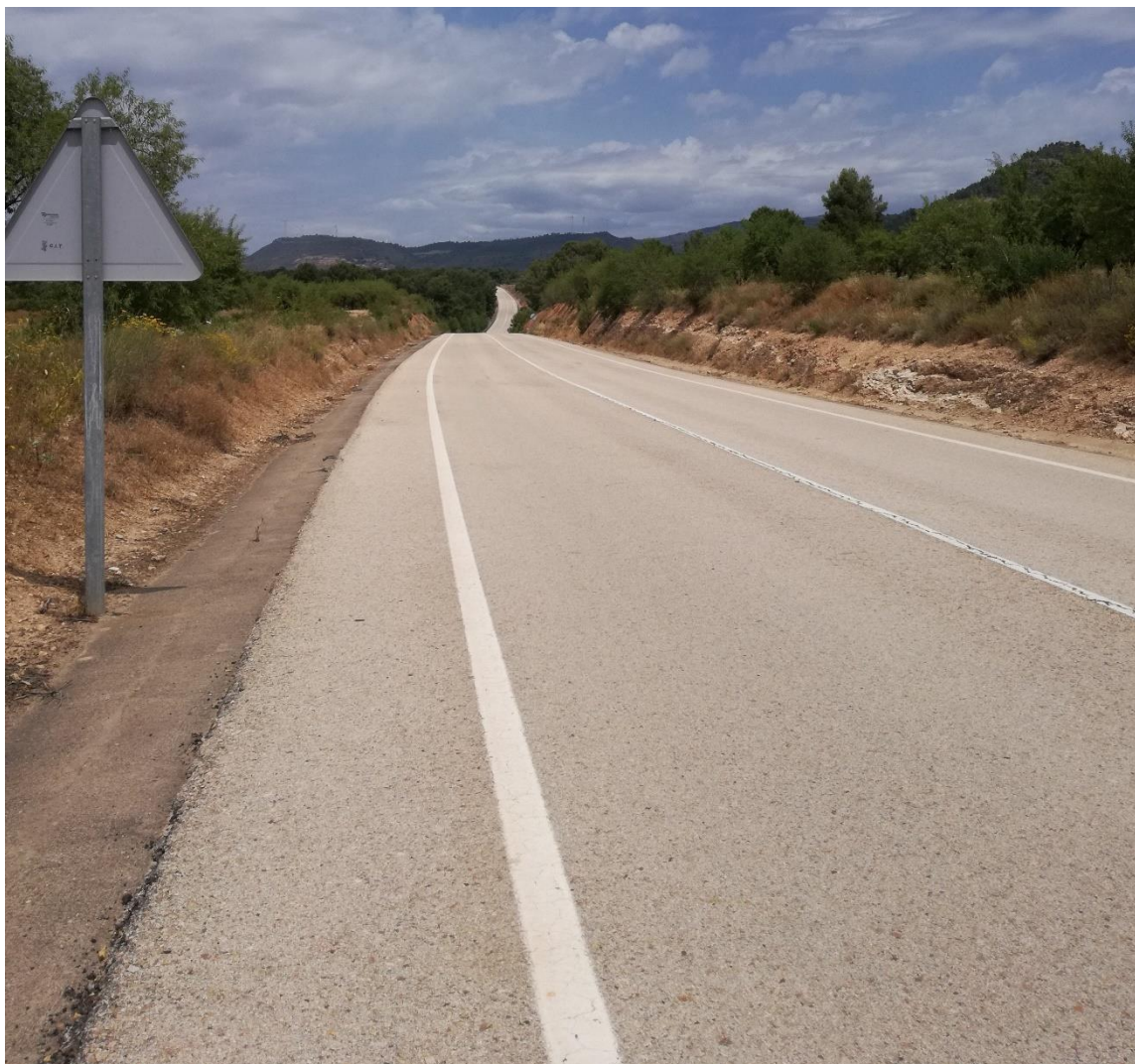
Figura 34: Tramo de la carretera CV-35 de reciente construcción. (Fuente: Elaboración propia)
