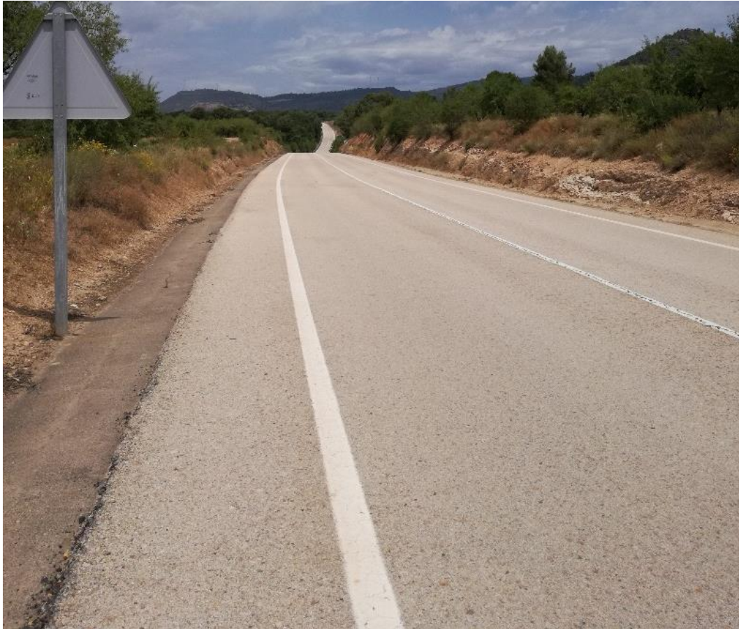
Figura 9: Tramo de la carretera CV-35 de reciente construcción. (Fuente: Elaboración propia)
