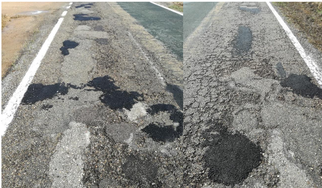
Figura 8: Reparación del firme mediante parcheado sobre el PK 6+700 del tramo. (Fuente: Elaboración propia)
