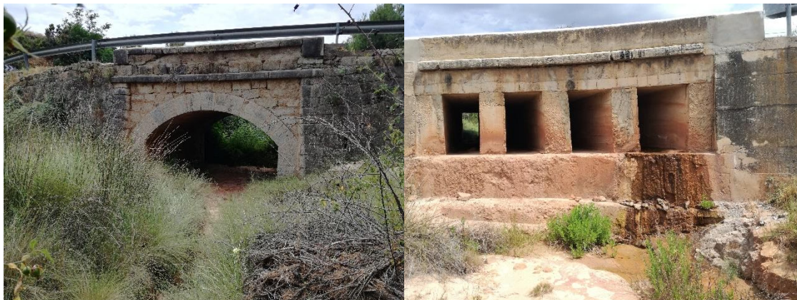
Figura 19: ODT barranco de la Tejería (Izquierda) y de las Tejerías (Derecha). (Fuente: Elaboración propia.)
