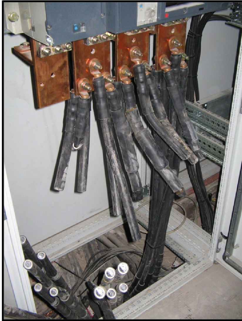
Fotografía 4. Cambio de cableado de cobre a aluminio.
