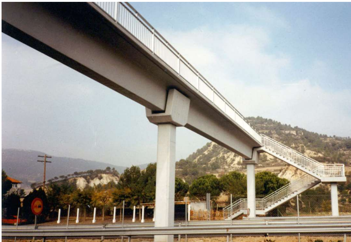
Pasarela con viga en T
