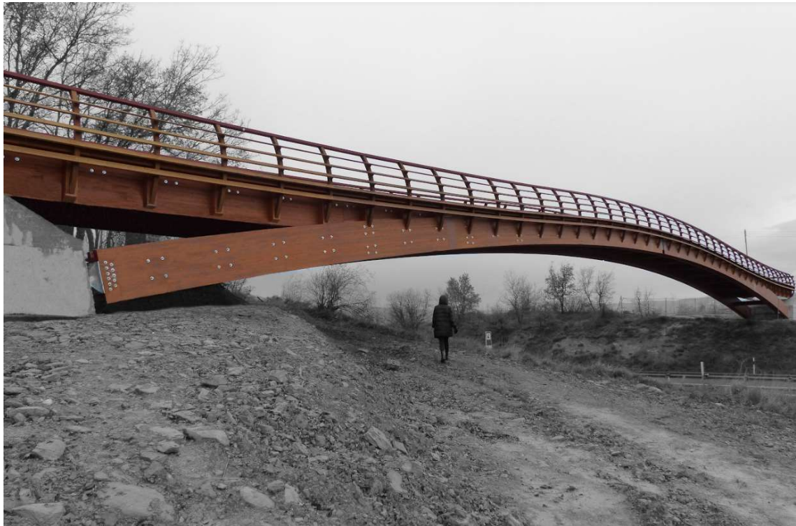
Pasarela peatonal sobre la carretera N-102 a su paso por vitoria
