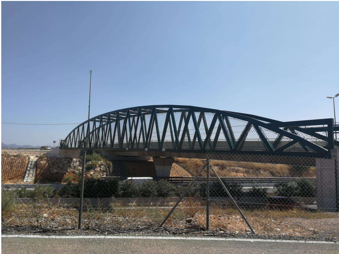
Pasarela sobre CV-35, Valencia
