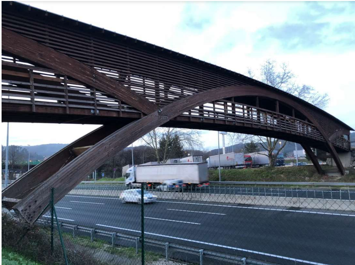
Pasarela sobre la autovía A8 a su paso por Amorebieta (Vizcaya)
