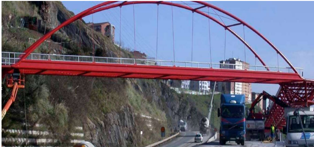
Pasarela metálica peatonal en Bilbao
