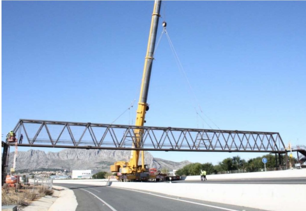
Pasarela metálica peatonal en Ondara (Alicante).
