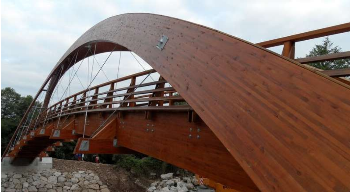
Pasarela sobre Rio Saja
