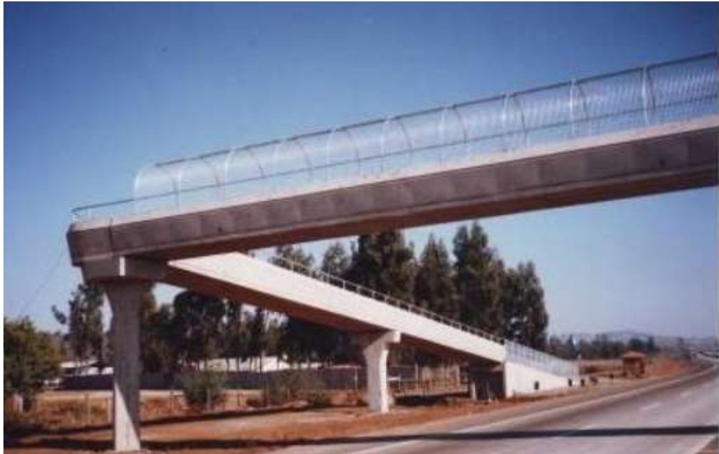
Pasarela viga cajón
