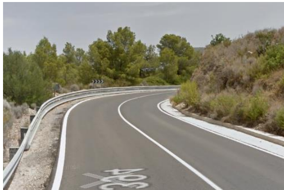
Figura 40 : Incumplimiento de visibilidad necesaria en el P.K. 1+420
