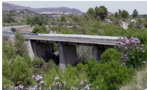
Figura 57 : Puente de la CV-394 (Google Maps)
