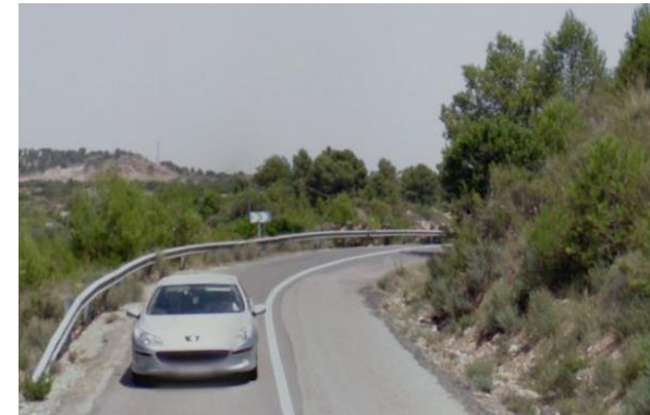
Figura 42: Incumplimiento de visibilidad necesaria en el P.K. 2+315
