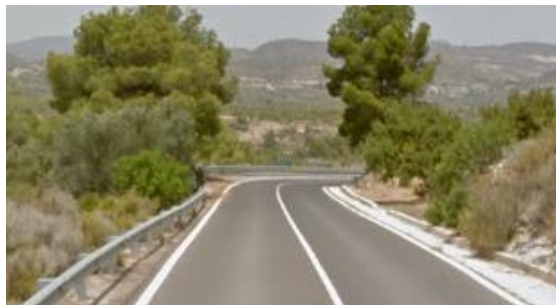
Figura 16: Fotografía del tramo II (Google Maps)
