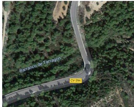
Figura 56: Vista aérea del puente de la CV-394 (Google Maps)
