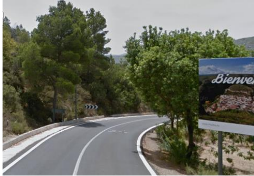
Figura 39 : Incumplimiento de visibilidad necesaria en el P.K. 0+940
