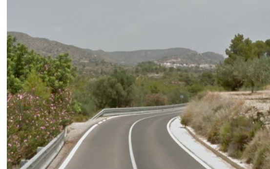
Figura 41: Incumplimiento de visibilidad necesaria en el P.K. 2+694
