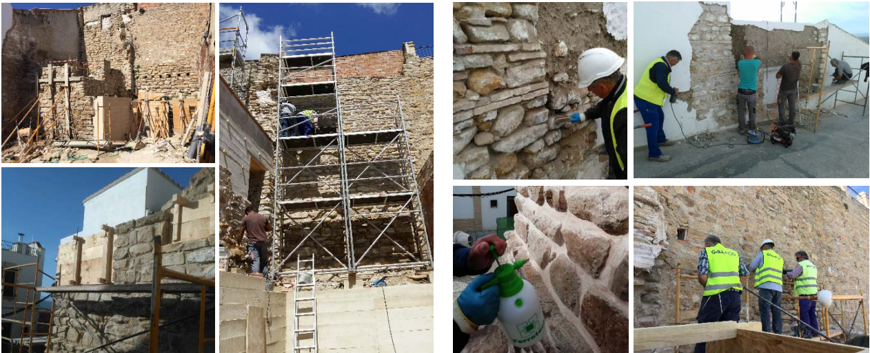
Fig. 4 Trabajos de consolidación estructural (izquierda) y de restauración paramental (derecha)
