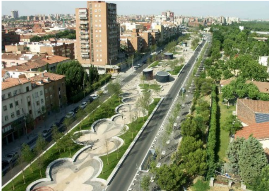
Ilustración 86- Madrid Río, sistema peatonal
