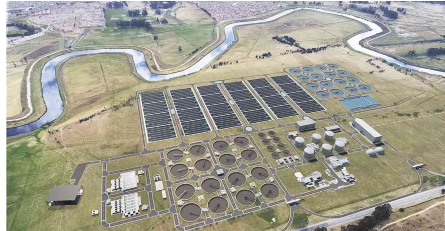
Ilustración 20 - Planta de Tratamiento de Aguas Residuales - PTAR SALITRE
