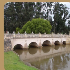
RPC 24- PUENTE DEL COMUN
