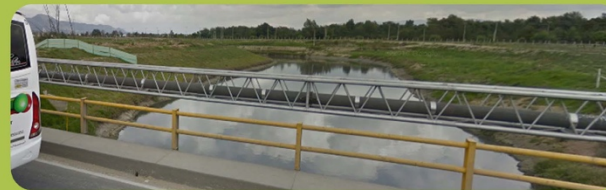
RP.V 24- AUTOPISTA MEDELLÍN - CARRETERA ESCENOGR
