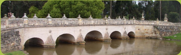
RP.V 15- PUENTE DEL COMÚN -RV- HITO ARTIFICIAL
