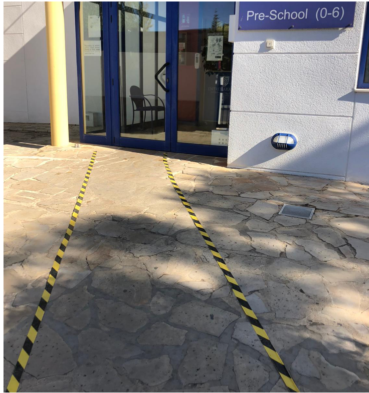
Ilustración 3. Entrada. Encaminamientos. Imagen propia
