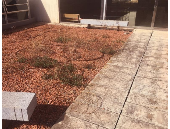
Imagen 33. Fotografía general de la cubierta 3. Elaboración propia
