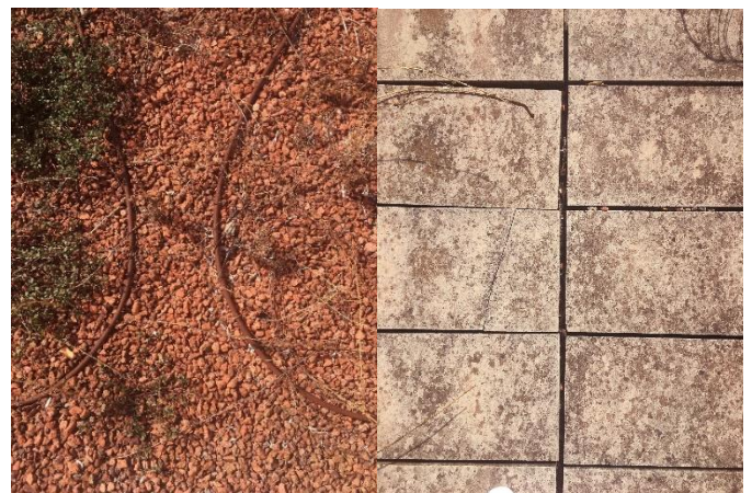
Imagen 34. Fotografías de detalle de la cubierta 3. A la izquierda, zona de grava y a la derecha zona pavimentada de piedra de color beige. Elaboración propia
