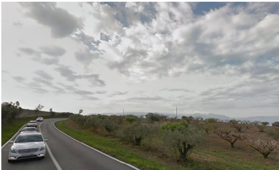
Foto 2. Vista del punto de la carretera B – 224 en el que está prevista la construcción del paso de fauna, en el P.K 21+250, dirección Martorell
