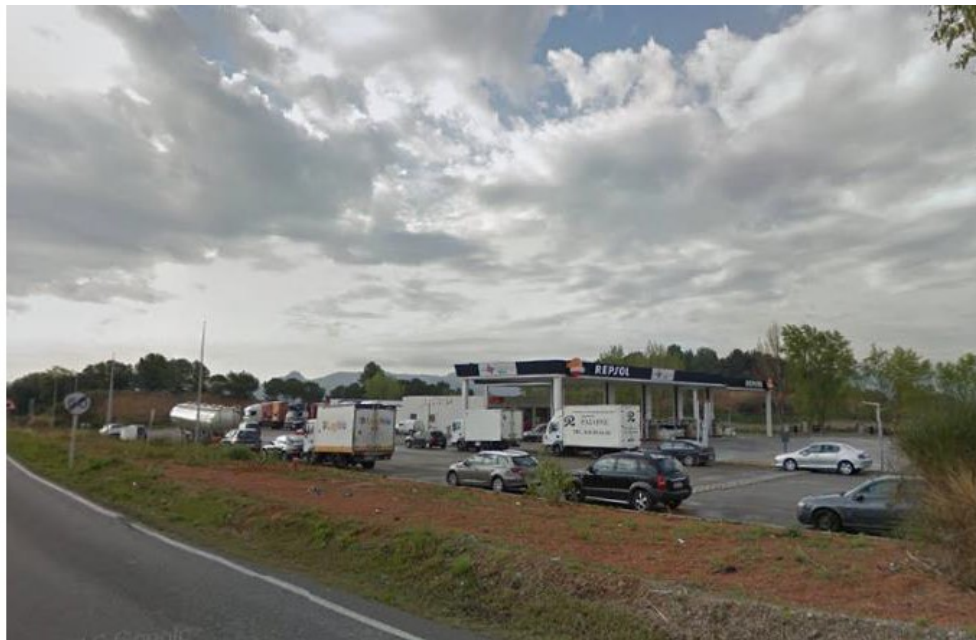
Foto 6. Vista del Área de Servicio Repsol en dirección hacia Martorell. Esta y otras áreas de servicio situadas en la zona de estudio, se encuentran incluidas también dentro de la Unidad Geotécnica RT, constituida por rellenos de origen antrópico bajo una capa de pavimento asfáltico o de hormigón
