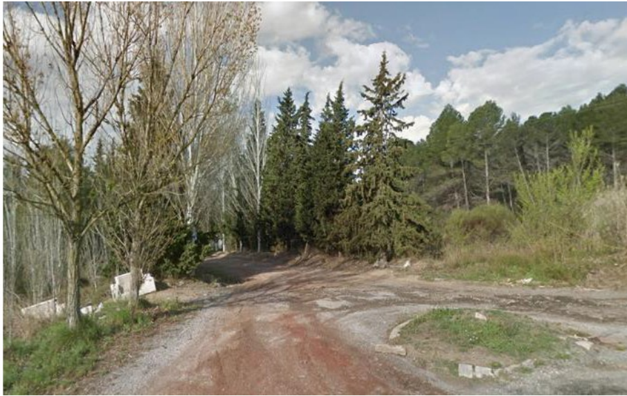
Foto 13. Vista del mismo enlace de la Beguda Baixa a mano izquierda, dirección Capellades. En esta imagen se aprecia mejor la rotonda que se está construyendo para el nuevo enlace
