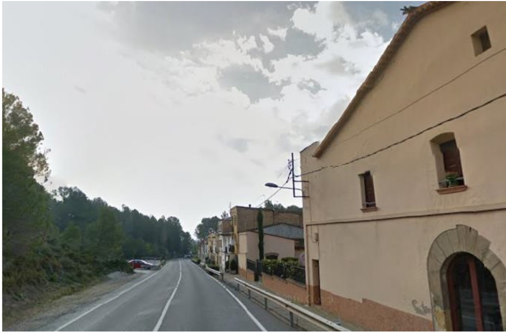
Foto 3. Vista del municipio de la Beguda Baixa atravesado por la actual B – 224, concretamente en el P.K 19+380, dirección Martorell. Corresponde a una de las áreas urbanizadas englobadas en la zona de estudio dentro de la Unidad Geotécnica RT, de rellenos empleados en viales y edificaciones
