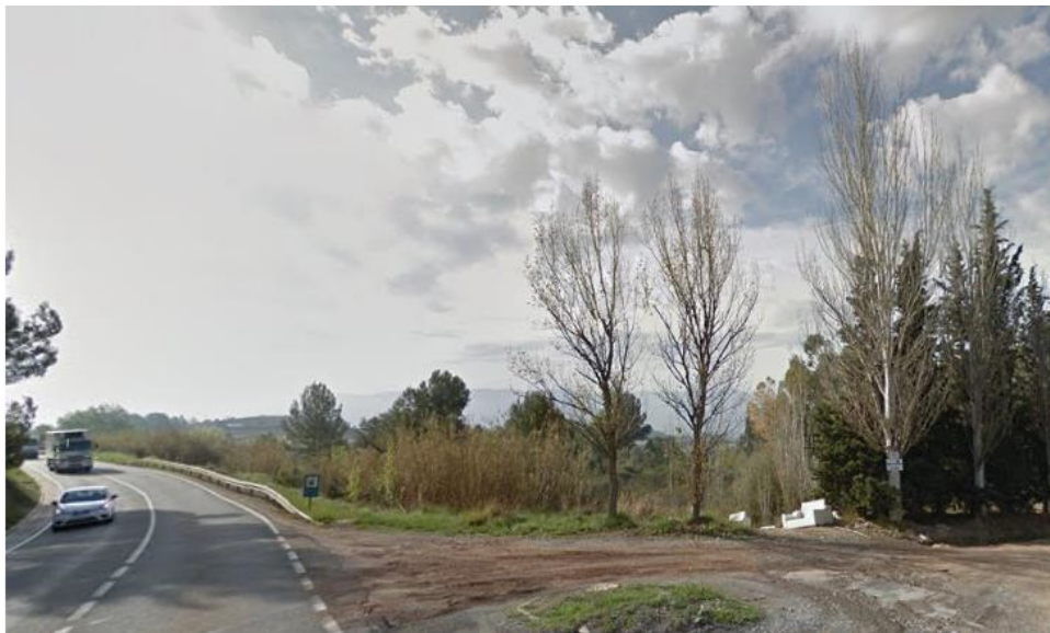
Foto 12. Vista del nuevo enlace en construcción, en la zona de la Beguda Baixa, concretamente en el P.K 19+800. Puede observarse en la imagen la actual incorporación a mano derecha, en dirección hacia Martorell
