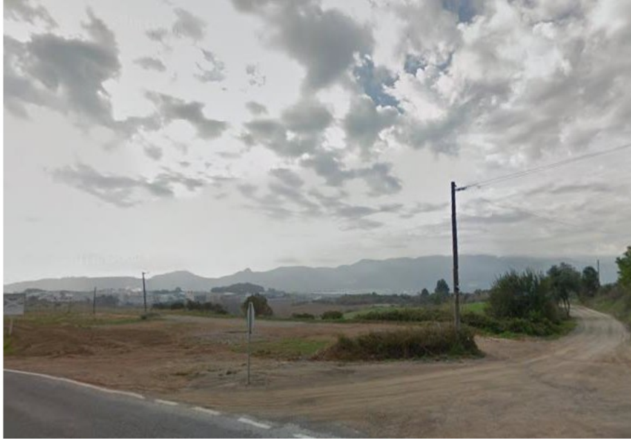
Foto 15. Vista de la incorporación de la actual carretera B – 224 a la nueva traza, en el P.K 21+550, dirección Martorell
