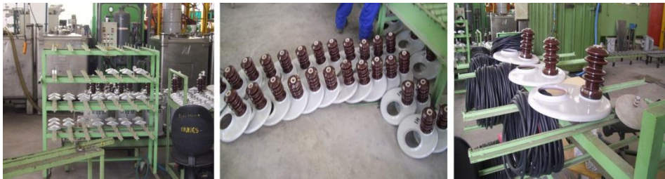
Figura 30. Montaje de las tapas
