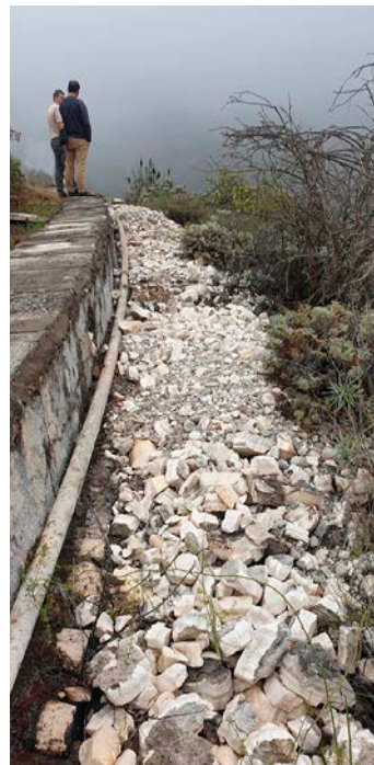
Fig. 1 Acumulación de restos petrificados Fig. 2 Obstrucción de conductos de agua
