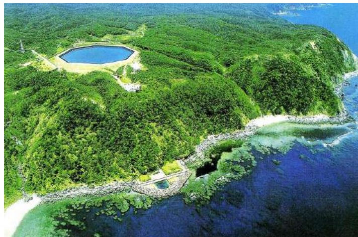
Figura 5-1: Imagen de la central hidráulica de bombeo de agua marina en Okinawa (Japón) [15].
