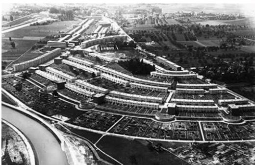
Figura 16. Vista aérea Siedlung Römerstadt, Frankfurt, Ernst May.
