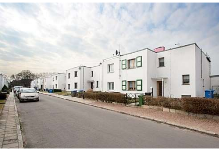
Figura 78. Fachada viviendas en hilera colonia de Törten, Dessau.
