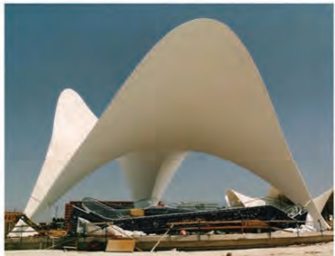
Cáscara de hormigón armado
