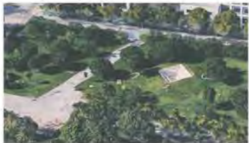
Acceso Cubierta Pirámide Invertida
