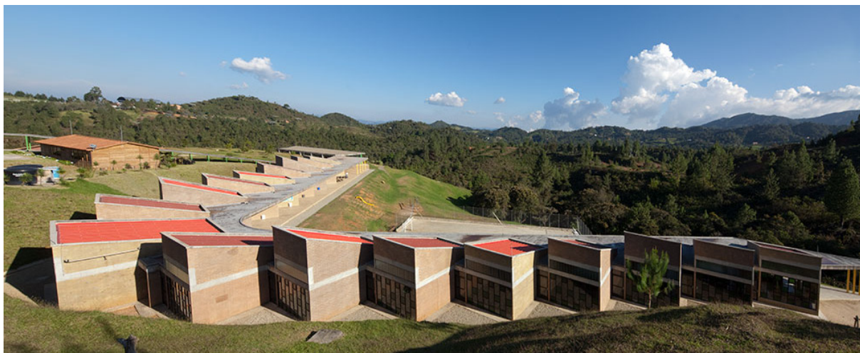
Fig. 9 Vista de l'escalonament del col·legi
