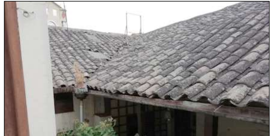
Imagen 35: Cubrición de Teja. Fuente: Elaboración propia
