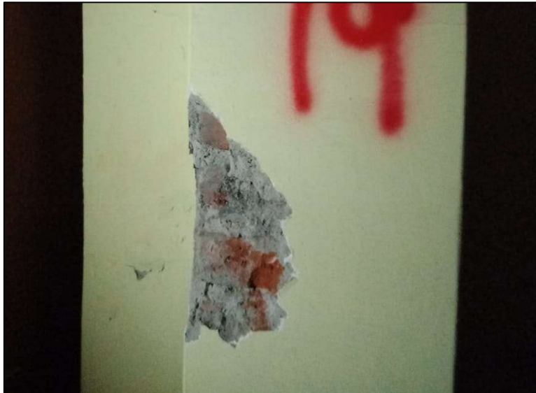
Imagen 56: Columnas de ladrillo. Fuente: Elaboración propia
