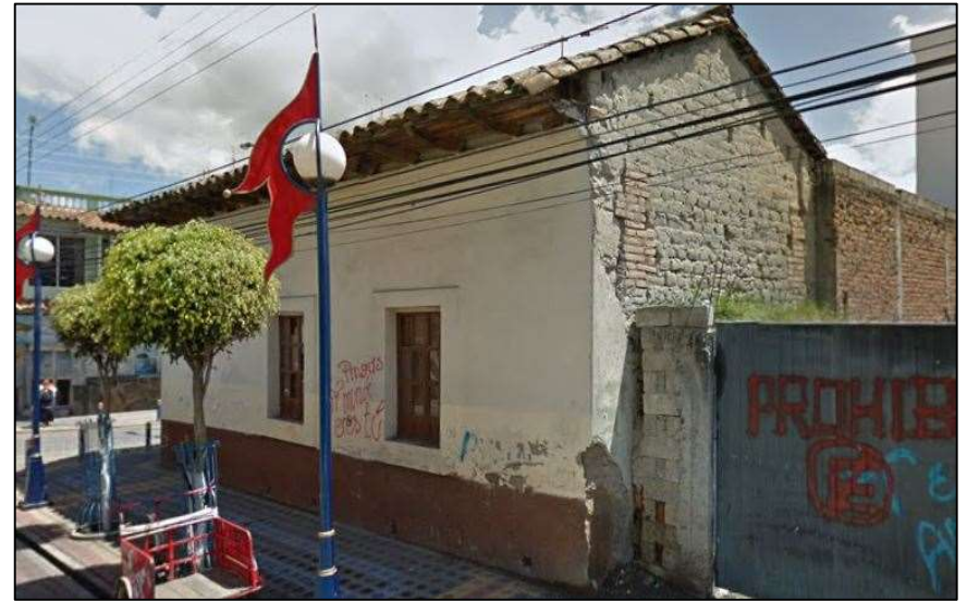
Imagen 32: Muro de adobe visto por la parte trasera de la parcela. Fuente: Elaboración propia
