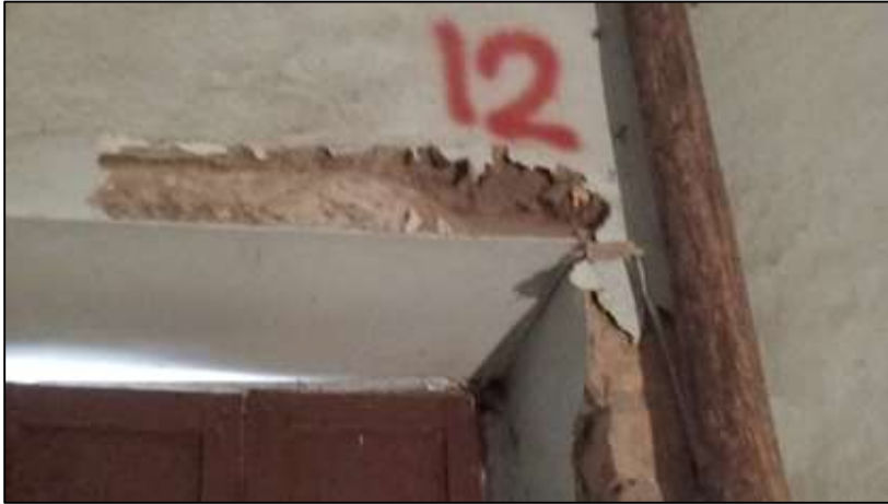
Imagen 53: Dintel de madera. Fuente: Elaboración propia
