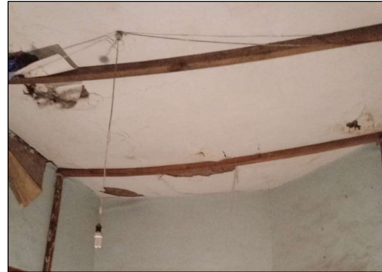
Imagen 60: Refuerzos en falso techo. Fuente: Elaboración propia
