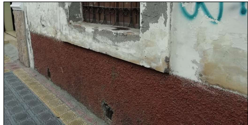
Imagen 38: Respiraderos vistos en zócalos de fachada. Fuente: Elaboración propia
