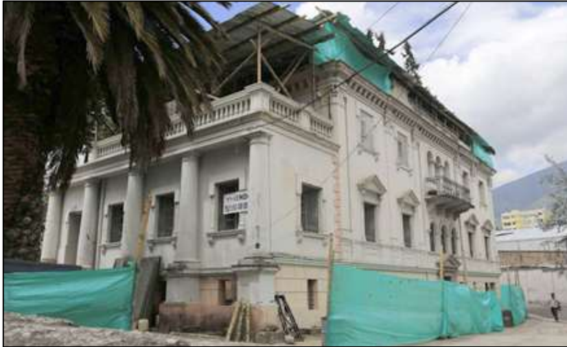
Imagen 17: Vivienda neocolonial en rehabilitación de Tulcán. Fuente: Elaboración propia.
