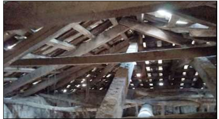
Imagen 34: Estructura de Cubierta de madera. Fuente: Elaboración propia
