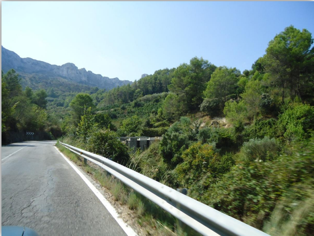
Foto 6. Puente que atraviesa el barranco de Vall de Gallinera
