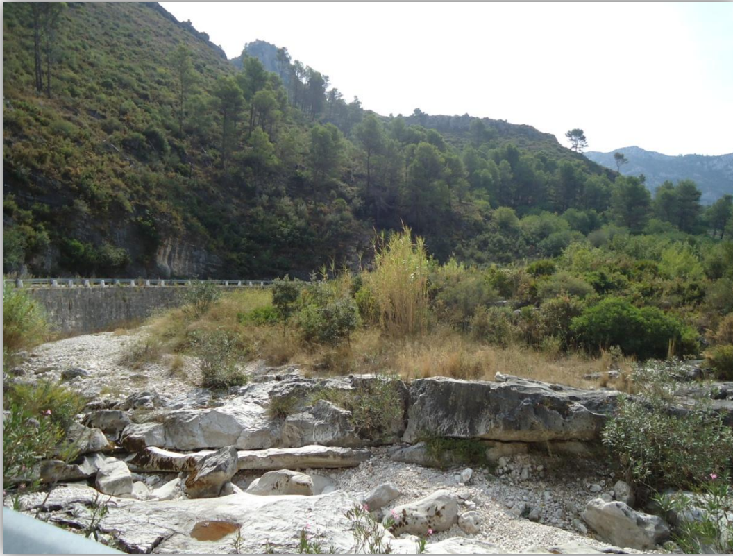
Foto 13. Vista de la rambla Vall de Gallinera al lado de la carretera CV-700
