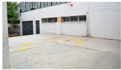
39 · Vista general de la zona 7.
