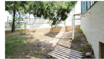
19 · Estructura metálica en zona verde.
