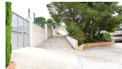
22 · Rampa de acceso a cota superior del patio trasero.
