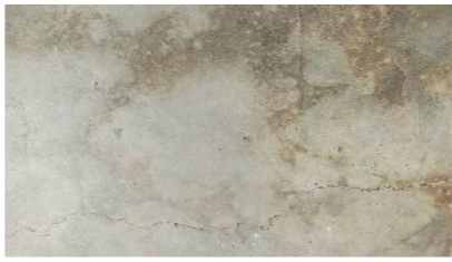
48 · Pavimento duro predominante en patio trasero.
