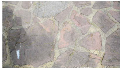
47 · Pavimento duro en caminos del patio delantero
