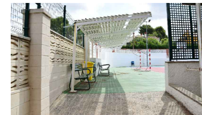
24 · Acceso a cota superior del patio trasero.
