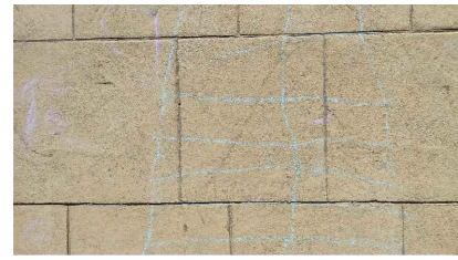
45 · Pavimento duro en zona de acceso a patio delantero.
