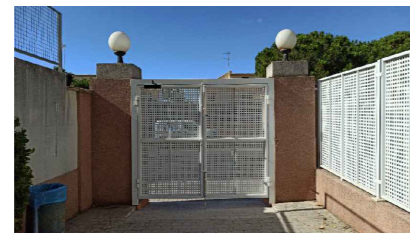
06 · Puerta de acceso bachillerato, desde interior del Centro.
