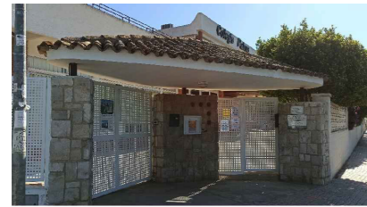
01 · Puerta de acceso principal, desde exterior del Centro.
