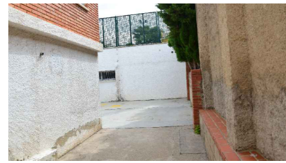
41 · Acceso a patio trasero desde zona exterior en desuso.
