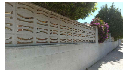
07 · Vallado en fachada oeste, desde vía de servicio.
