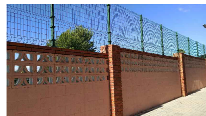
09 · Vallado en fachada este, Calle 604.
