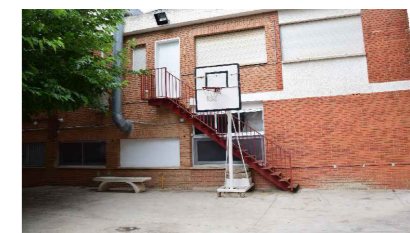
32 · Escalera exterior de acceso a edificación y canasta en zona 5.
