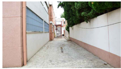
43 · Escalera exterior de acceso a edificación en zona en desuso.
