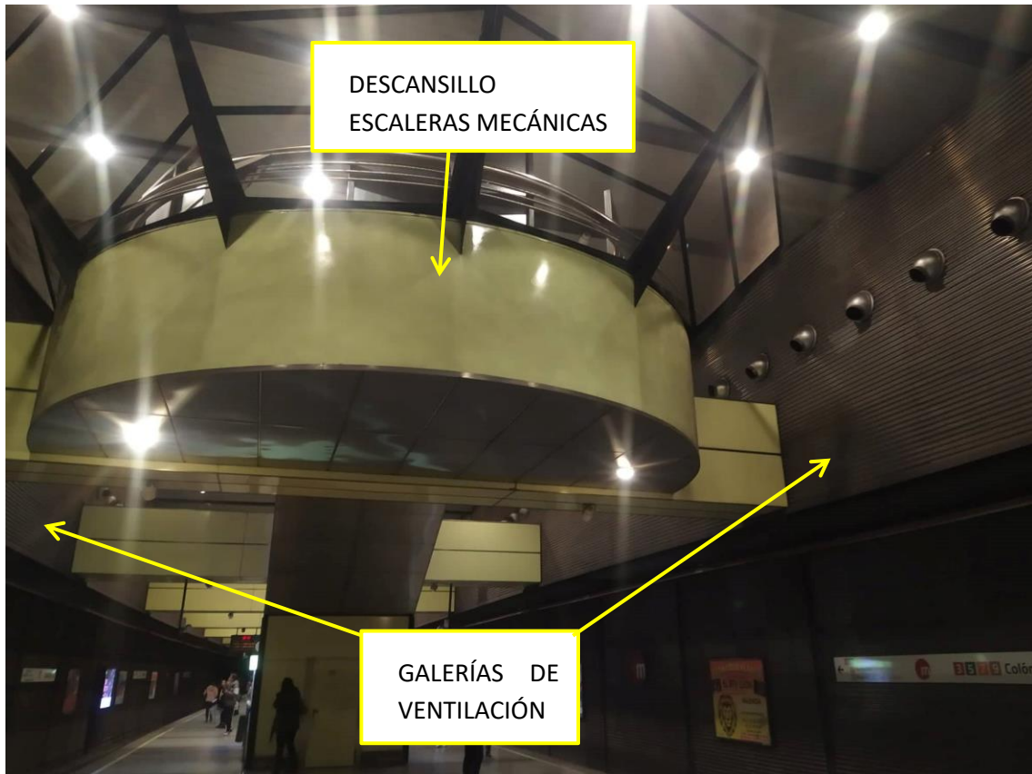
Ilustración 2: Descansillo y galerías nivel de ventilación.
