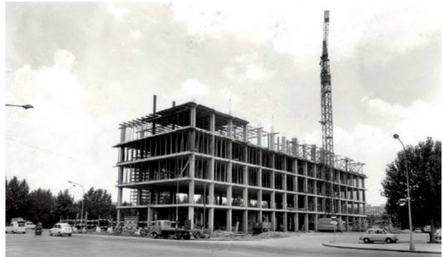
Construcción de uno de los forjados, hacia el año 1967.
