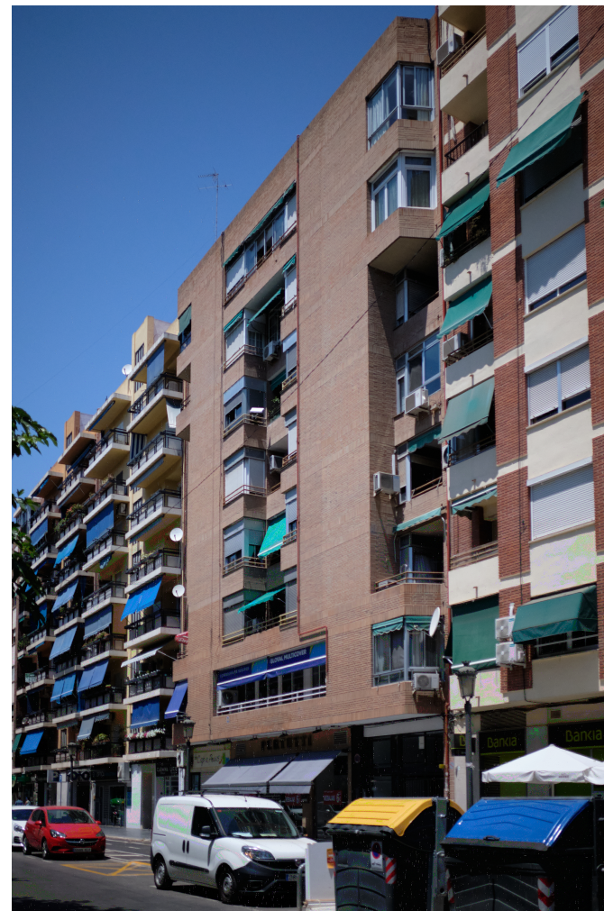
Fachada principal del edificio de Rodríguez de Cepeda (1977). Fuente: fotografía propia.
