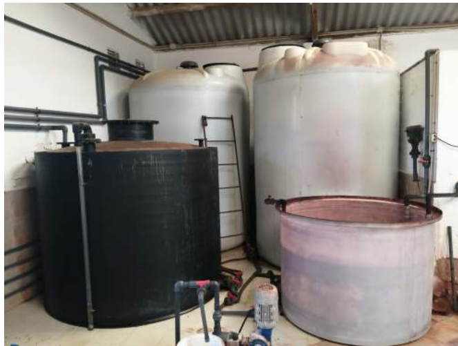
Figura 4.7: Depósitos y bomba de inyección de fertilizante
