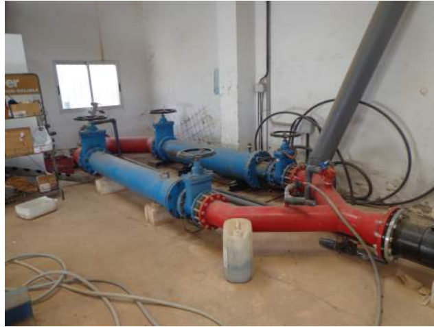
Figura 4.4: Sistema de bombas horizontales en paralelo.
