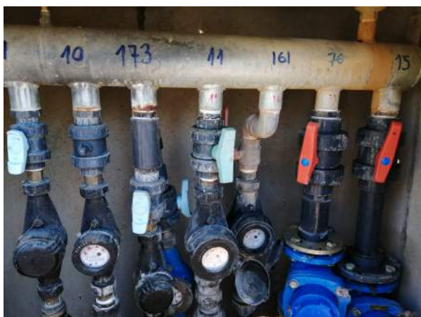
Figura 4.10: Hidrante con electroválvula.
