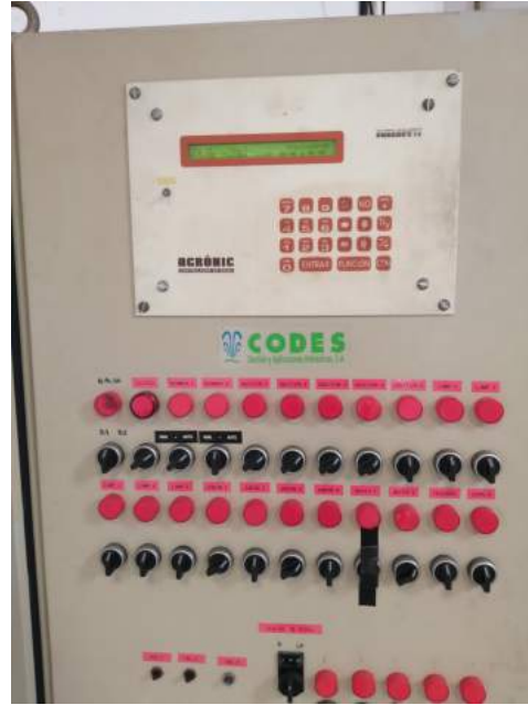
Figura 4.13: Programador de riego.
