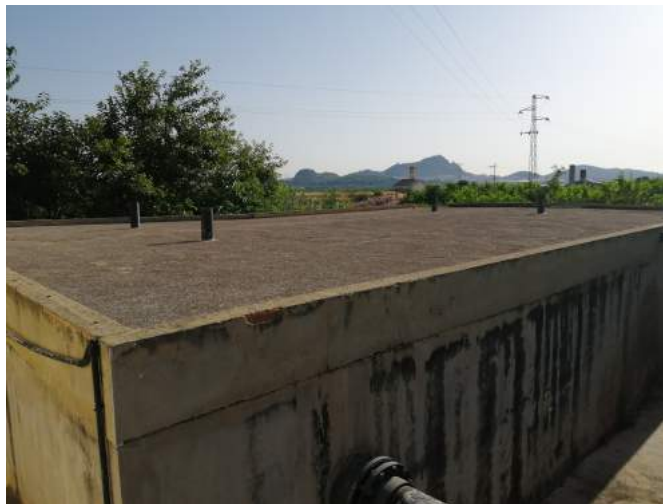
Figura 4.3: Balsa de Hormigón.
