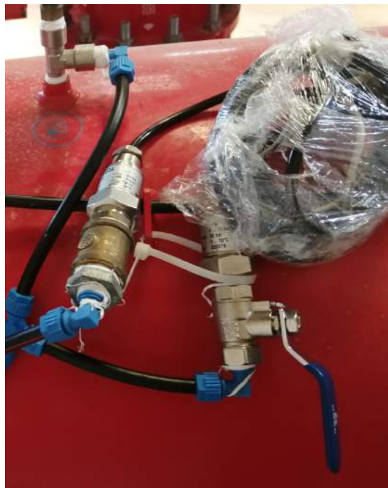
Figura 4.16: Transductor de presión colocado en el filtro.
