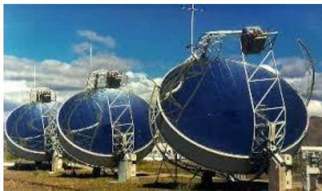
Fig. 5 Concentradores sbp en la PSA. (Fuente: idus.us.es )
