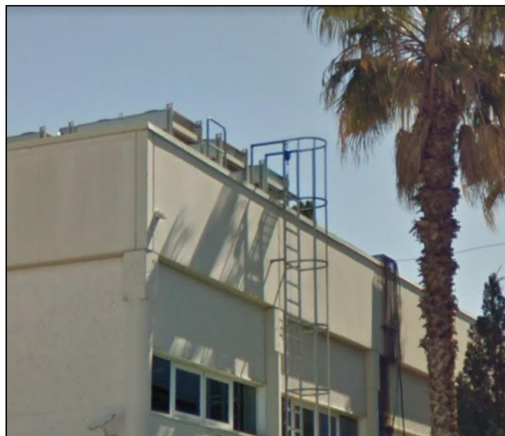
Imagen 13: Escalera de acceso a la nave 2
