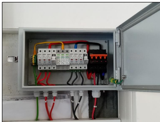
Imagen 3: Caja combinadora de hasta 4 strings
