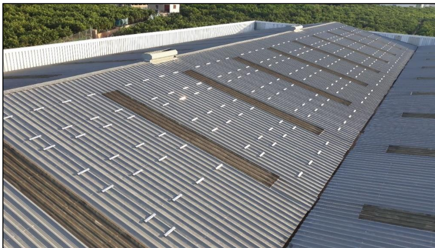
Imagen 8: Estructura coplanar de microrail con perfil a tramos
