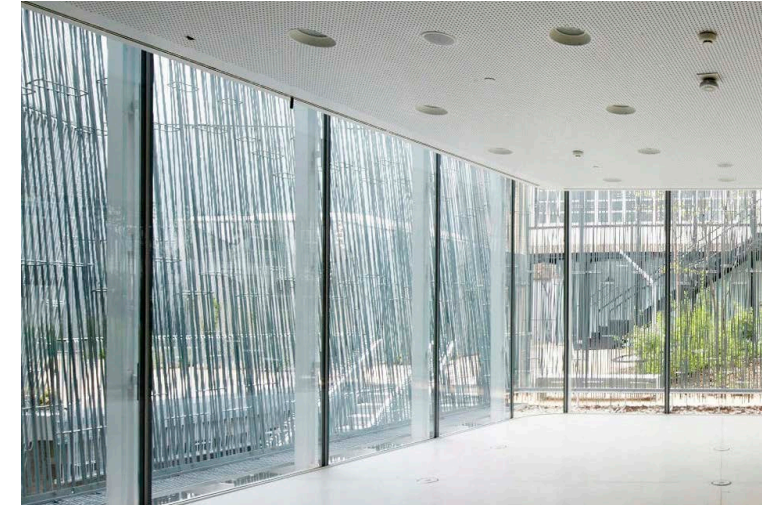
MURO CORTINA DE VIDRIO
