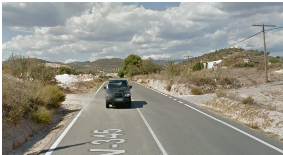
Figura 13. Obra de drenaje longitudinal tipo cuneta en intersección. Fuente, Google Maps
