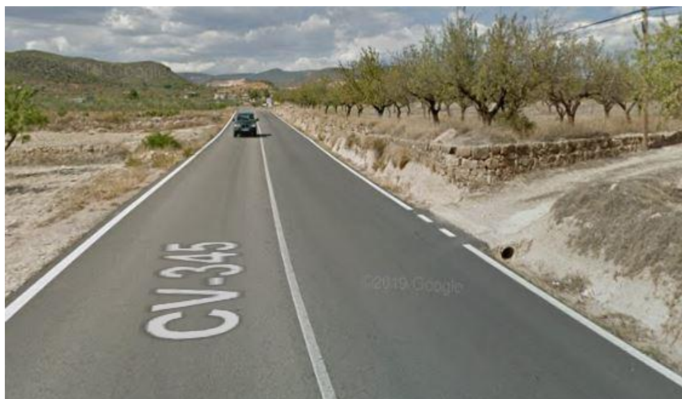
Figura 14. Obra de drenaje longitudinal de sección circular en intersección. Fuente, Google Maps
