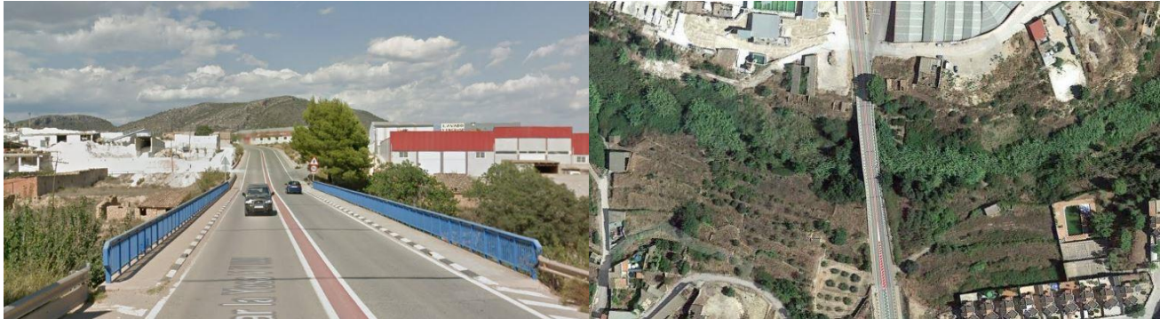
Figura 17. Puente de sección abierta en cauce natural. Fuente, Google Maps
