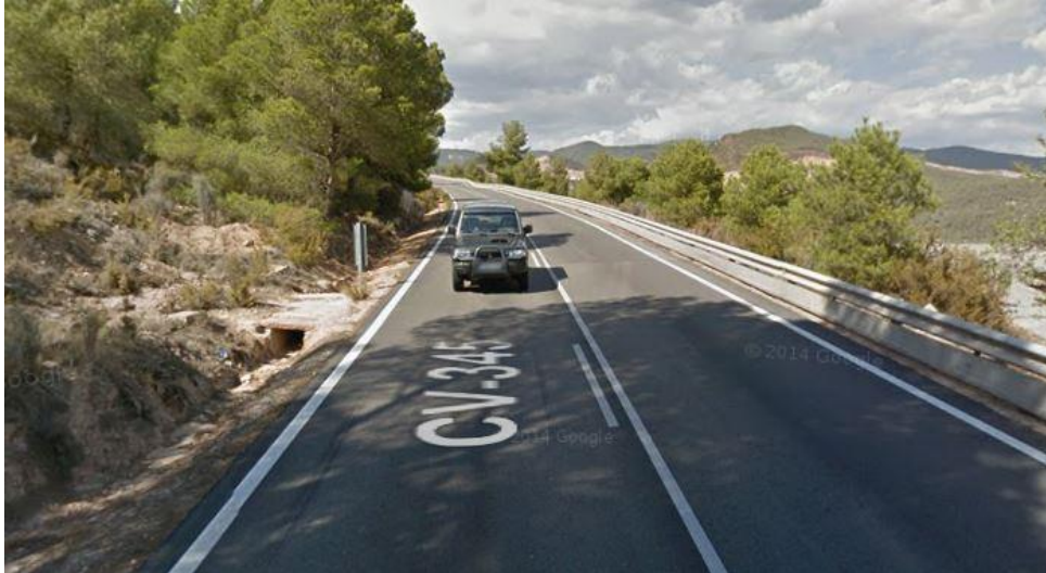
Figura 15. Obra de drenaje longitudinal de sección cuadrada en zona con peligro de desprendimiento. Fuente, Google Maps
