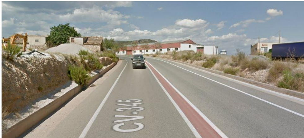
Figura 12. Obra de drenaje longitudinal tipo cuneta en zona de polígono. Fuente, Google Maps
