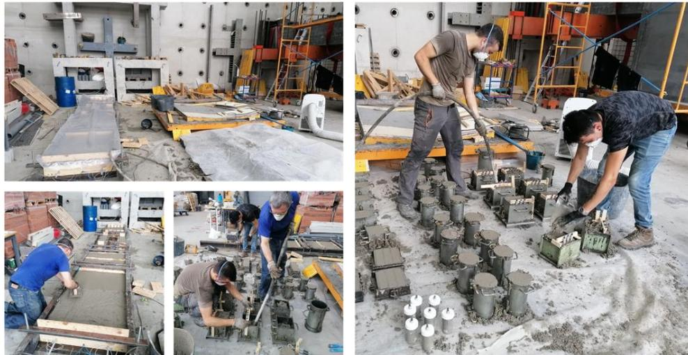
Figura. 3-12. Hormigonado probetas de caracterización. (fuente propia).
