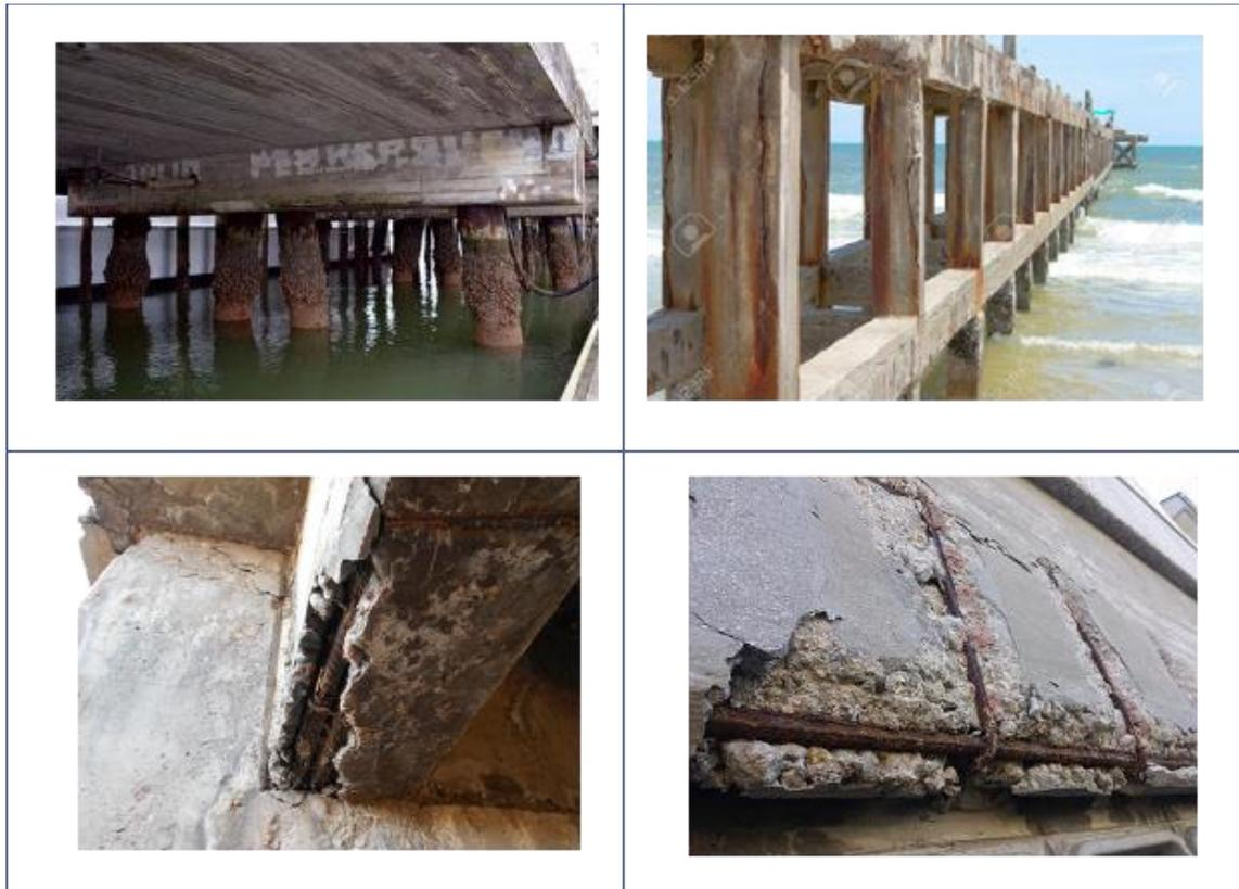
Figura. 2-2. Ejemplos de corrosión en el hormigón armado. ((Hume ingeniería, 2015), (Meneses, Moro, Alvedaño, & Ortega, 2007))
