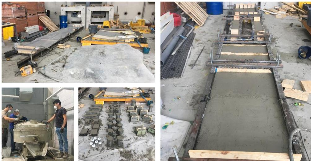
Figura. 3-13. Estado final de hormigonado (fuente propia).
