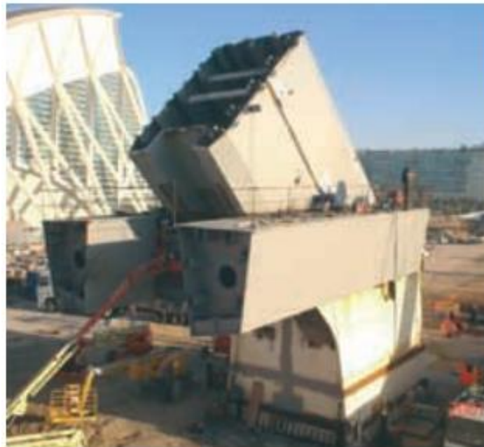
Ilustración 32: Unión de pilono, tablero y base
