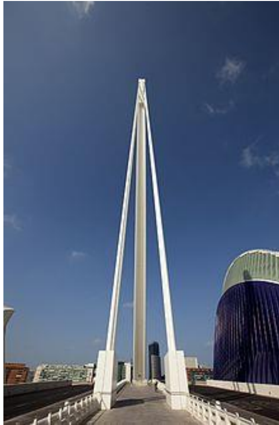
Ilustración 33: Retenida de pilono
