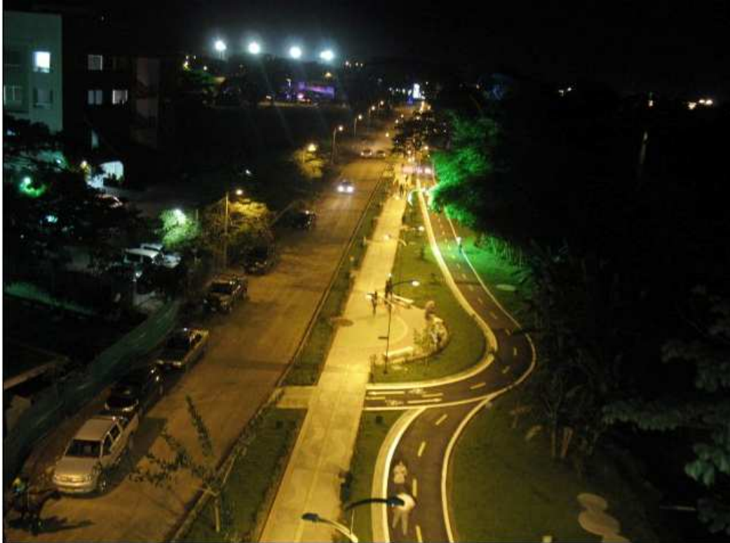
Fuente Fotográfica: Alcaldía de Montería 2010 Ilustración 128. Ronda del Sinú Norte
