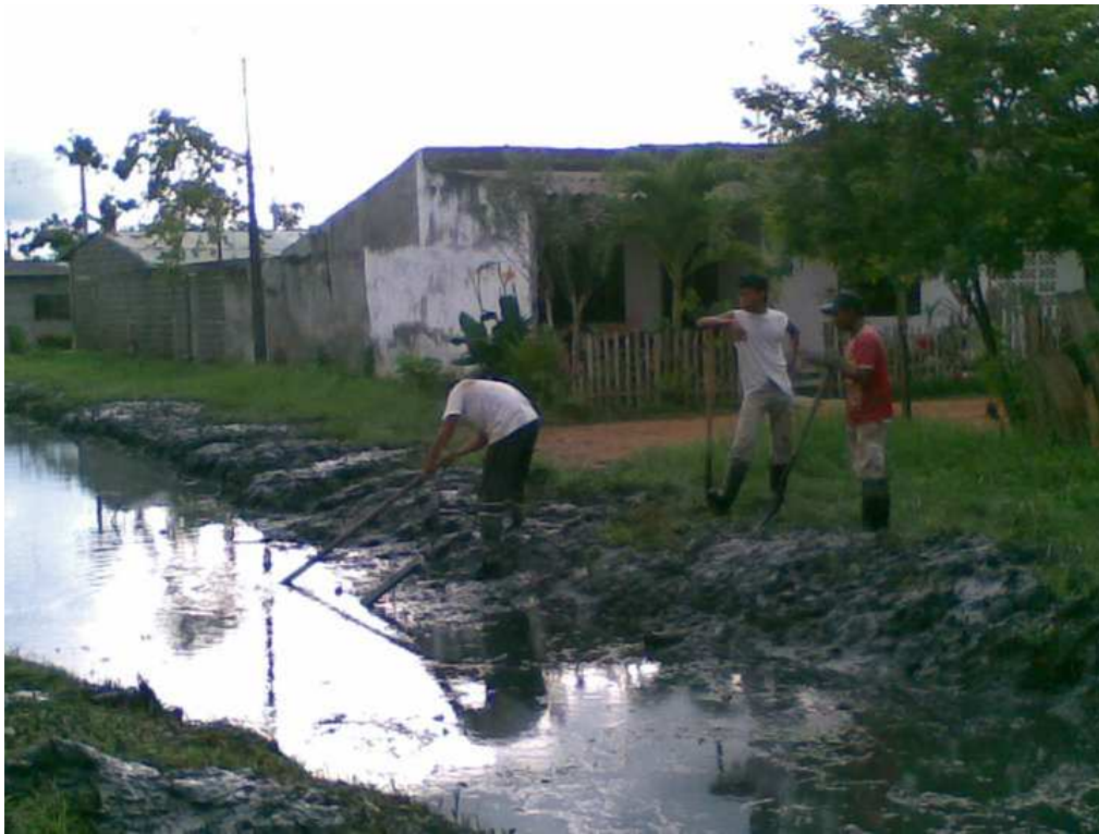
Ilustración 206. Sedimentación en canales de asentamientos semiconsolidados
