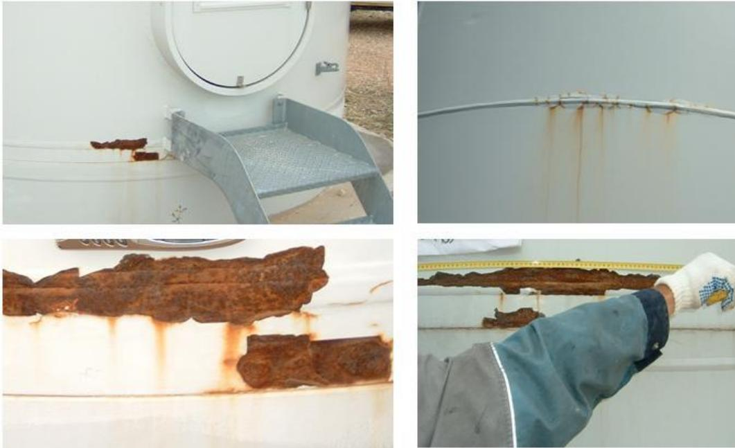
**Figura 7.11.-** Óxido en partes de un aerogenerador.
