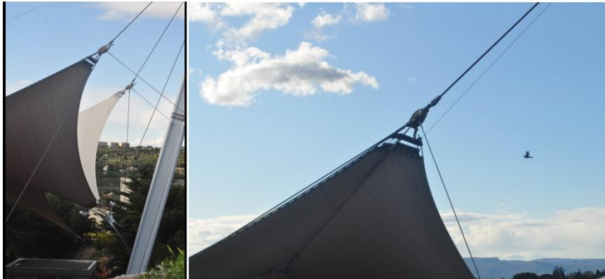
*Imagen 7. Detalles de la unión cable-membrana*
