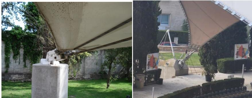
*Imagen 9. Detalle del anclaje de la cubierta*
