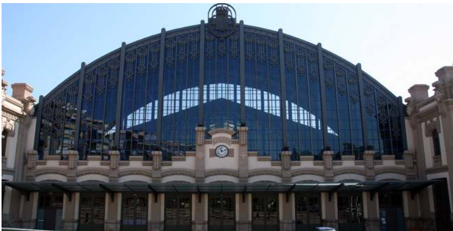
Fig. nº 45.- Fachada ppal E. de Barcelona-Nord. A. Propio (2010).
