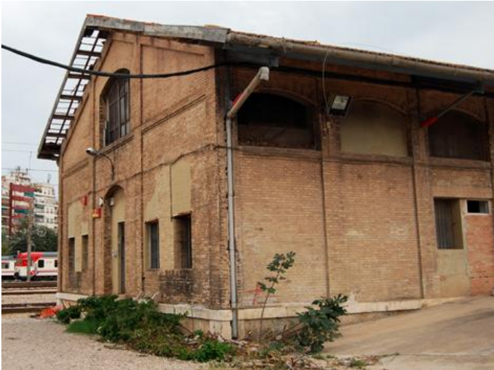
Fig. nº 64.- Vista de testero de muelle cubierto. E. de Valencia. A. Propio (2011).
