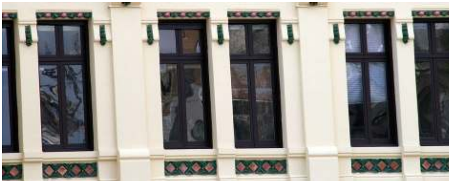
Fig. nº 366.- Detalle vanos f. ppal. E. de Valencia. A. propio (2011).
