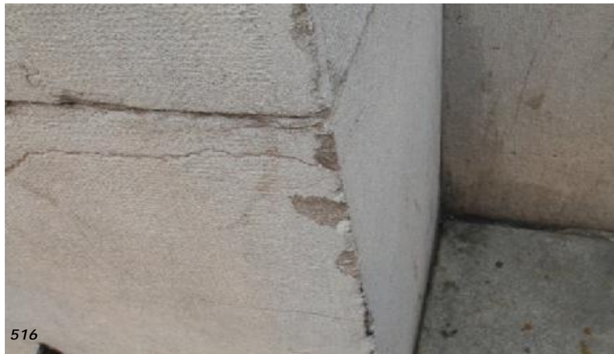
Fig. nº 512 a 516.- Manifestaciones de patología. Zócalo fachadas. Estación de Valencia. (A. Propio 2007-2011).
