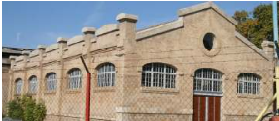
Fig. nº 210.- Vista del almacén gemelo rehabilitado. Archivo propio (2010).
