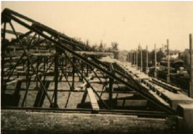
Fig. nº 587.- Estructura cubierta ala derecha ed. de viajeros. E. de Valencia. "La mirada de l´arquitecte".
