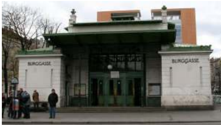
Fig. nº 352 y 353.- Vista del vestíbulo y de la fachada principal de la estación. Estación de Burgasse Stadthalle. Archivo propio (2008).
