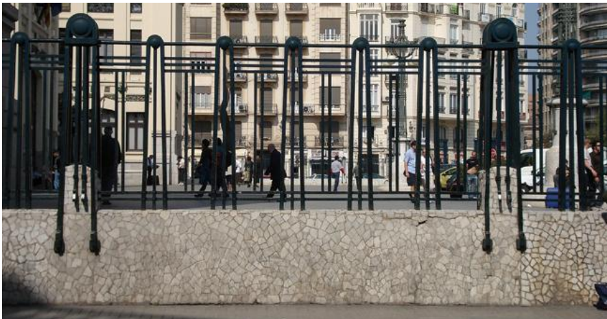
Fig. nº 614.- Detalle de tramo de vallado. Estación de Valencia. (A. Propio 2007– 2011).
