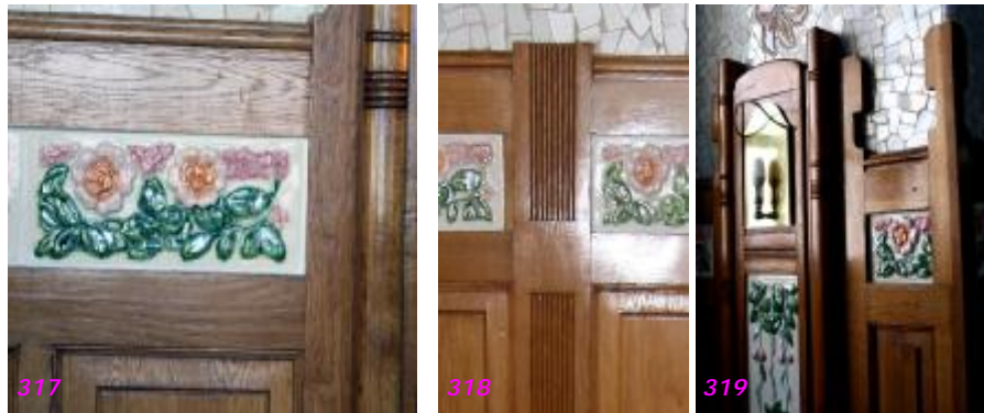
Fig. nº 317 a 319.- Detalles diversos zócalo. Antiguo café. E. de Valencia. (Archivo propio 2007-2011).
