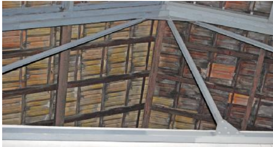
Fig. nº 62.- Vista de parte de la cubierta original. Muelles cubiertos. E. de Valencia. A. propio (2011).
