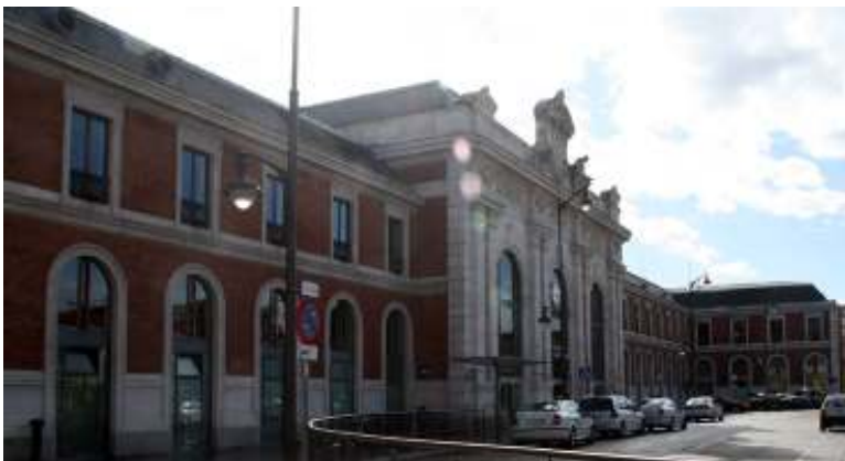
Fig. nº 54- Vista actual fachada ppal. E. de Burgos. A. propio (2011).
