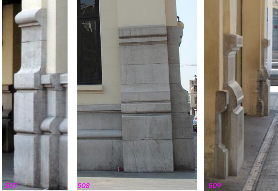
Fig. nº 507 a 509.- Detalle aparejos zócalo f. exteriores. Estación de Valencia. (A. Propio 2007-2011).
