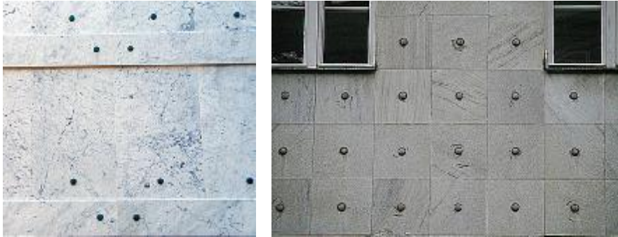
Fig. nº 315 y 316.- .Detalle de aplacado exterior de la iglesia de Steinhof (Viena) y detalle de aplacado de la Caja Postal de ahorros de Viena. (Archivo propio 2008).
