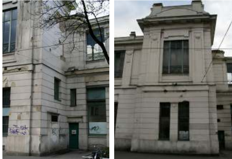
Fig. nº 325 y 326.- Vistas de una de las fachadas principales. Estación de Josefstädter Strasse. Archivo propio (2008).
