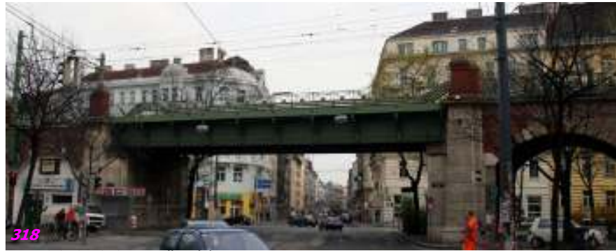
Fig. nº 316 a 318.- Detalles del puente exterior. Estación de Alser Strasse. Archivo propio (2008).
