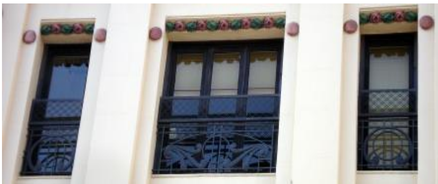
Fig. nº 184.- Detalle cerrajería f. ppal. E. de Valencia. A. propio (2008).
