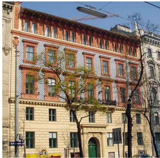
Fig. nº 4.-Vista f. ppal. Viv. En Schottenring, 23. A. Propio. (2008).
