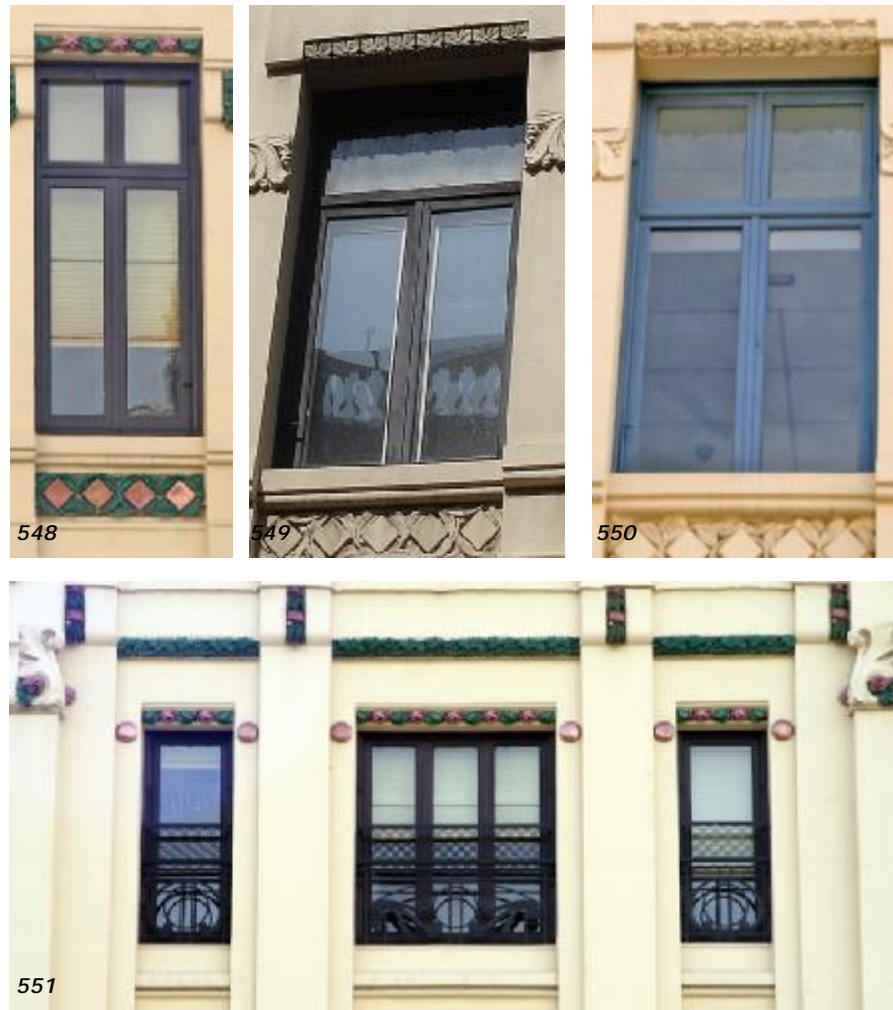
Fig. nº 548 a 551.- Detalle vanos fachadas exteriores. Estación de Valencia. A. propio (2007-2011).
