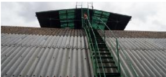
Fig. nº 480 y 481.- Detalles actual material de cubierta bóveda. E. de Valencia. (A. Propio-2007-2011).
