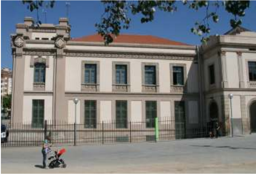
Fig. nº 168.- Vista del cuerpo de transición. Archivo propio (2010).
