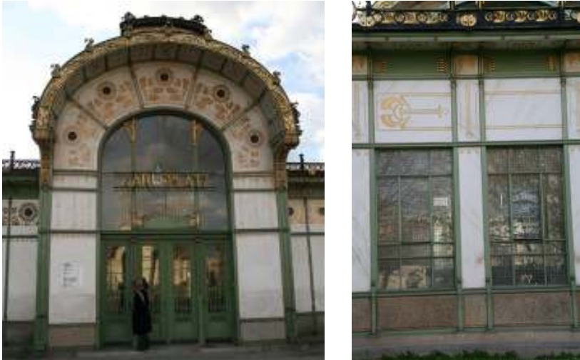
Fig. nº 192 y 193.- Vistas de la fachada principal. Estación de Karlsplatz. A. Propio (2008).
