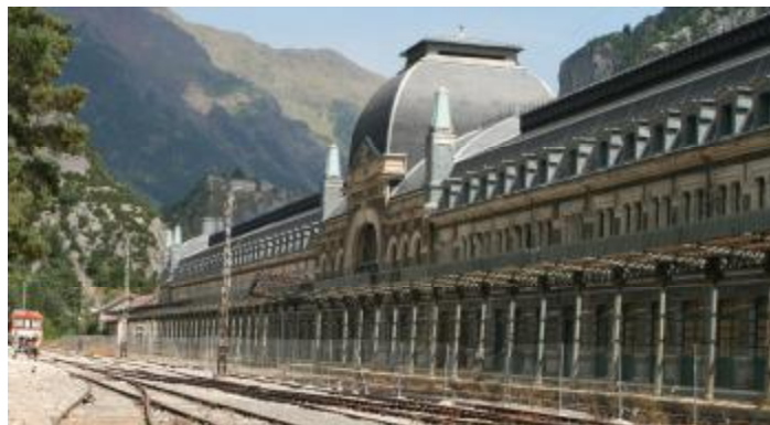
Fig. nº 238 y 239- Vistas de la fachada principal. E. Canfranc. (Archivo propio. 2010).
