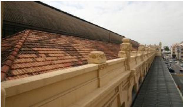
Fig. nº 591.- Vista actual del tejado del ala derecha. Ed. de viajeros. Estación de Valencia. (A. Propio 2011).
