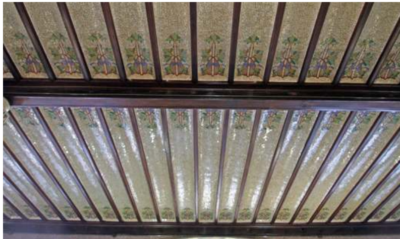
Fig. nº 191.- Detalle techo vestíbulo. E. de Valencia. A. propio (2011).
