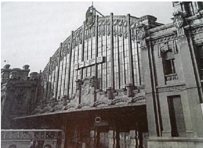
Fig. nº 260.- Vista f. principal. E. Barcelona- Nord. (FFE-2007).
