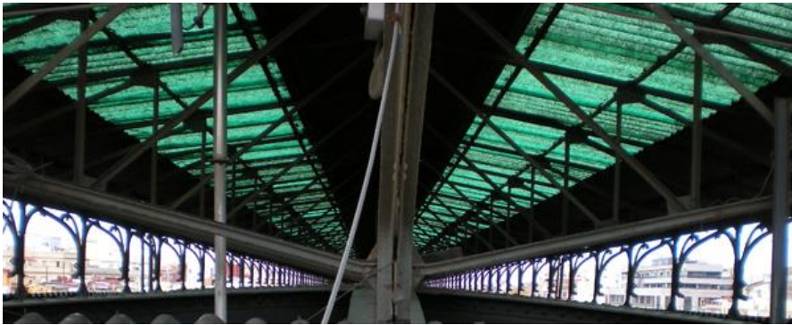
Fig. nº 153.- Vista interior del lucernario. E. de Valencia. A. propio (2011).
