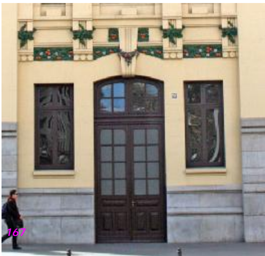
Fig. nº 166 y 167.- Vanos c. central y c. extremo f. ppal. E. de Valencia. A. propio (2008).
