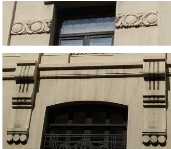
Fig. nº 9 y 10.- Detalles decorativos varios. F. Lateral. E. de Valencia. A. Propio (2008).
