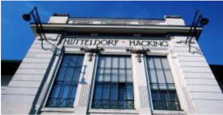
Fig. nº 267.- Vista fachada principal. E. de Hutteldorf-Hacking. "Otto Wagner".H. Kliczkowski.
