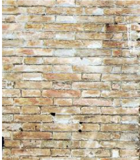
Fig. nº 58.- Detalle aparejo fábrica. Muelles cubiertos. Estación de Valencia. A. propio (2011).
