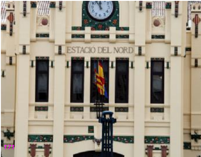
Fig. nº 170 y 171.- Vanos pl. alta f. ppal. c. extremos – c. central. E. de Valencia. A. propio (2007-2011).
