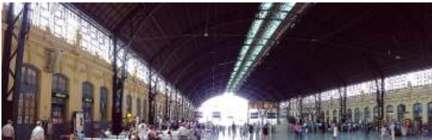
Fig. nº 14 y 15.- Vistas f. ppal. Espacio interior andenes. E.d e Valencia. A. Propio (2011).
