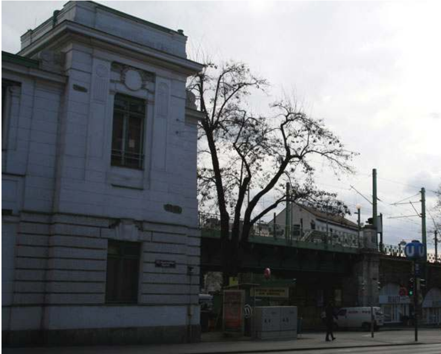
Fig. nº 376.- Vista exterior. Estación de Gumpendorfer strasse. Archivo propio (2008).
