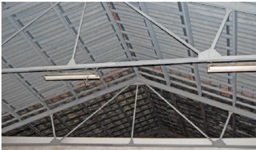
Fig. nº 61.- Vista actual de la cubierta. Muelles cubiertos. E. de Valencia. A. propio (2011).
