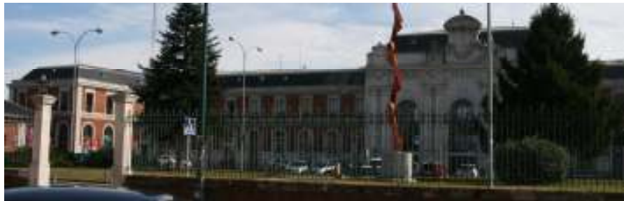
Fig. nº 118.- Vistas actual de la fachada principal. E. de Valladolid. Archivo propio (2010).
