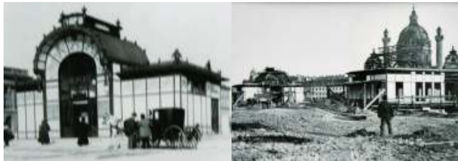
Fig. n° 176.- Vista durante la construcción de los pabellones. Estación de Karlsplatz.
