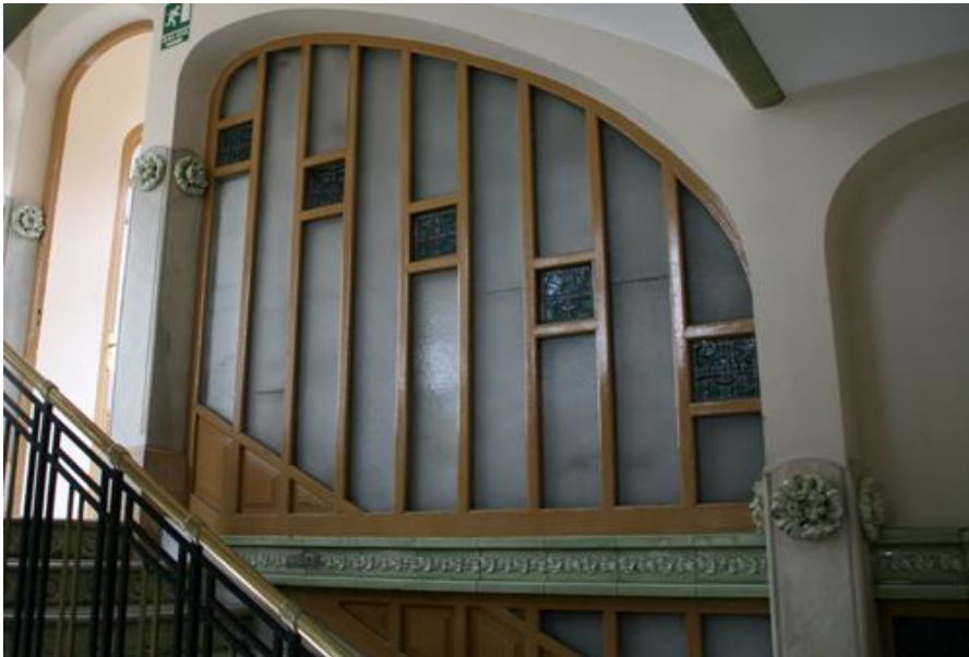
Fig. nº 400 y 401.- Detalle de mamparas. Núcleo escaleras torreón izquierdo. (A. Propio - 2011).
