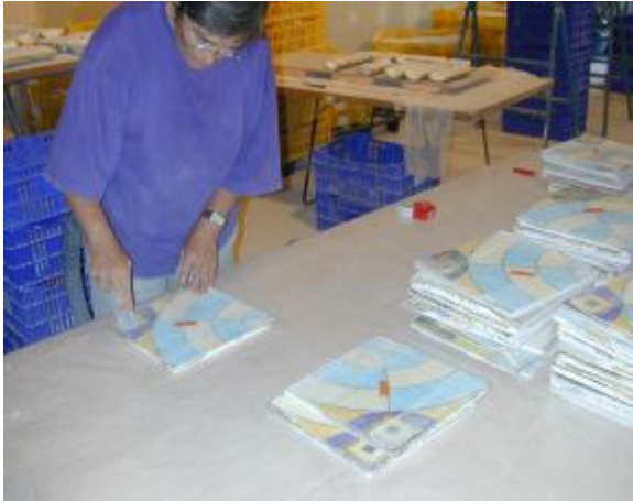
Fig. n  337.- Detalles diversos restauraci n techo Antiquo caf . Estaci n de Valencia. (Archivo propio 2007-2011).
