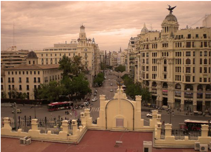
Fig. nº 601.- Vista de la cubierta plana y de la ciudad desde la escalera de la gran cubierta metálica. Estación de Valencia. (A. Propio 2007-2011).
