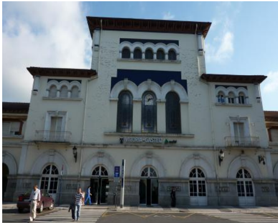
Fig. nº 214.- Vista actual de la fachada principal. Estación de Vitoria. (Archivo propio 2011).
