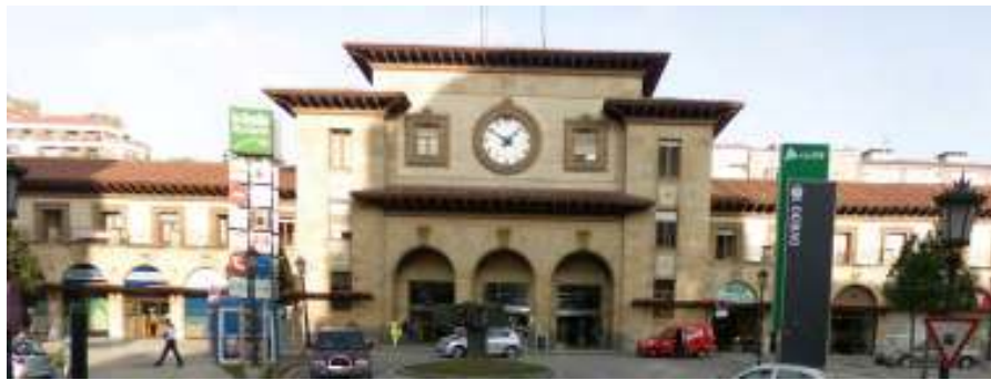
Fig. nº 102.- Vista actual fachada principal estación Oviedo. (Google).
