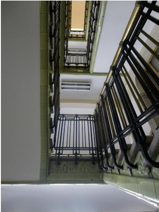
Fig. nº 390.- Detalle zancas. Núcleo escaleras torreón izquierdo. (A. Propio - 2007-2011).
