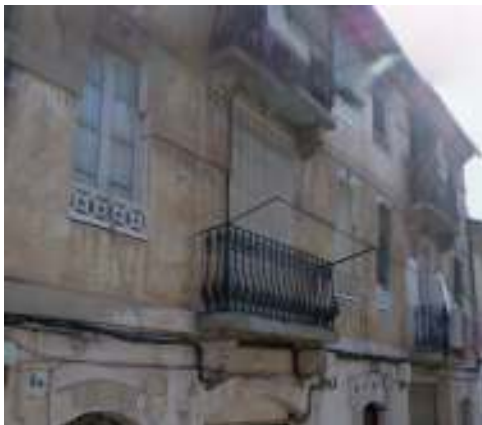
Fig. nº 117.- Vista huecos pl. 1ª. A. Propio (2011).
