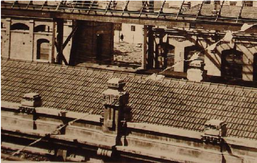
Fig. nº 576.- Vista cubierta plana ed. de viajeros. Estación de Valencia. Reg. Arq. SXX. C.V.
