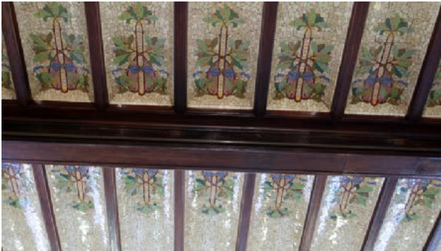
Fig. nº 291.- Revestimientos techos. Vestibulo Estación de Valencia. (A. Propio 2007-2011).
