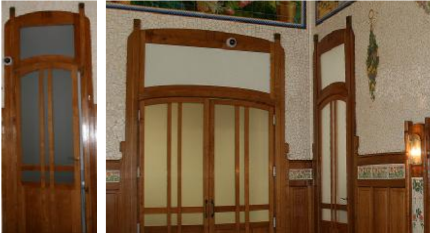
Fig. nº 340 y 341.- Detalle carp. Interior antiguo cafe. E. de Valencia. (A. propio 2008).
