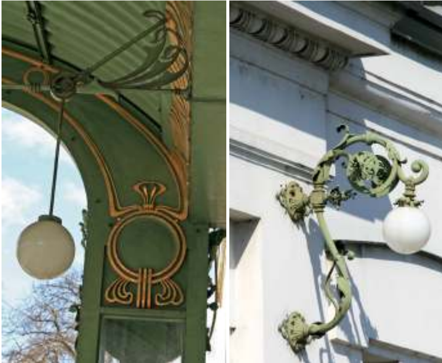
Fig. nº 262 y 263.- Detalle de las luminarias existentes en el interior del porche y en el exterior. Estación de Schönbrunn. Hofpavillon. Archivo propio (2008).
