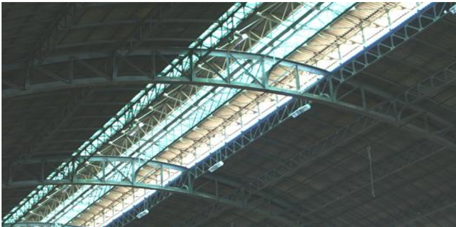
Fig. nº 462.- Vista correa cubierta. E. de Valencia. (A. propio 2007-2011).
