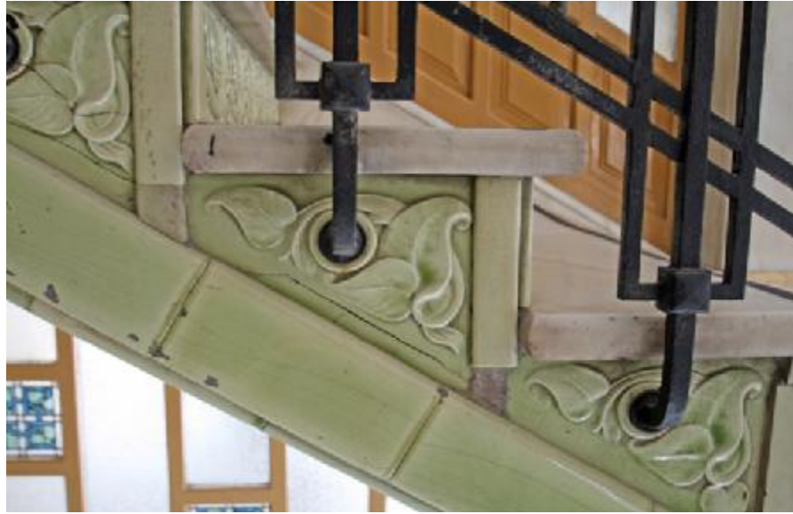
Fig. nº 391.- Detalle testa de peldaños. Núcleo escaleras torreón izquierdo. (A. Propio - 2007-2011).
