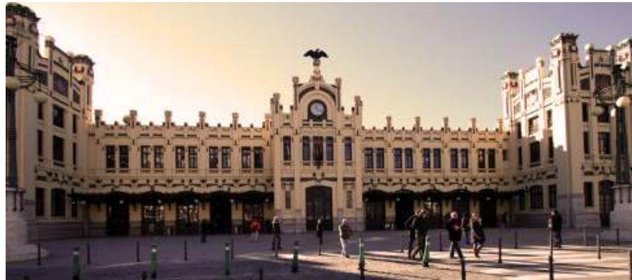
Fig. nº 3.- Vista fachada principal Estación del Norte. A. Propio (2010).
