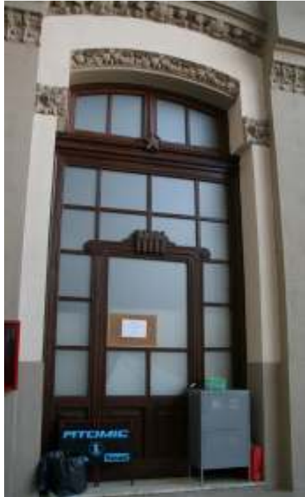
Fig. nº 177.- Detalle de carpintería interior. Parte central ampliación. Archivo propio (2010).
