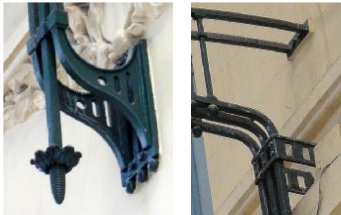
Fig. nº 574 y 575.- Detalle unión farola a paramento. E. de Valencia. (A. Propio 2007-2011).
