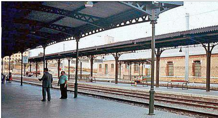
Fig. nº 156.- Vista andenes. Estación de Segovia. Todotrenes.
