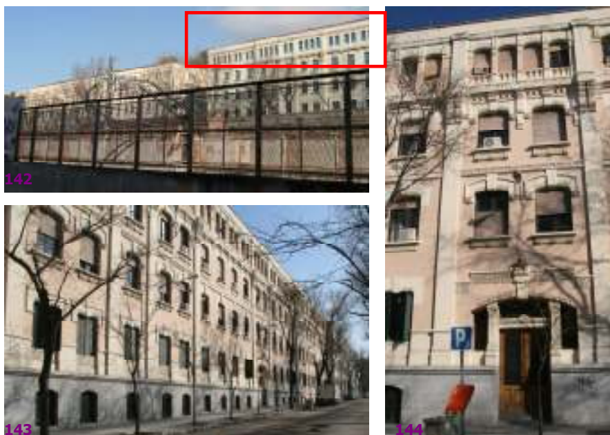
Fig. nº 142 a 144.- Vistas de los edificios gemelos. Detalle zona de acceso. A. propio (2011).
