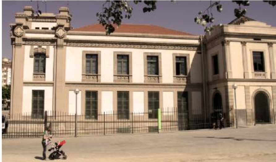
Fig. nº 262.- Vista pabellones laterales. E. de Barcelona-Nord. A. Propio (2010).
