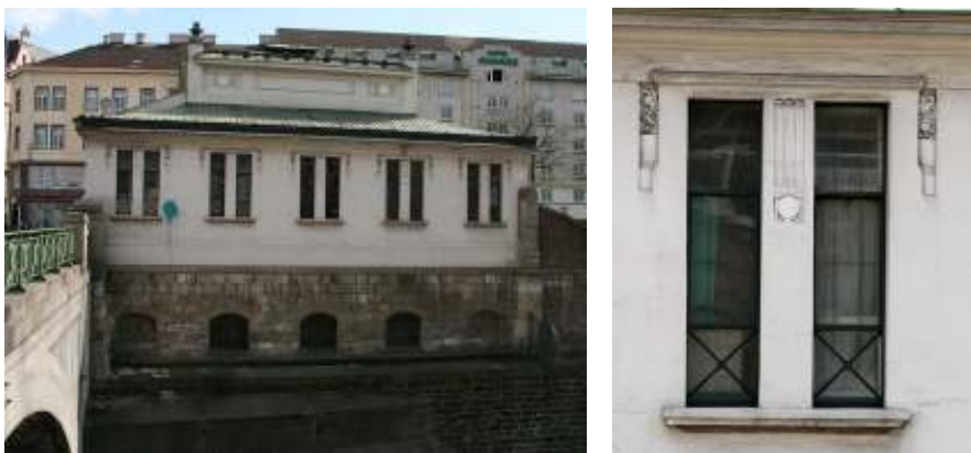
Fig. nº 217.- Vista de la fachada lateral recayente al canal.
