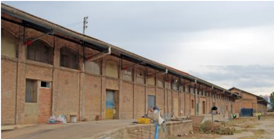
Fig. nº 56 y 57.- Vista de los muelles cubiertos. Estación de Valencia. A. propio (2011).
