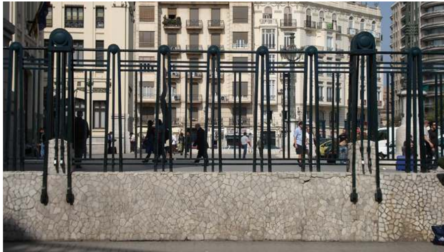
Fig. nº 266.- Detalle de verja exterior. E. de Valencia. Archivo propio (2011).
