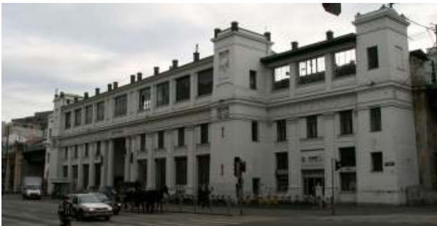
Fig. nº 298 y 299.- Vistas de una de las fachadas principales del edificio. Estación de Alser Strasse. Archivo propio (2008).
