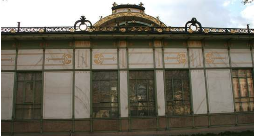
Fig. nº 194.- Vista de la fachada trasera de uno de los pabellones. Estación de Karlsplatz. Archivo propio (2008).
