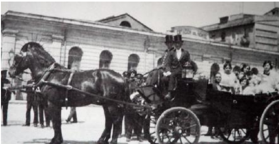
Fig. nº 30.- Vista de la fachada principal con carretilla delante. Estación de El Grao. “Caminos de hierro, estaciones, puentes, viaductos y locomotoras”. Col. De Ingenieros de Caminos C.V.
