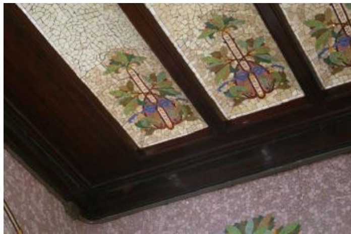
Fig. nº 292.- Detalle esquina. Revest. techo. Vestíbulo E. de Valencia. (A. Propio 2008).
