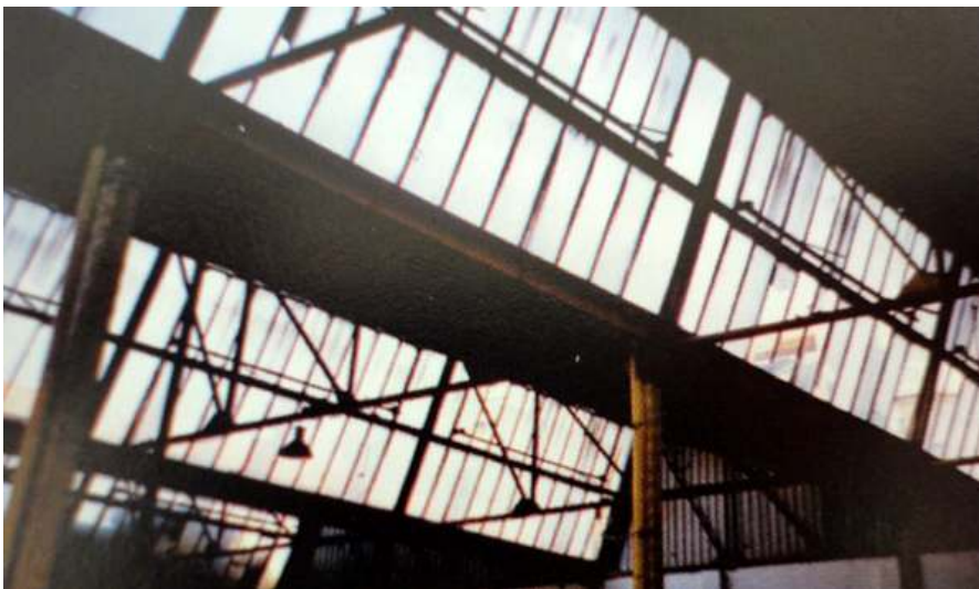
Fig. nº 213.- Vista interior taller ubicado junto a calle Filipinas. "Demetrio Ribes". I. Aguilar.
