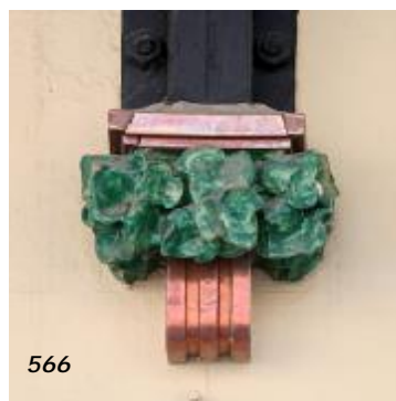
Fig. nº 564 a 566.- Detalle piezas apoyo. Marquesina f.ppal y f. calle Bailén. E. de Valencia. (Archivo propio 2007-2011).
