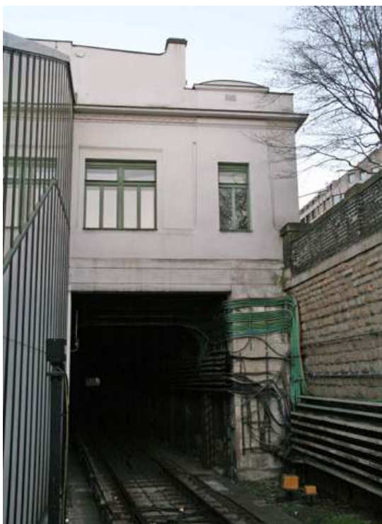
Fig. nº 142 y 143.- Vistas f. posterior. Estación de Friedensbrücke. Archivo propio (2008).
