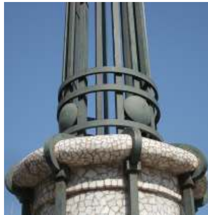
Fig. nº 147 .- Detalle del arranque de una de los soportes que componen el pórtico de acceso. Estación de Rossauer Lände. A. propio (2008).
