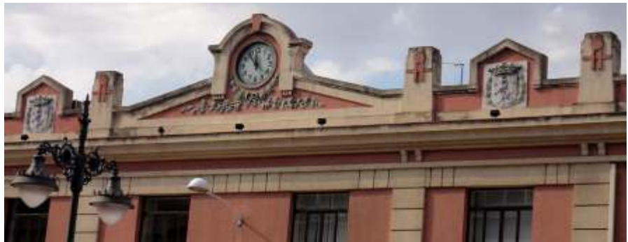
Fig. nº 104.- Detalle frontón fachada principal. Estación de León. A. propio (2011).
