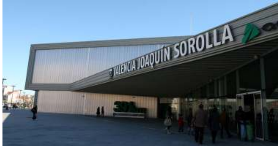
Fig. nº 13.- Vista estación provisional de Valencia. A. propio (2010).
