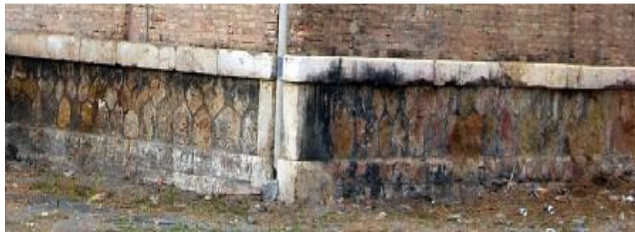
Fig. nº 59.- Detalle zócalo. Muelles cubiertos. Estación de Valencia. A. propio (2011).
