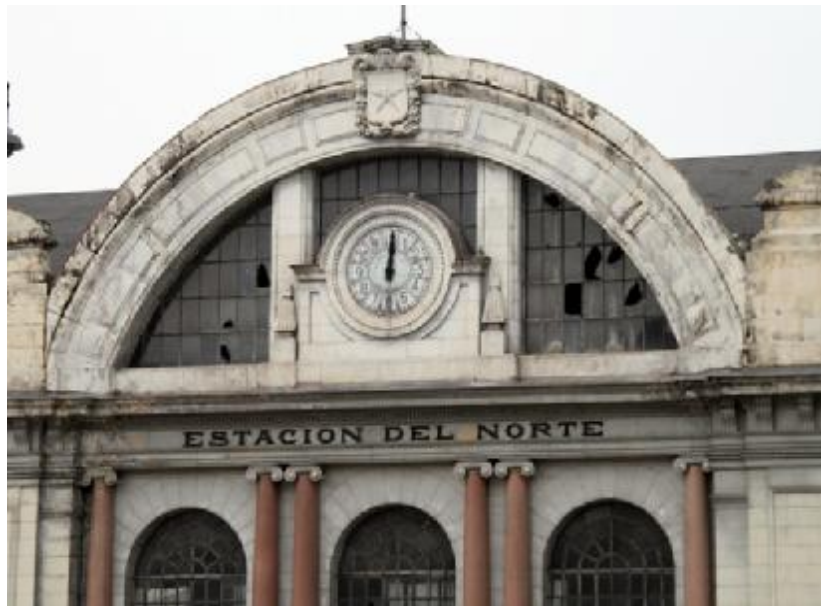
Fig. nº 176 y 177.-Vista fachada ampliación. E. Madrid P Pio. (A. propio 2011).
