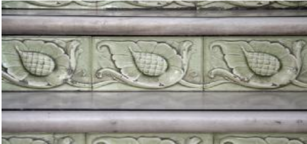
Fig. nº 362.- Detalle de tabica. Zona de acceso al torreón izquierdo. (A. Propio 2011).
