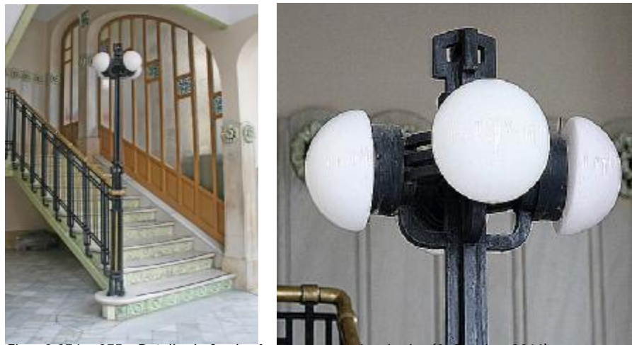
Fig. nº 374 y 375.- Detalle de farola. Acceso torreón izquierdo. (A. Propio - 2011).
