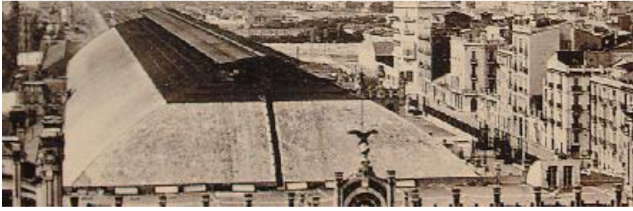
Fig. nº 449.- Vista testero bóveda original. Estación de Valencia. Reg. de arq. Del SXX. C.V..
