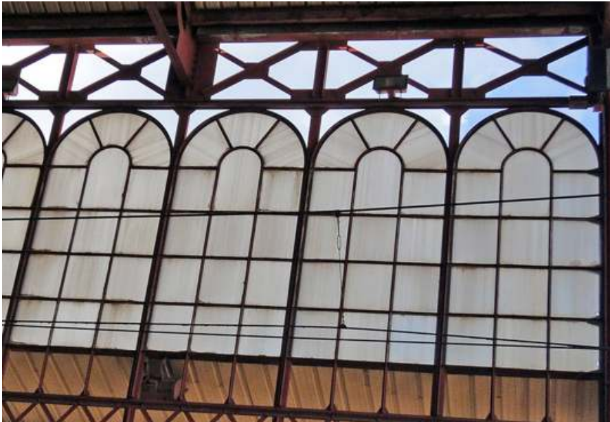
Fig. nº 111.- Detalle de cristalería. Estación de León. A. propio (2011).
