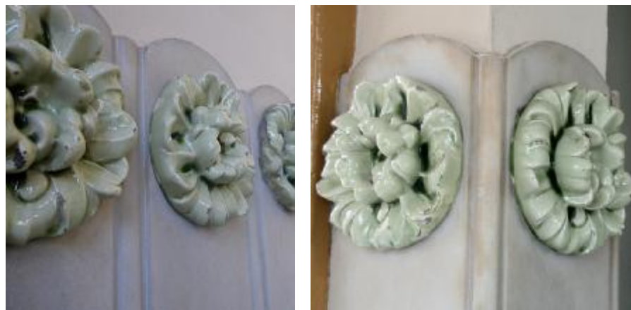
Fig. nº 364 a 366.- Detalle del zócalo. Zona de acceso al torreón izquierdo. (A. Propio 2011).
