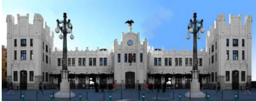
Fig. nº 100.- Abstracción fachada ppal. E. de Valencia. A. Propio (2011).
