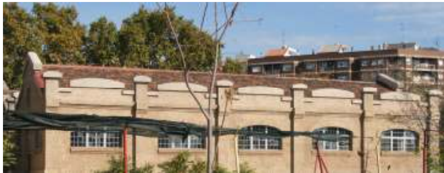
Fig. nº 211.- Alzado lateral del almacén gemelo rehabilitado. Archivo propio (2010).
