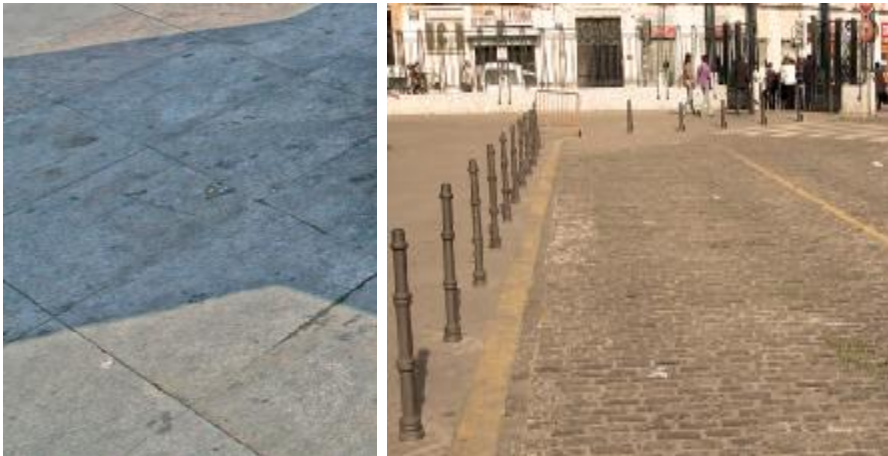
Fig. nº 607 y 608.- Detalle solado actual en la zona peatonal y vista actual patio de salidas. Estación de Valencia. (A. Propio 2007– 2011).
