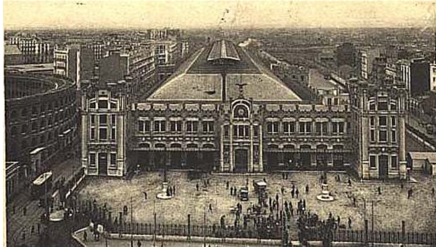
Fig. nº 56 .- Vista Estación del Norte (Valencia)(1941). J. Furió.
