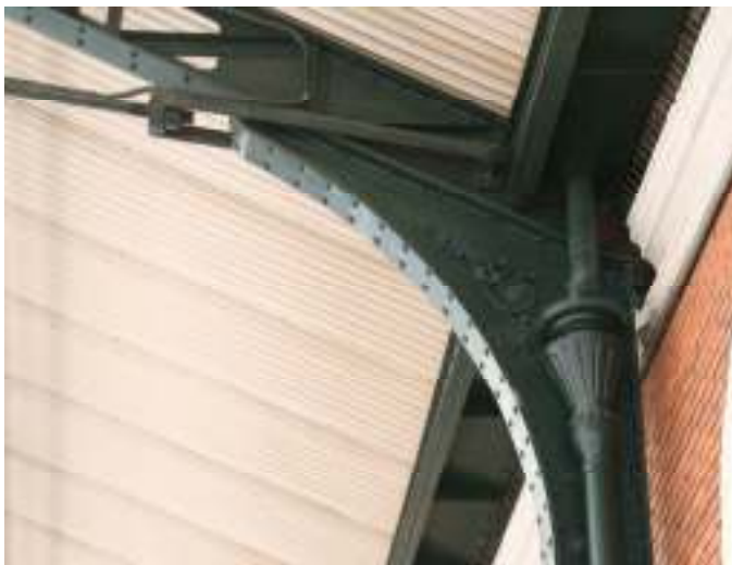
Fig. nº 119.- Alzado interior y marquesina. E. de Valladolid. Archivo propio.( 2010).
