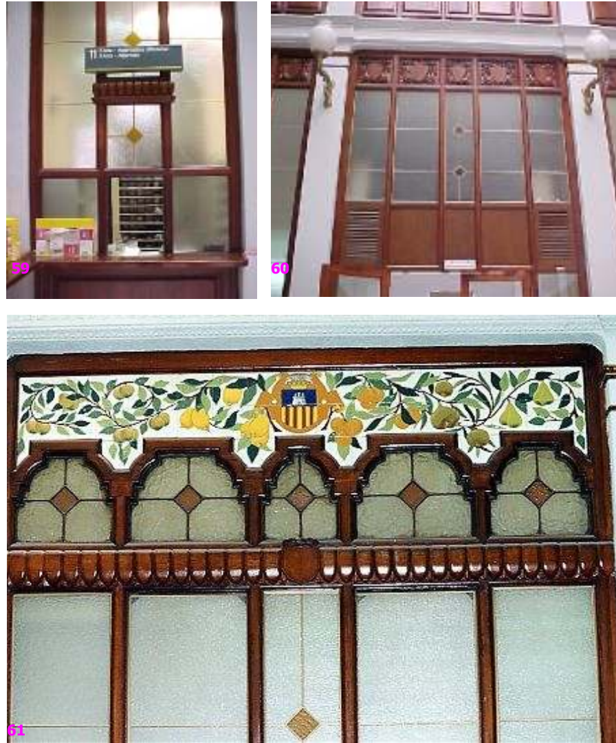
Fig. nº 59 a 61.- Detalles interiores. Ed. Correos y telégrafos. Reg. Arq. SXX. C.V.
