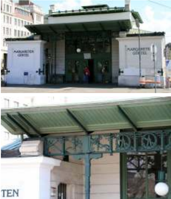
Fig. nº 226 y 227.- Vista de la fachada principal y detalle del pórtico metálico que preside el acceso. Estación de Margaretengürtel. Archivo propio (2008).
