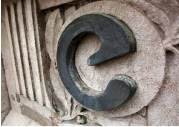
Fig. nº 538.- Detalle letrero "correos". f. lateral derecha. Estación de Valencia. (A. Propio 2007-2011).
