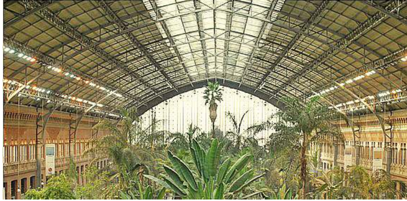
Fig. nº 32.- Detalle cerchas cubierta. E. de Atocha (Madrid). A. propio (2010).
