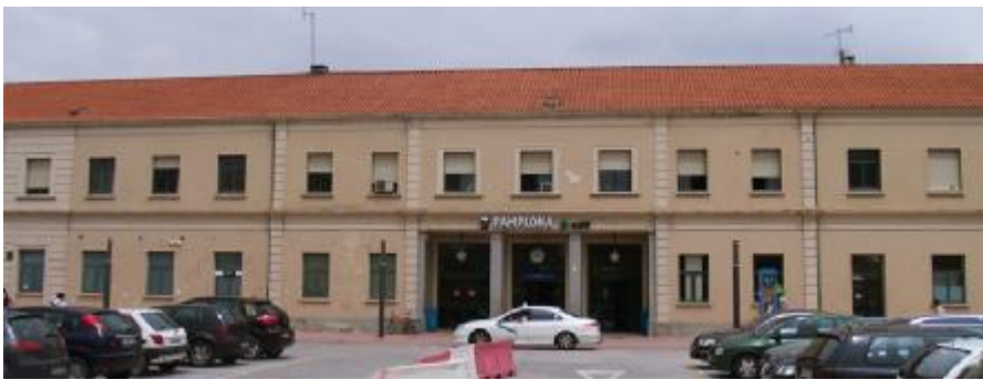
Fig. nº 233.- Vista actual f. ppal. E. Pamplona. (Google).
