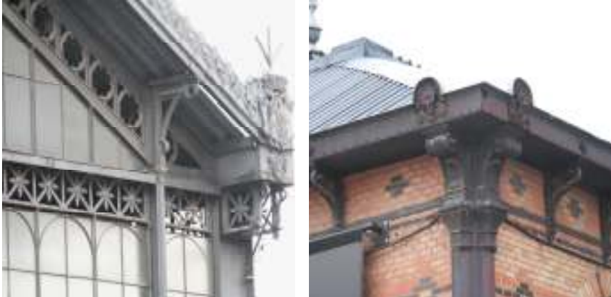
Fig. nº 24 y 25.- Detalles fachada principal. Estación de Delicias (Madrid). A. Propio (2010).
