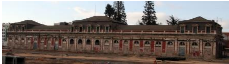
Fig. nº 194.- Vista actual de la estación de Burgos. A. propio (2011). E. Burgos. (FFE)(A. propio 2011)
