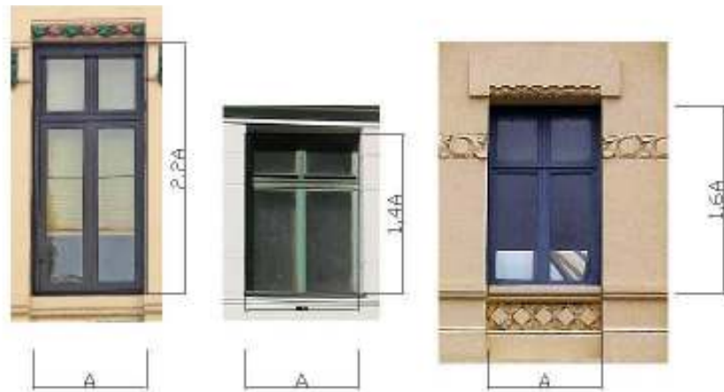
Fig. nº 289.- Estudio comparativo huecos. E. de Währinger Strasse Volksoper (en el centro) – E. de Valencia. Archivo propio (2011).
