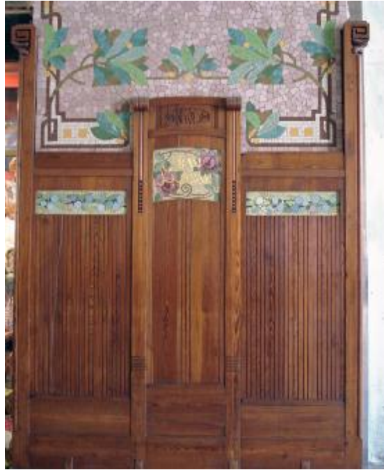
Fig. nº 287.- Detalle de zócalo de madera. Vestíbulo E. de Valencia. A. propio (2007).
