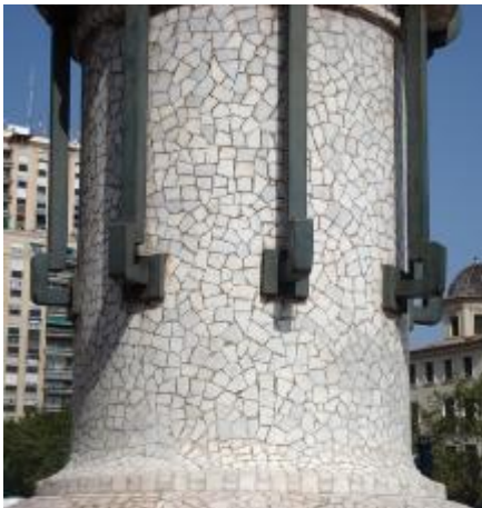
Fig. n° 630 y 631.- Detalles anclajes mástil farola exterior. Estación de Valencia. (A. Propio 2007- 2011).
