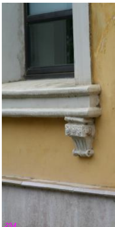
Fig. nº 253 y 254.- Detalles decorativos y de materialidad varios. E. Zaragoza-Arrabal. (FFE - Archivo propio. 2011).
