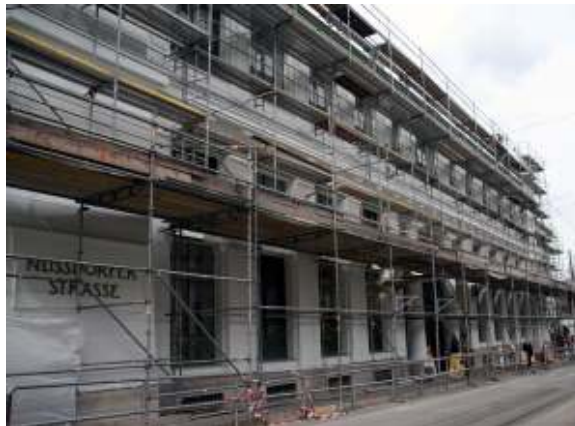
Fig. nº 269.- Vista fachada principal (E. actual). E. de Nussdorfer Strasse. A. propio (2008).
