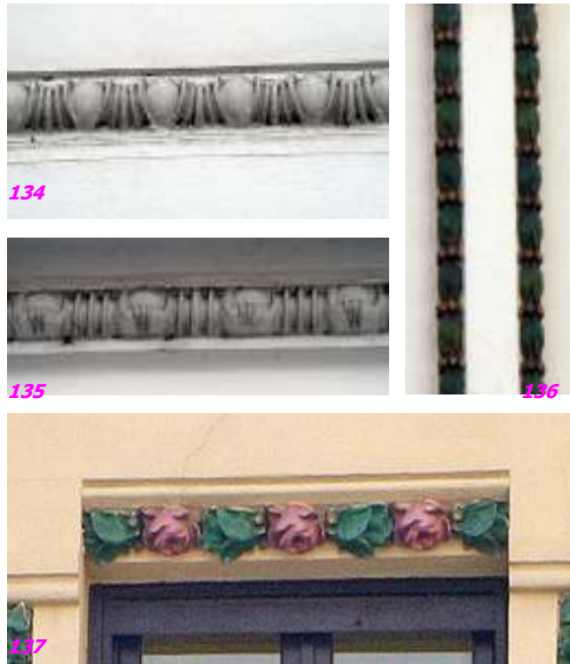
Fig. nº 134 a 137.- Detalle cordones decorativos E. Friedensbrücke – E. Valencia. A. propio (2008-2011).
