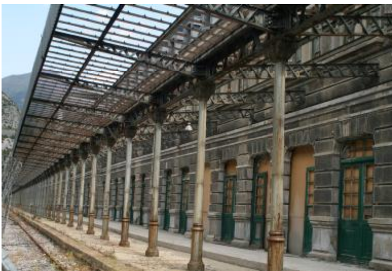
Fig. nº 240 y 241.- Vistas de la fachada principal. E. Canfranc. (Archivo propio. 2010).
