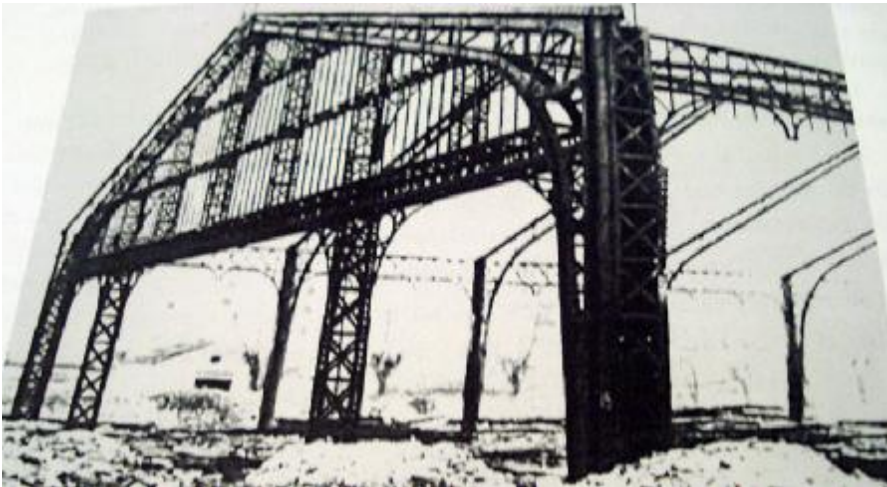
Fig. nº 19.- Vista de la cubierta metálica cuando la estaban derribando en 1974. Estación de Aragón. (FFE – 2007).
