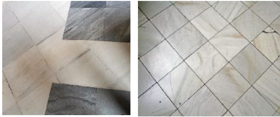
Fig. nº 279 y 280.- Solado actual y posible solado original. Vestíbulo Estación de Valencia. (A. Propio 2007-2011).
