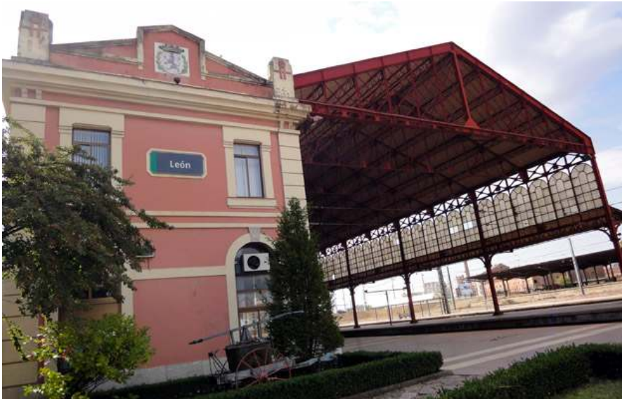
Fig. nº 107.- Vista fachada lateral y testero cubierta. Estación de León. A. propio (2011).
