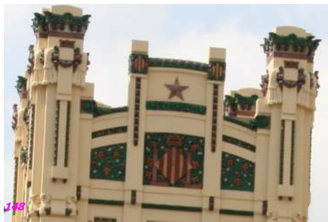
Fig. nº 146.- Detalle del acceso. Ed. Gemelos P.Pío. A. propio (2011).
