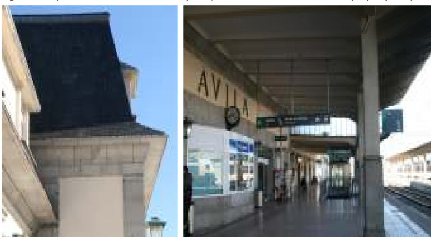
Fig. nº 147 y 148.- Detalle de cubierta mansarda y vista de la fachada posterior. Estación de Ávila. Archivo propio (2011).
