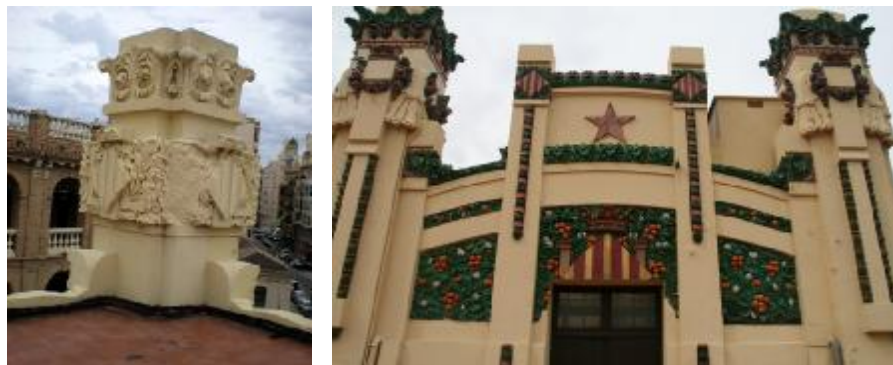
Fig. nº 584 y 585.- Detalles de antepecho y de acceso. Azotea del edificio de viajeros. Estación de Valencia. (A. Propio 2007-2011).
