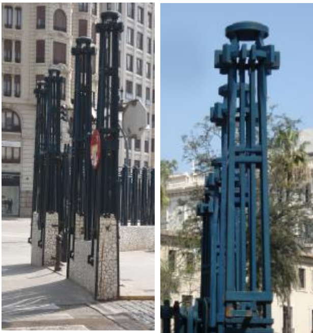
Fig. nº 618 y 619.- Detalles de pináculo de verja. Estación de Valencia. .(A. Propio 2007– 2011).
