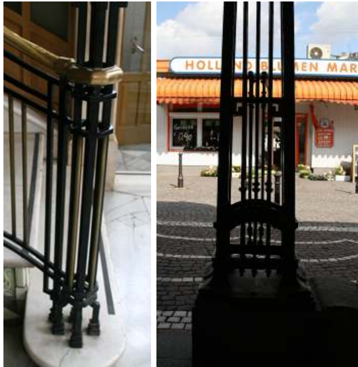
Fig. n° 219.- Detalle arranque barandilla. Torreón izqdo. E. de Valencia. A. Propio (2011).
