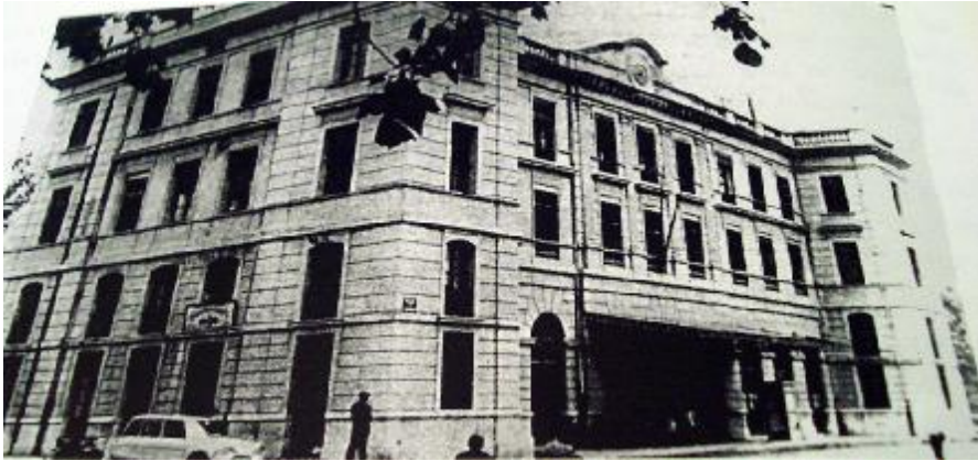
Fig. nº 18.- Vista de la estación de Aragón. (FFE – 2007).
