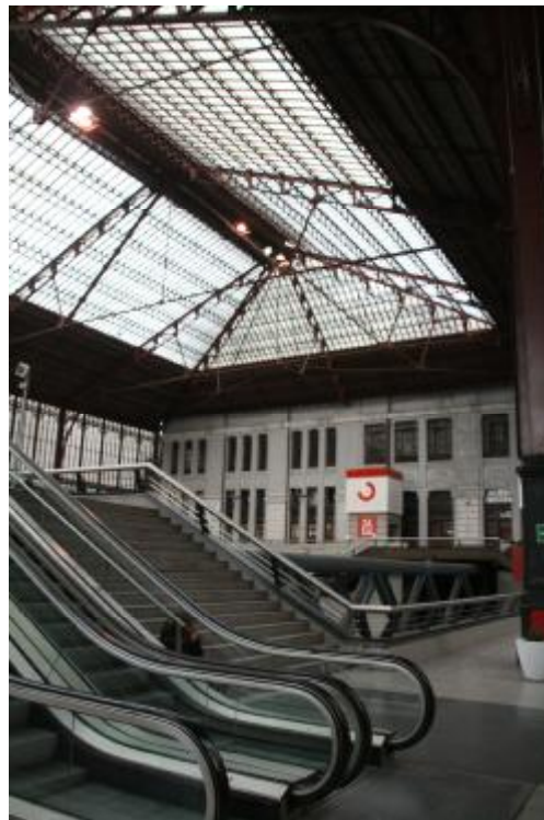
Fig. nº 180 y 181.- Vistas de las cubiertas. E. Madrid P Pio. (Archivo propio 2011).
