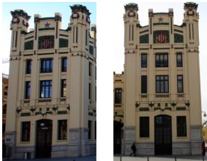
Fig. nº 85 y 86.- Vista actual torreones laterales. F. principal. A. propio (2007-2011).
