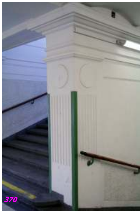
Fig. nº 368 a 370.- Vistas interiores. Estación de Gumpendorfer strasse. Archivo propio (2008).
