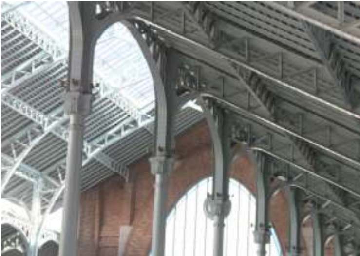
Fig. nº 41.- Vista de la estructura del mercado de Colón. Archivo propio (2010).
