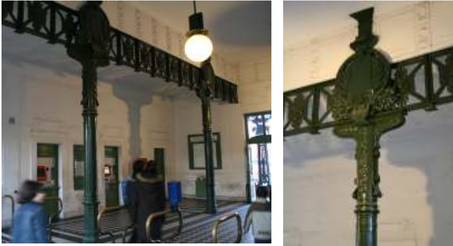
Fig. nº 138 y 139.- Vista del vestíbulo. Detalle de la estructura metálica. Estación de Friedensbrücke. Archivo propio (2008).
