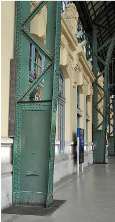
Fig. nº 141 y 142.- Vistas soportes cercha. E. de Valencia. A. propio (2010).
