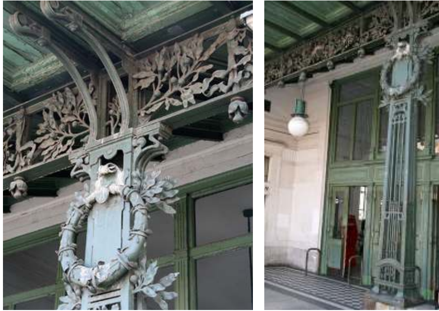
Fig. nº 214 y 215.- Detalle del pórtico de acceso. E. de Pilgramgasse. A. Propio (2008).
