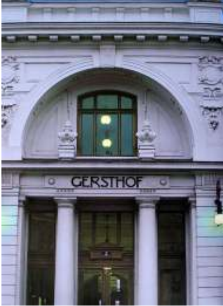
Fig. nº 393.- Vista de la fachada principal. E. de Gersthof. "Otto Wagner" H. Kliczkowski.
