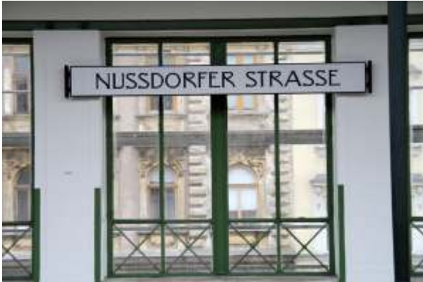
Fig. nº 271.- Detalle de hueco. E. de Nussdorfer Strasse. A. Propio (2008).
