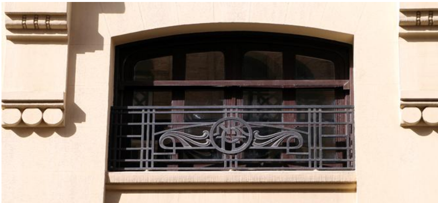
Fig. nº 539 y 540.- Detalles cerrajería. Estación de Valencia. (A. Propio 2007-2011).
