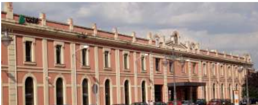
Fig. nº 231.- Fachada principal. E. de León. A. Propio (2011).
