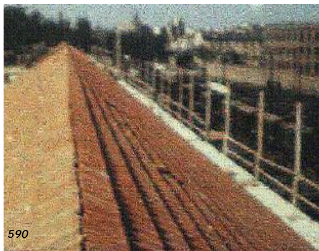
Fig. nº 588 a 590.- Secuencia constructiva cubierta ala derecha ed. de viajeros. E. de Valencia. "La mirada de l'arquitecte".
