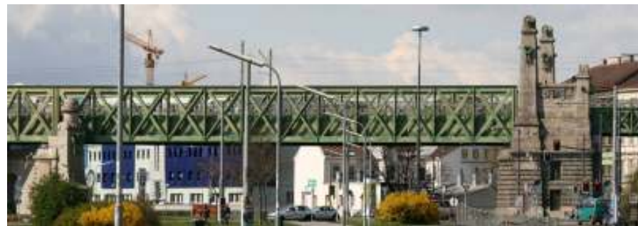
Fig. nº 239.- Vista de uno de los viaductos proyectados por Wagner. E. de Margaretengürtel. A. Propio (2008).
