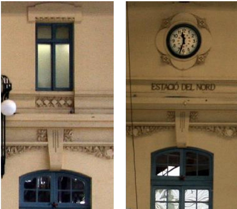
Fig. nº 101 y 102.- Detalle decoración huecos y módulo central. Fachada principal interior. A. Propio (2011).
