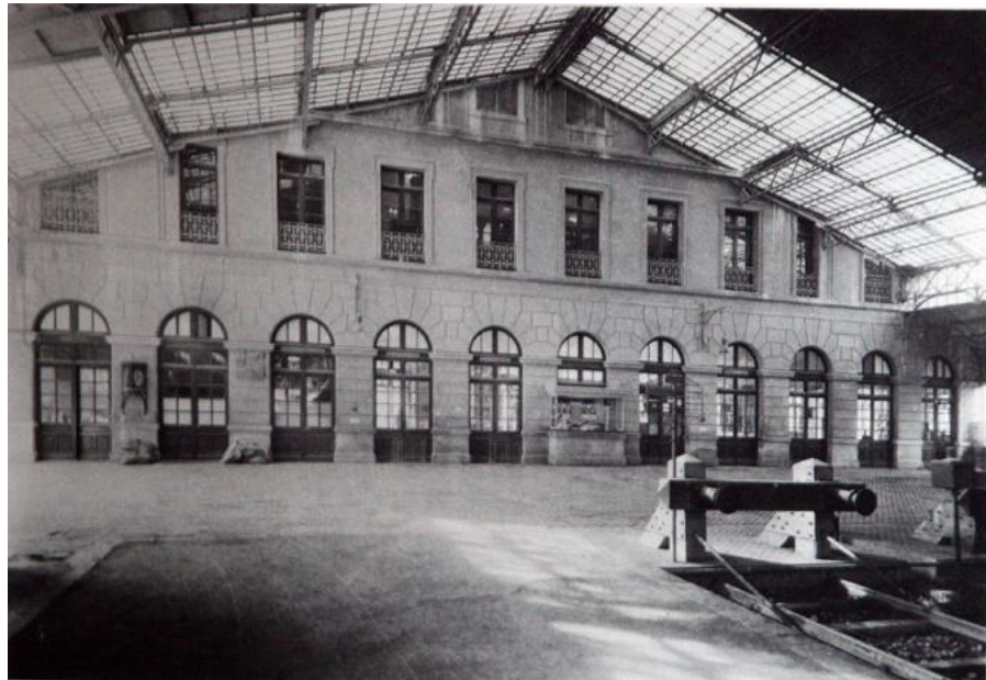
Fig. nº 21.- Vista interior. Estación de Aragón. "Caminos de hierro, estaciones, puentes, viaductos y locomotoras". Col. De Ingenieros de Caminos C.V.
