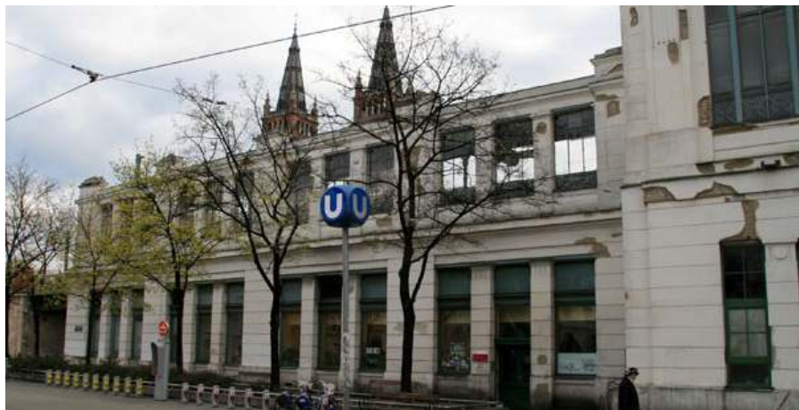
Fig. nº 321 y 322.- Vistas de una de las fachadas principales. Estación de Josefstädter Strasse. Archivo propio (2008).
