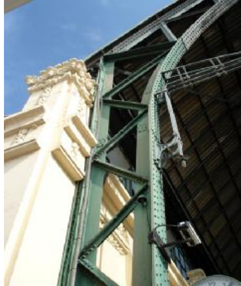
Fig. nº 452 y 453.- Detalle soportes bóveda. Estación de Valencia (A. propio 2007-2011).
