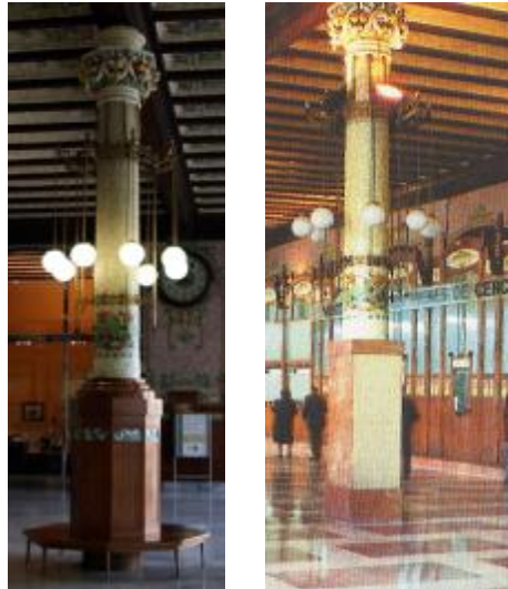
Fig. nº 296 y 297.- Vista de columna exenta después y antes de la reforma de 2004. Vestíbulo E. de Valencia. (A. Propio 2011 – R. Moreno Tomás).
