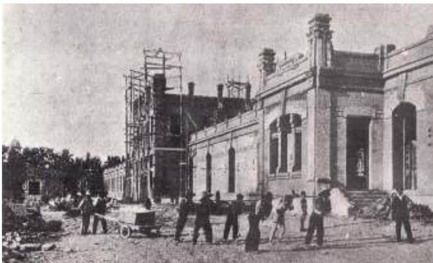
Fig. nº 24.- Vista de la Estación del Norte en construcción. Archivo Las Provincias.
