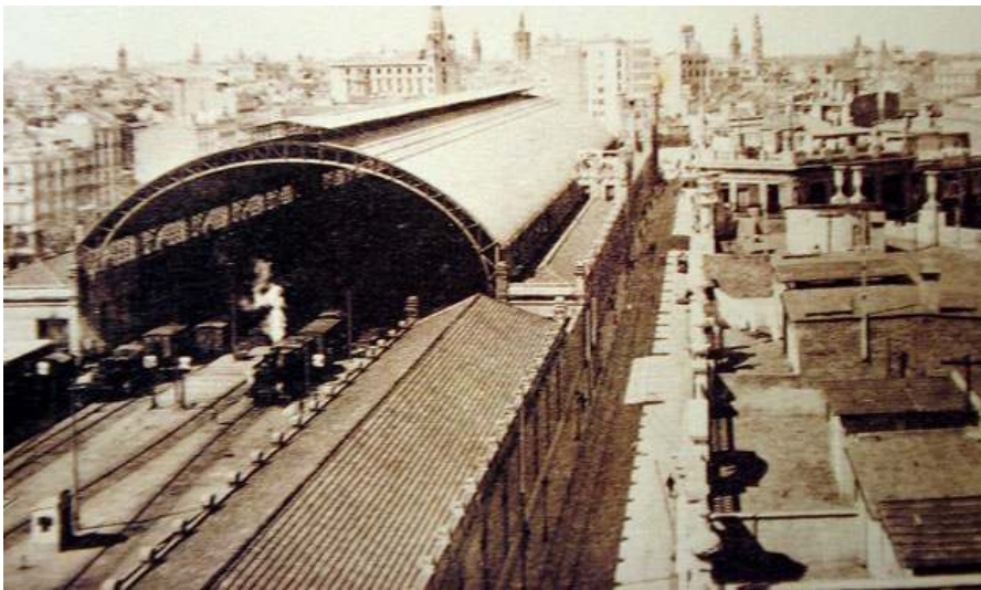
Fig. nº 14.- Vista antigua Estación de Valencia. Reg. Arq. S. XX. (C.V.).
