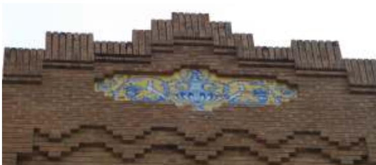
Fig. nº 56.- Detalle de la fábrica y del panel cerámico. Archivo propio (2010).
