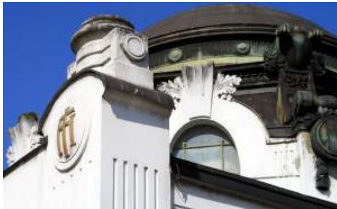
Fig. nº 251 y 252.- Detalle de la cúpula. E. de Schönbrunn. Hofpavillon. A. propio (2008).
