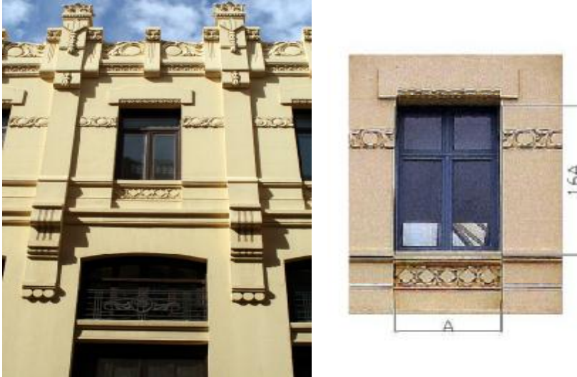
Fig. nº 194 y 195.- Detalle vanos c. de transición. F. c. Bailén. E. de Valencia. (A. Propio 2007-2011).
