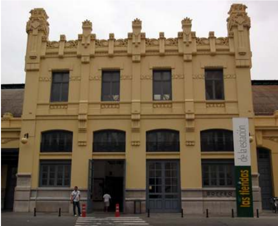
Fig. nº 42.- Vista huecos fachada lateral. A. Propio (2011).
