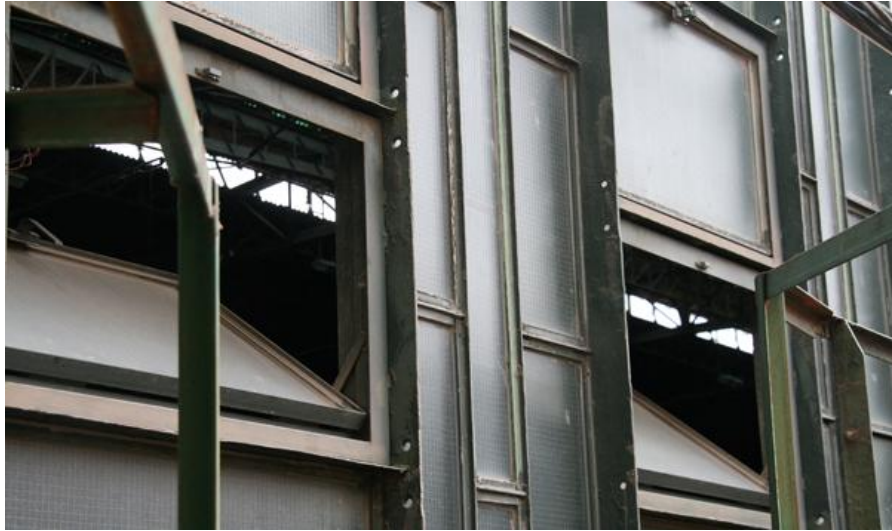
Fig. nº 488.- Detalle de vidrio y carpintería. Vanos corridos laterales nave andenes y vías. Estación de Valencia. (A. Propio 2011).
