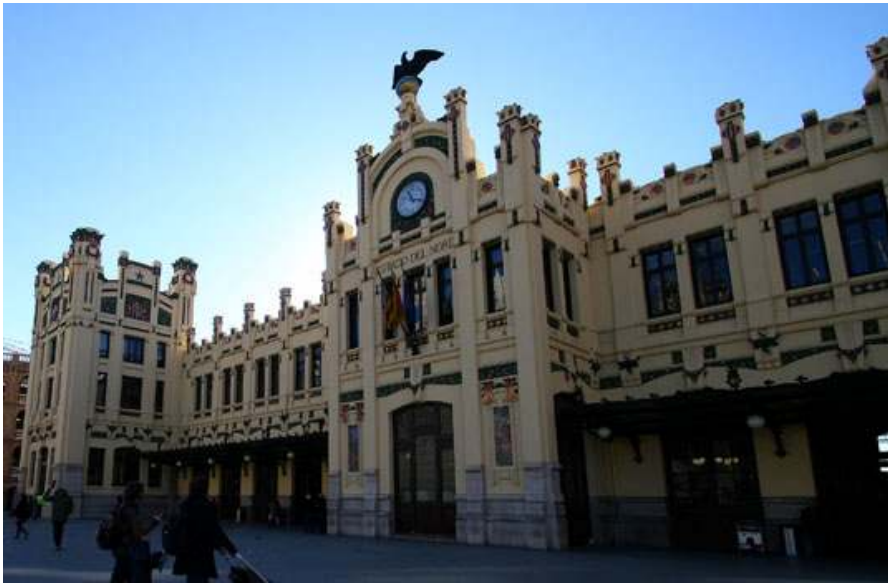
Fig. nº 106.- Fachada principal hospital para enfermos de Lupus. "Wagner". A. Sarnitz.
