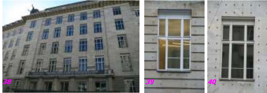
Fig. nº 38 a 40.- Detalles de la fachada principal de la Caja Postal de Ahorros (1903-1912). Tipos de huecos. Archivo propio. (2008).
