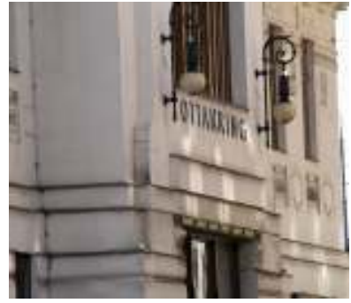
Fig. nº 122 y 123.- Detalle de la decoración del antepecho de los huecos ubicados en los cuerpos laterales, detalle del vierteaguas, detalle del dintel de hierro evidenciado en los huecos del cuerpo central, detalle de las farolas y del tipo de letra empleado en el letrero. Estación de Ottakring. Archivo propio (2008).
