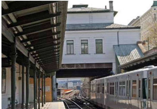
Fig. nº 242.- Vista de la fachada posterior y de andén. E. de Schönbrunn. A. Propio (2008).
