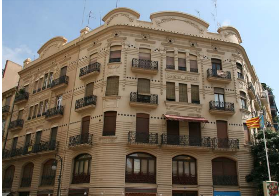
Fig. nº 17.- Vista del chaflán del edificio que nos ocupa. Archivo propio (2009).
