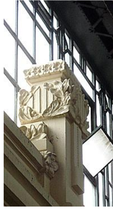
Fig. nº 135.- Detalle encuentro cercha con ventana corrida. E. de Valencia. (FFE-2008).
