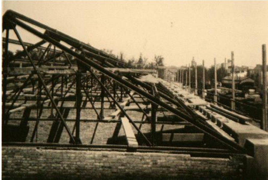
Fig. nº 251.-Vista de la construcción de la cubierta. Ala lateral derecha. E. de Valencia. "La mirada de l'arquitecte".
