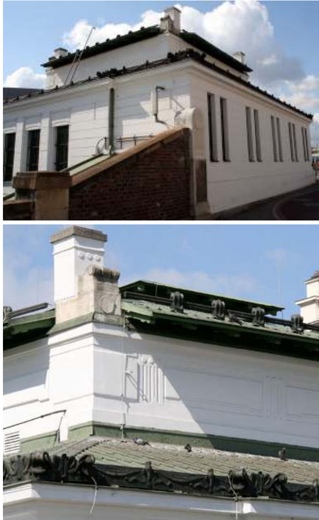
Fig. nº 231 y 232.- Detalle de la cubierta y vista de la fachada lateral izquierda. Estación de Margaretengürtel. Fuente: Archivo propio (2008).
