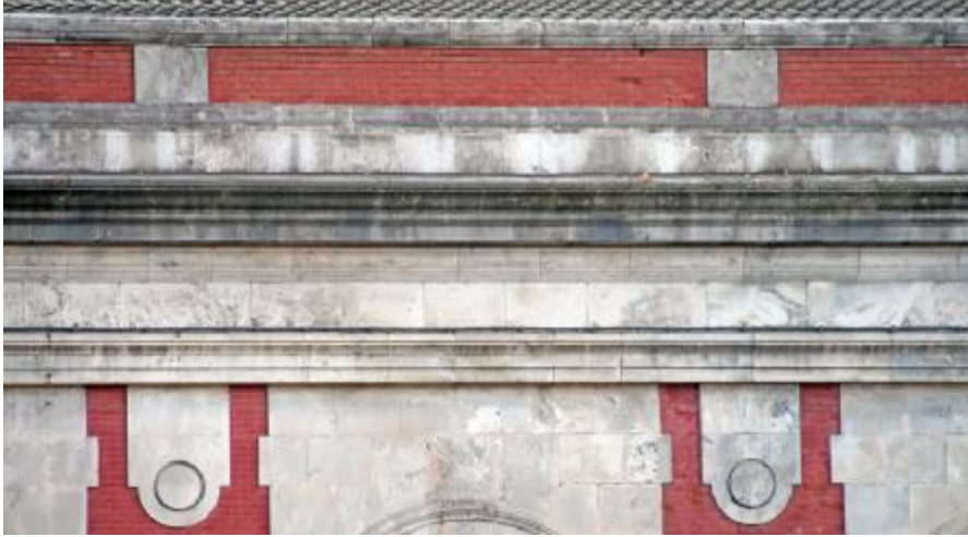
Fig. nº 204.- Detalle de cornisa. E. Burgos. Archivo propio (2011).
