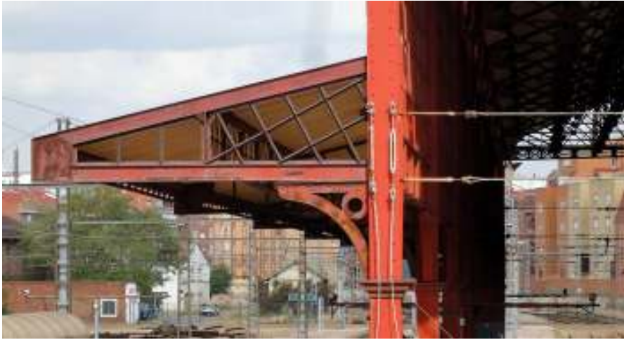
Fig. nº 110.- Detalle de alero. Estación de León. A. propio (2011).
