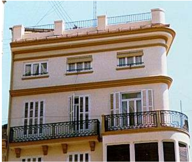
Fig. nº 123.- Vista del alzado recayente a C/ Adressadors. Reg. Arq. SXX. C.V.
