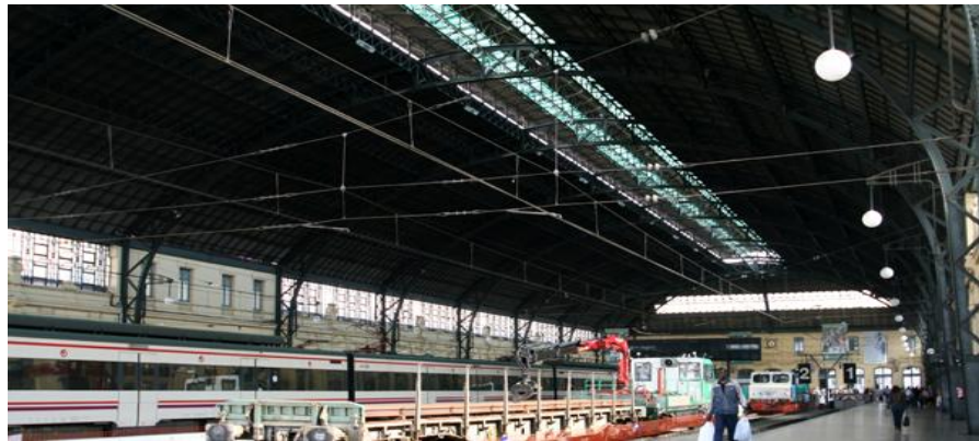
Fig. nº 477 y 478.- Vistas interiores bóveda. Estación de Valencia. (A. Propio 2007-2011).
