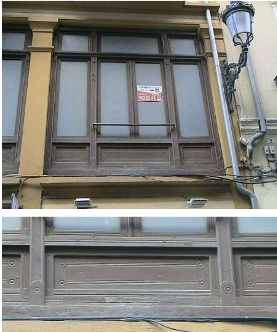
Fig. nº 132 y 133.- Detalles de hueco de la entreplanta. Fachada principal. A. Propio (2010).
