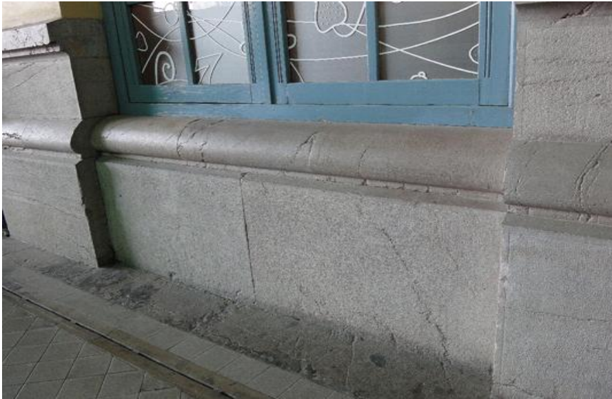
Fig. nº 511.- Detalle aparejo zócalo f. interiores. Estación de Valencia. (A. Propio 2007-2011).
