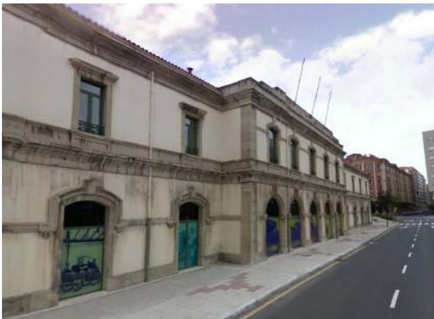
Fig. nº 97.- Vista actual fachada principal estación Gijón. A. Propio. (2007).
