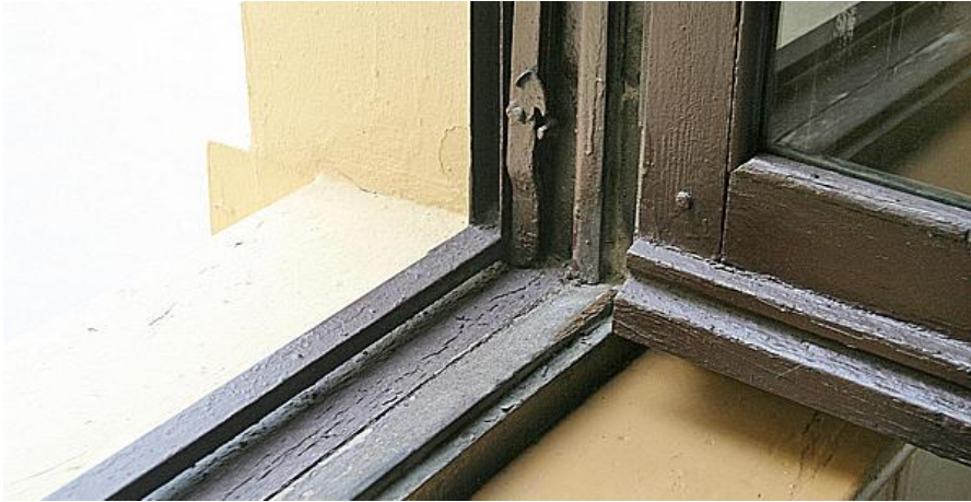
Fig. nº 372.- Detalle de carpintería exterior. Acceso torreón izquierdo. (Archivo propio - 2007-2011).
