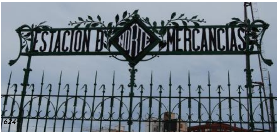
Fig. nº 621 a 624.- Detalle barandilla y puerta zona de mercancías. Estación de Valencia. (A. Propio 2011).
