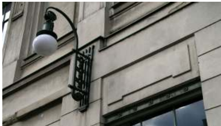
Fig. nº 327.- Detalle de farola. Estación de Josefstädter Strasse. Archivo propio (2008).
