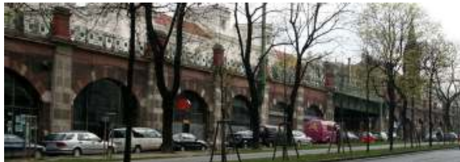
Fig. nº 312.- Viaducto exterior. Estación de Alser Strasse. Archivo propio (2008).
