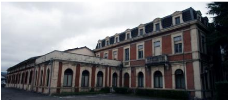
Fig. nº 226 y 227.- Vista actual y ed. auxiliar. E. Irún. (Archivo propio 2011).
