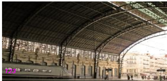
Fig. nº 119 a 123.- Vista estancias orig. pl. baja (*). E. de Valencia. A.Propio (2007-2011).
