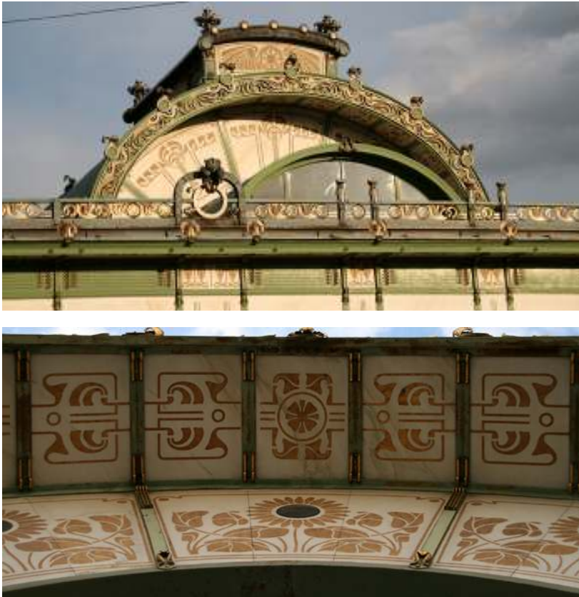
Fig. nº 187 y 188.- Detalle de la cubierta. Estación de Karlsplatz. A. propio (2008).
