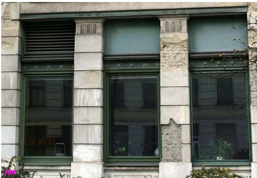
Figs. 328 a 330.- Vistas fachadas, detalle acceso y detalle huecos planta baja. E. de Josefstädter Strasse. Archivo propio (2008).
