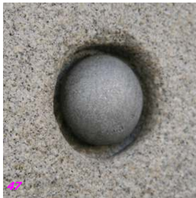
Fig. nº 45 y 46.- Detalles alero, chafalán y escultura coronación f. principal. A. Propio. (2008). Fig. nº 47 y 48.- Detalle de uno de los roblones que sujeta las placas de granito. Detalle de letrero y de cerrajería. A. Propio. (2008).
