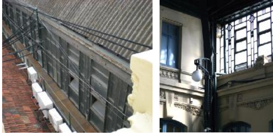
Fig. nº 482 y 483.- Detalle de canalón y de bajante en esquina. Estación de Valencia. (A. Propio 2007-2011).
