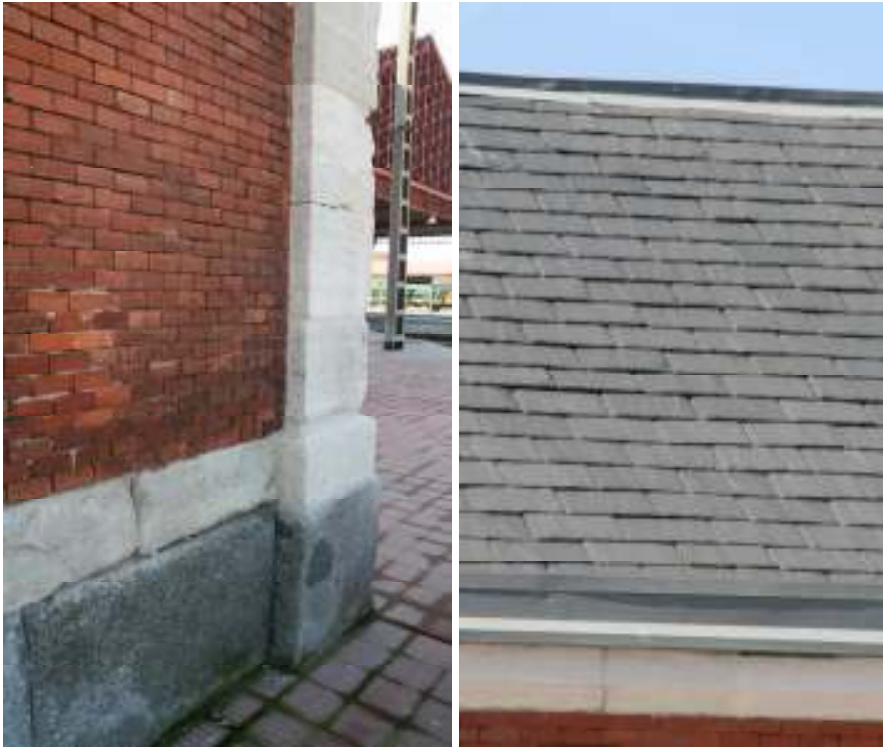
Fig. nº 143 y 144.- Detalles de paramento y cubierta del edificio de viajeros. Estación de Medina del Campo. Archivo propio (2011).
