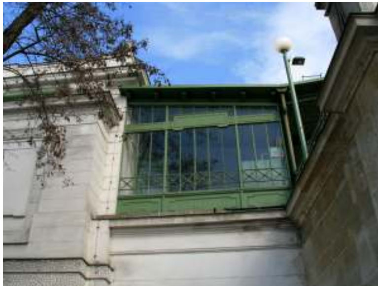
Fig. nº 388 y 389.- Vistas de una de las torres y de uno de los testeros del edificio. Estación de Gumpendorfer strasse. Fuente: Archivo propio (2008).
