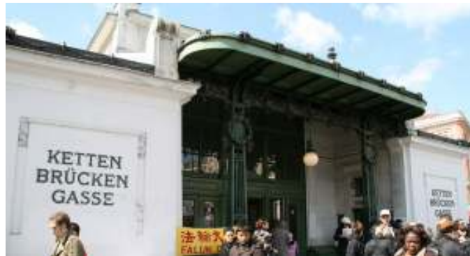
Fig. nº 202.- Vista de la fachada principal. Estación de Kettenbrückengasse. A. Propio (2008).
