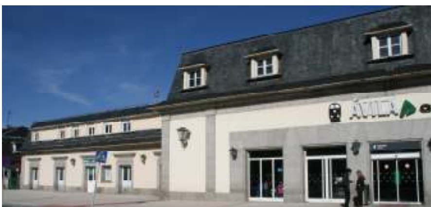
Fig. nº 145 y 146.- Vistas de la fachada principal. Estación de Ávila. Archivo propio (2011).
