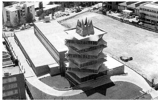
Fig. nº 17 y 18.- Las 4 columnas de Montjuïc (Puig i Cadafalch) y los laboratorios Jorba (Fisac). Registro de arquitectura moderna.
