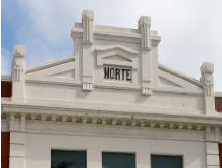
Fig. nº 217.- Detalle frontón ppal. Estación de Palencia. A. Propio (2011).
