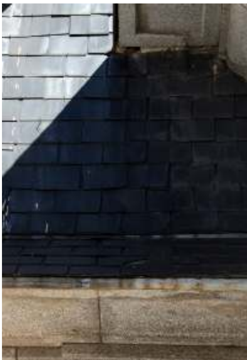
Fig. nº 153.- Detalle pizarra de cubierta. Estación de Ávila. A. propio (2011).
