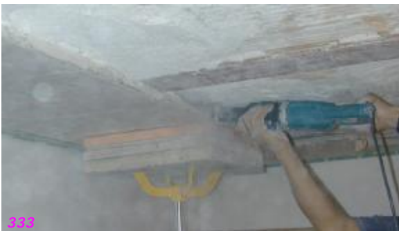
Fig. nº 331 a 333.- Detalles diversos restauración techo Antiguo café. Estación de Valencia. (Archivo propio 2007-2011).
