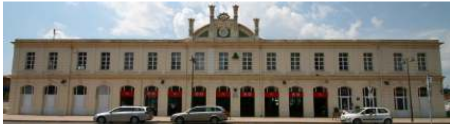
Fig. nº 237 y 238.- Vistas fachada principal. Estación de Vic. A. Propio (2011).
