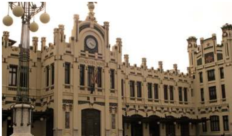
Fig. nº 74.- Vista F. ppal. E. de Valencia. A. propio (2011).
