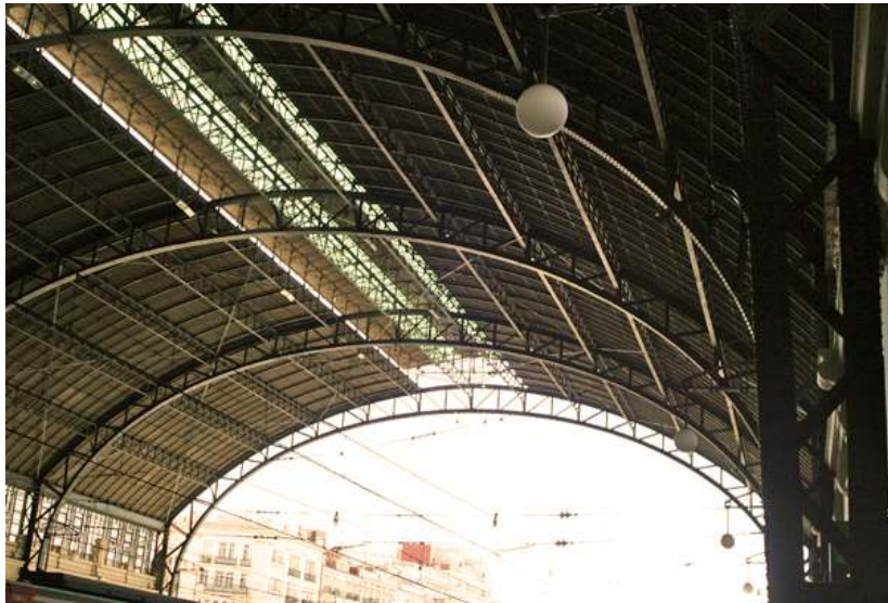
Fig. nº 33.- Detalle cerchas cubierta. E. de Valencia. A. propio (2011).
