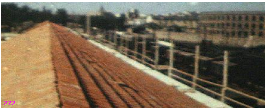
Fig. nº 270 a 272.- Secuencia construcción cubierta inclinada. Alas laterales ed. de viajeros. E. de Valencia. "La mirada de l'arquitecte".
