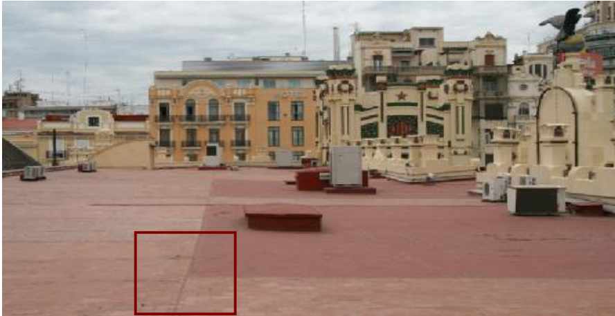
Fig. nº 581.- Vista de la cubierta plana. Ed. de viajeros. E. de Valencia. (A. Propio 2011).
