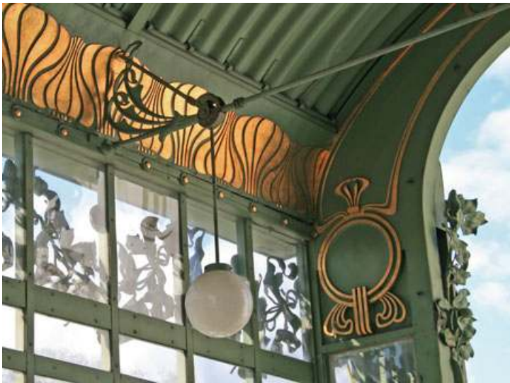
Fig. nº 257 y 258.- Vistas interiores del porche de acceso. Detalles de la cubierta y de la decoración. Estación de Schönbrunn. Hofpavillon. Archivo propio (2008).
