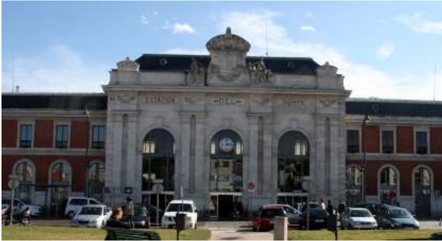
Fig. nº 59- Vista f. ppal. E. de Valladolid. A. propio (2010).
