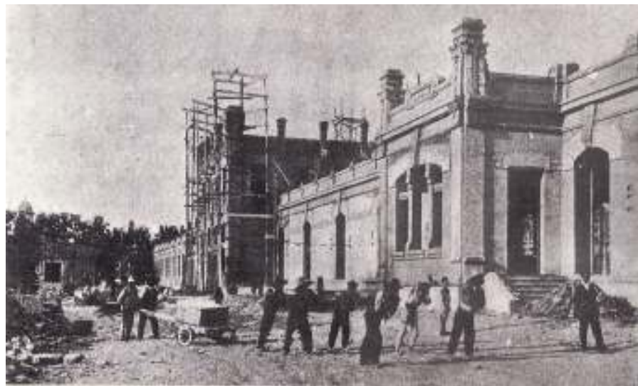
Fig. nº 4.- Vista de la nueva estación del Norte en construcción. J. Furió.
