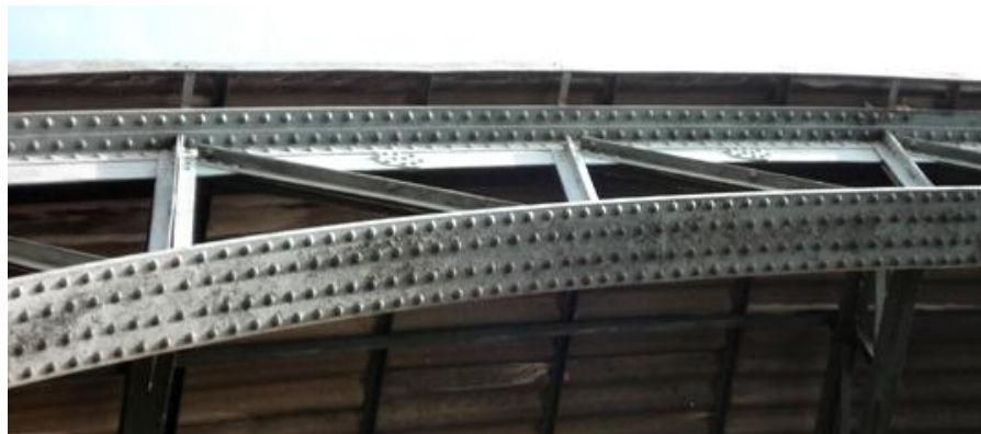
Fig. nº 458.- Detalle cercha. Estación de Valencia. (A. Propio 2007-2011).
