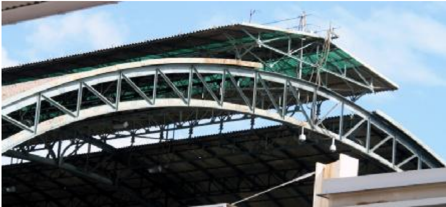
Fig. nº 134.- Detalle de parte superior de arco y lucernario de la bóveda metálica. Estación de Valencia. A. Propio (2010).
