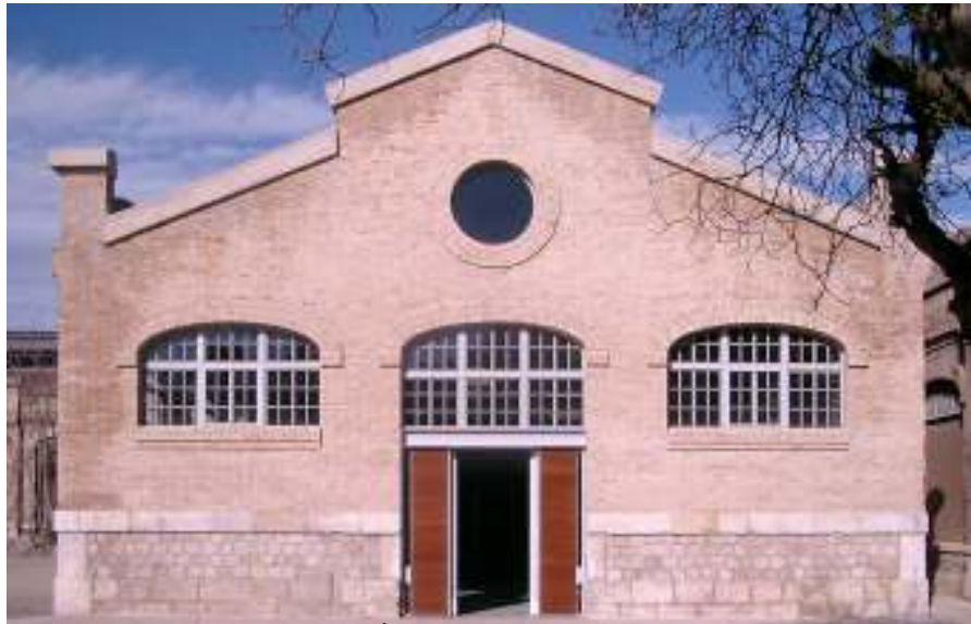
Fig. nº 198.- Alzado principal almacén gemelo (Ed. nº 7). Ponencia J. Pérez Igualada. Seminario Grandes estaciones del siglo XXI (2009).
