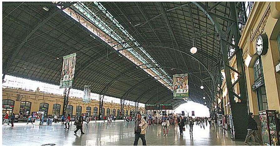
Fig. nº 222.- Vista de una de las fachadas interiores laterales. E. de Valencia (A. propio 2007)
