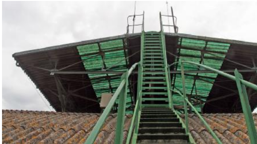
Fig. nº 151.- Vista del lucernario. Estación de Valencia. A. propio (2011).
