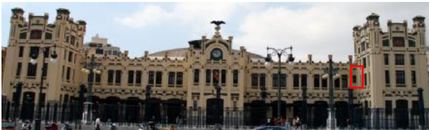
Fig. nº 162.- Vista de la fachada principal. Estación de Valencia. (Archivo propio 2008).
