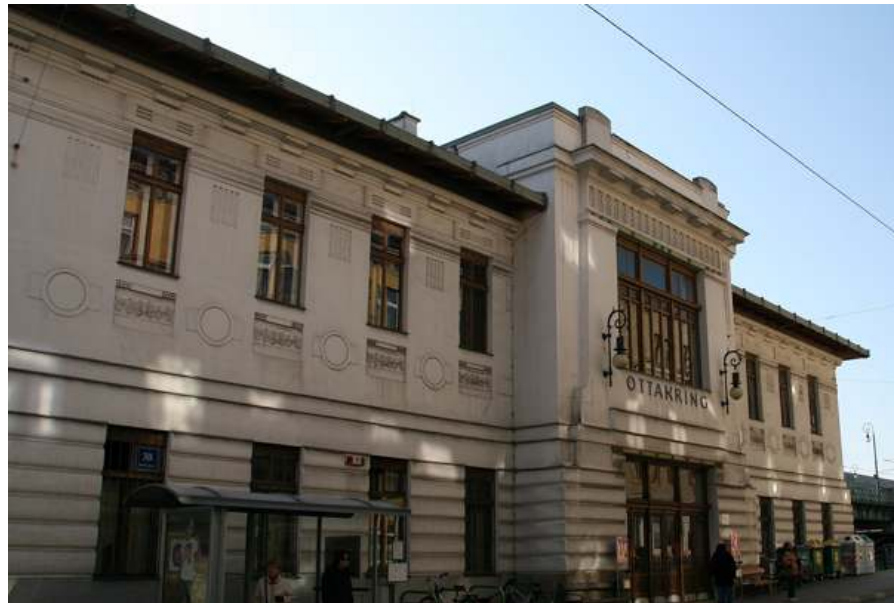
Fig. nº 113.- Fachada principal estación Ottakring. Archivo propio (2008).
