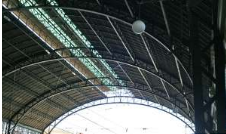
Fig. nº 190.- Vista bóveda metálica. E. de Valencia. A. propio (2011).
