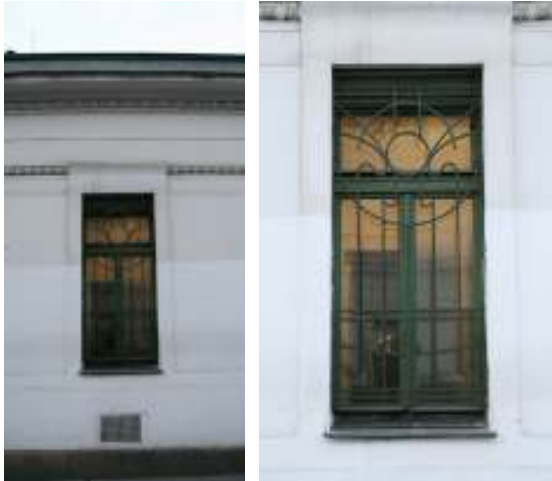
Fig. nº 131 y 132.- Detalles de los huecos existentes en la fachada lateral izquierda. Estación de Friedensbrücke. Archivo propio (2008).
