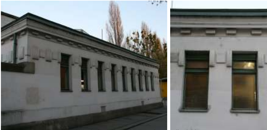
Fig. nº 154 y 155.- Vista de la fachada lateral izquierda. Detalle del hueco existente. Estación de Rossauer Lände. A.propio (2008).
