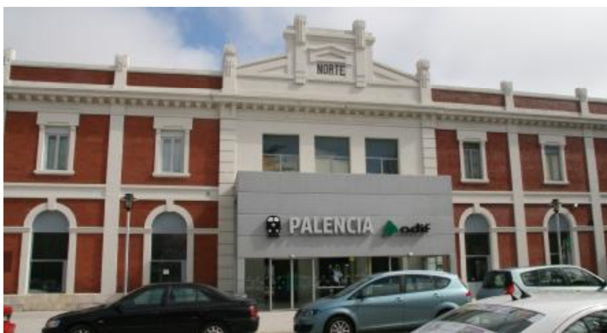
Fig. nº 183.- Vista fachada principal. E. Palencia. (Archivo propio 2011).
