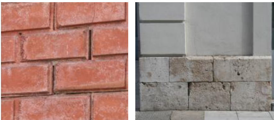
Fig. nº 188 y 189.- Detalle ladrillo y zócalo. E. Palencia. (Archivo propio 2011).
