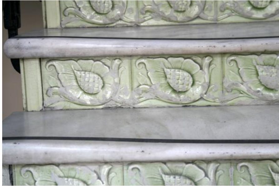
Fig. nº 399.- Detalle piezas revestimiento peldaños. Núcleo escaleras torreón izquierdo. (A. Propio - 2011).
