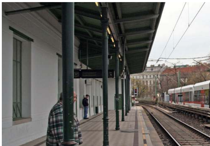
Fig. nº 272 y 273.- Vista del edificio desde los andenes. Estación de Nussdorfer Strasse. Fuente: Archivo propio (2008).
