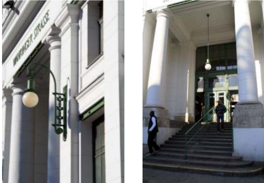
Fig. nº 285 y 286.- Vistas y detalles de las fachadas recayentes a la vía pública. Estación de Währinger Strasse Volksoper. Archivo propio (2008).
