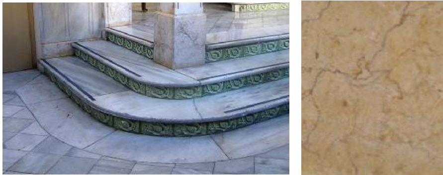
Fig. nº 360.- Detalle de solado en escalones. Zona de acceso al torreón izquierdo. (A. Propio 2011).
