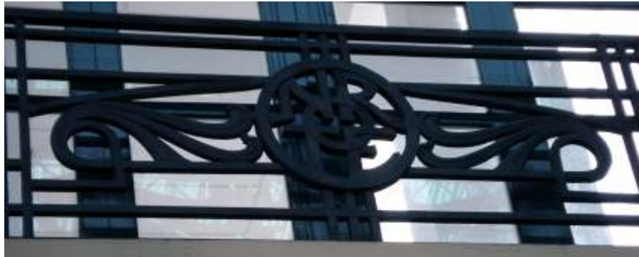
Fig. nº 265.- Detalle de barandilla exterior. E. de Valencia. Archivo propio (2007).
