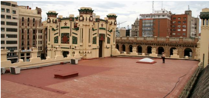
Fig. nº 578.- Vista de la cubierta plana. Ed. de viajeros. E. de Valencia. (A. Propio 2011).
