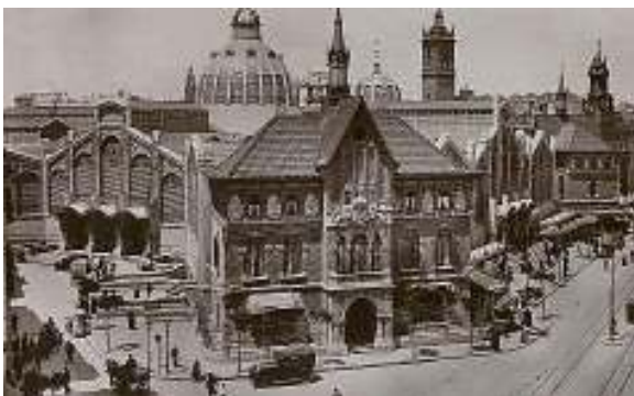
Fig. nº 6 y 7.- Mercado Central en construcción y en funcionamiento. Archivo Las Provincias.
