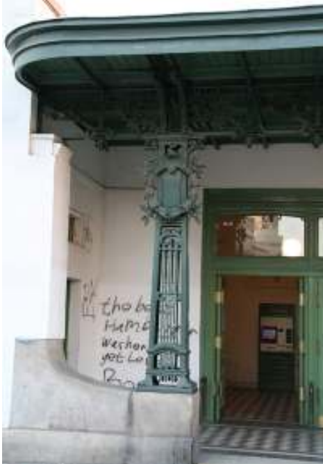
Fig. nº 145 y 146.- Vista y detalle del acceso. Estación de Rossauer Lände. Fuente: Archivo propio (2008).
