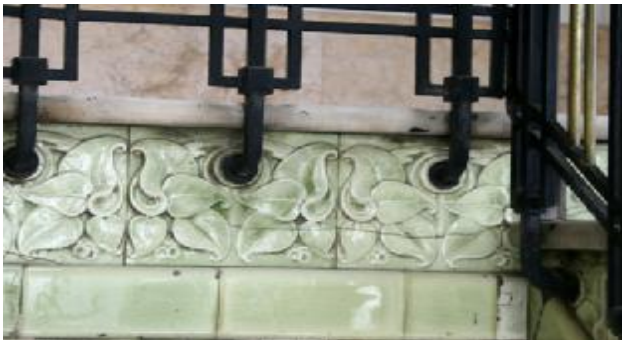
Fig. nº 398.- Detalle piezas revestimiento frente forjados. Núcleo escaleras torreón izquierdo. (A. Propio - 2011).
