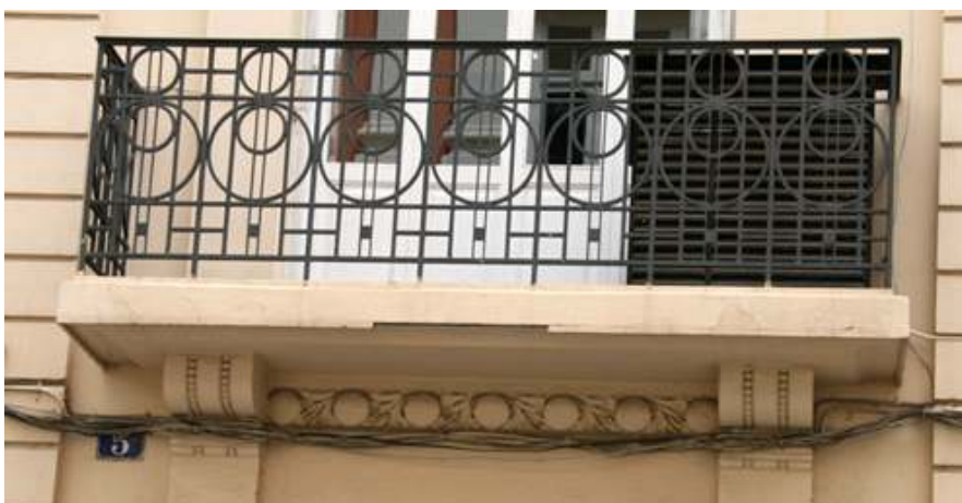
Fig. nº 7 y 8.- Detalles de barandillas. E. de Rosauerlande (Viena). Ed. Pérez Pujol, 5. A. Propio (2008-2009).
