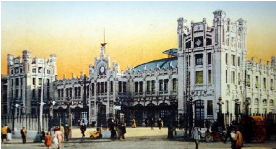
Fig. nº 131.- Vista antigua Estación de Valencia. FFE-2008
