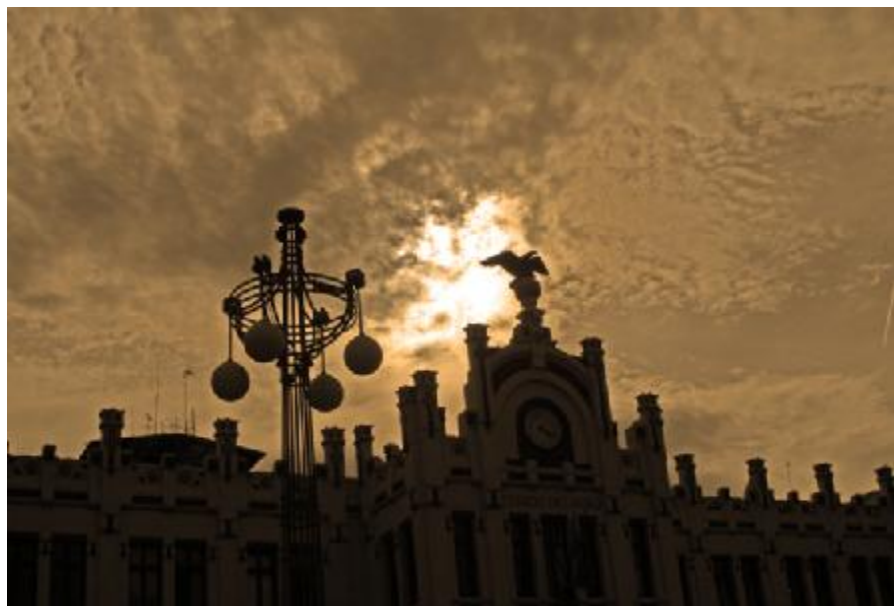
Fig. nº 635 y 636.- Detalles de verja y farola exterior. Estación de Valencia. (A. Propio 2007– 2011).
