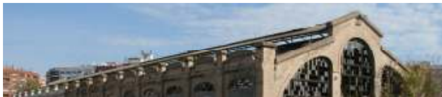
Fig. nº 204.- Vista general del centro de rodaje. Archivo propio (2010).
