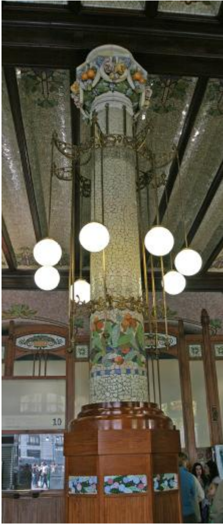
Fig. nº 259.- Vista de soporte exento. Vestibulo ed. de viajeros. E. de Valencia. A. propio (2011).
