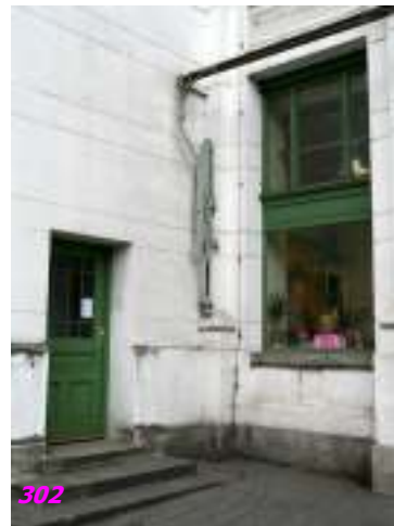
Fig. nº 300 a 302.- Vista del cuerpo lateral de las fachadas principales y detalle de esquina. Estación de Alser Strasse. Archivo propio (2008).
