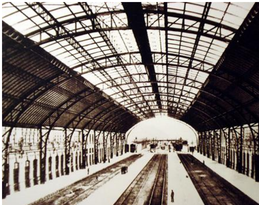
Fig. nº 41.- Vista de la bóveda metálica. Proyecto definitivo E. de Valencia. FFE-2008
