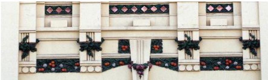
Fig. nº 182.- Detalle decoración arranque pilastras plano ppal. y cuerpos extremos f. ppal. E. de Valencia. A. propio (2011).
