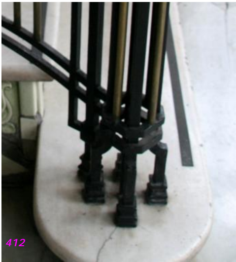
Fig. nº 412 a 414.- Detalles anclajes barandilla. Núcleo escaleras torreón izquierdo. (A. Propio - 2007-2011).
