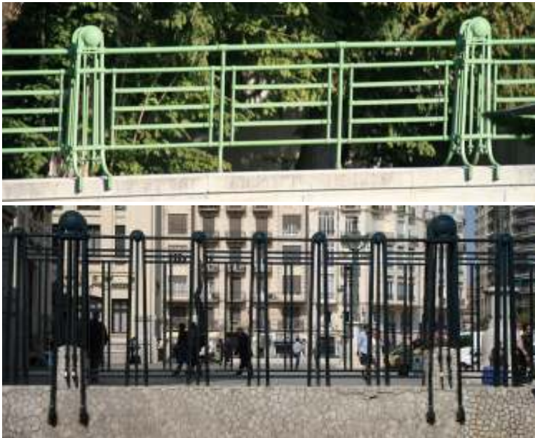
Fig. nº 60 y 61.- barandilla psiquiátrico Steinhoff y verja E. de Valencia. A.Propio (2008-2010).
