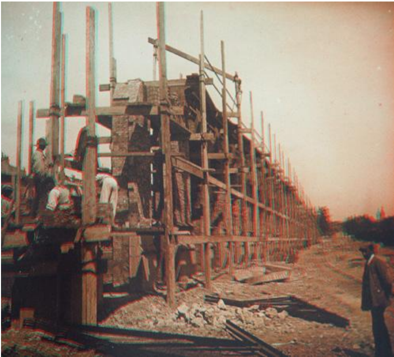
Fig. nº 250.-Vista de la construcción de los muros de cierre. Ala lateral derecha. E. de Valencia. "La mirada de l'arquitecte".
