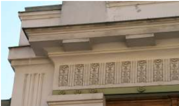
Fig. nº 118 y 119.- Detalle de huecos ubicados en los cuerpos laterales y detalle decorativo del hueco principal. Estación de Ottakring. Archivo propio (2008).
