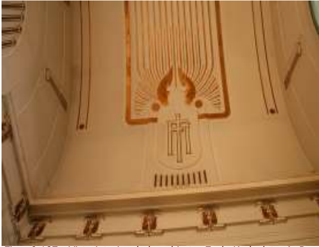
Fig. nº 197.- Vista interior de la cubierta. E. de Karlsplatz. A. Propio (2008).
