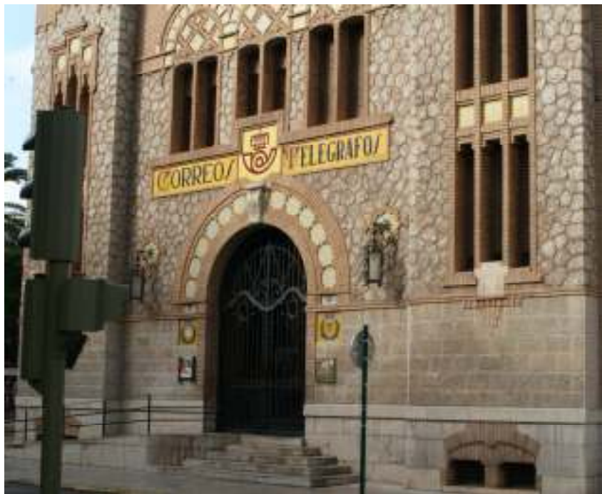
Fig. nº 55.- Vista del acceso. Archivo propio (2010).
