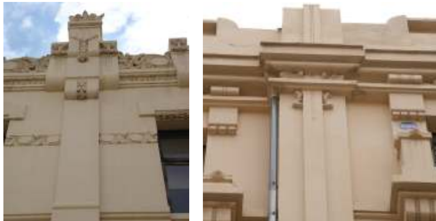
Fig. nº 11 y 12.- Detalle de huecos de planta primera y detalles de fachada. A. Propio (2009).
