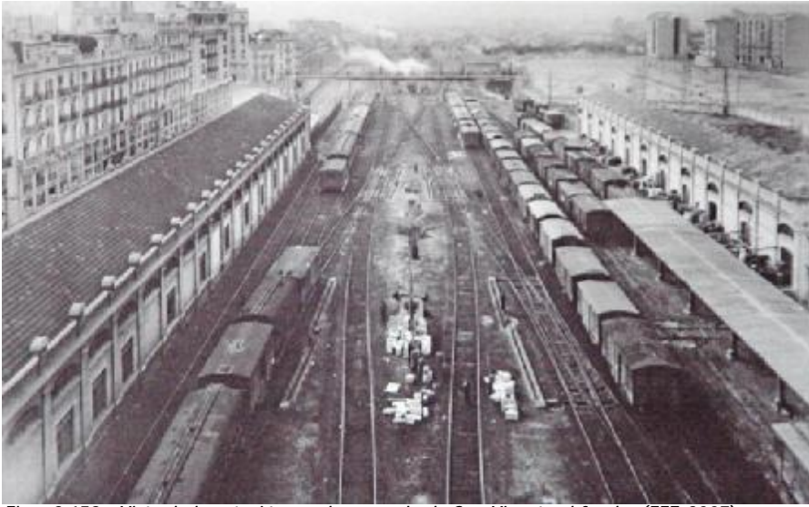
Fig. nº 159.- Vista de la estación con la pasarela de San Vicente al fondo. (FFE-2007).
