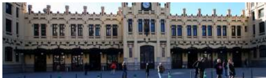
Fig. nº 116 y 117.- Detalle planta baja. E. Ottakring- E. de Valencia. A. propio (2008-2010).
