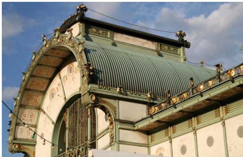
Fig. nº 196.- Vista exterior de la cubierta. E. de Karlsplatz. Archivo propio (2008).
