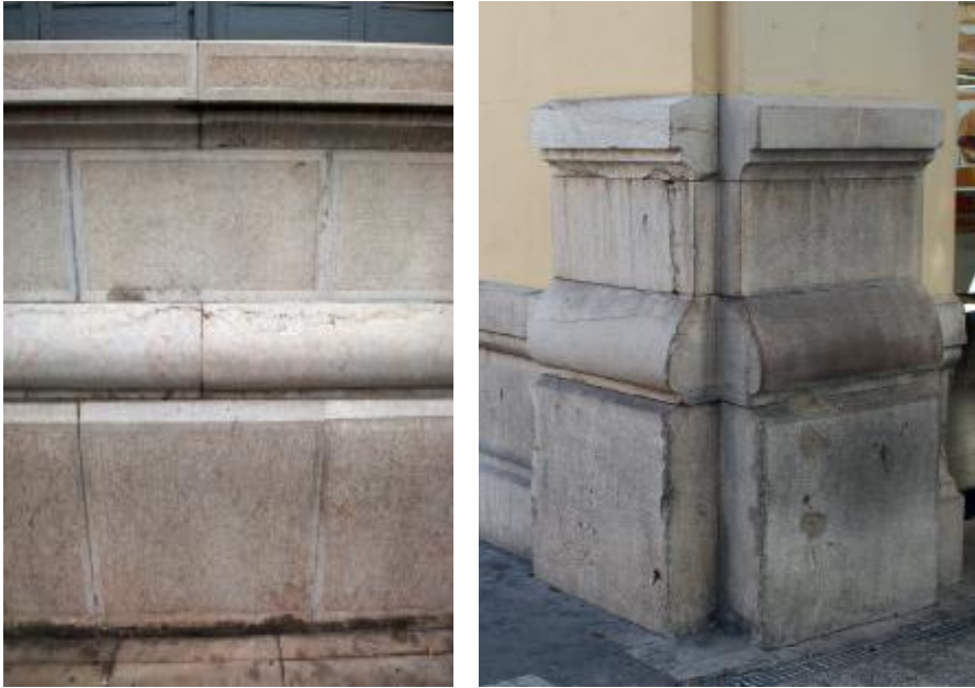
Fig. nº 505 y 506.- Detalle aparejo y esquina zócalo f. exteriores. Estación de Valencia. (A. Propio 2007-2011).
