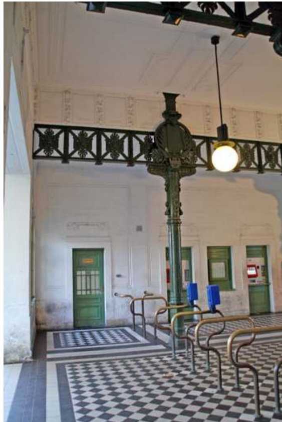
Fig. nº 144.- Vista interior. Estación de Friedensbrücke. Archivo propio (2008).
