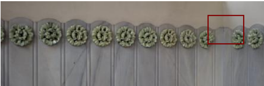
Fig. nº 369.- Detalle remate y encuentro esquina zócalo. Acceso torreón izquierdo. (Archivo propio - 2007-2011).
