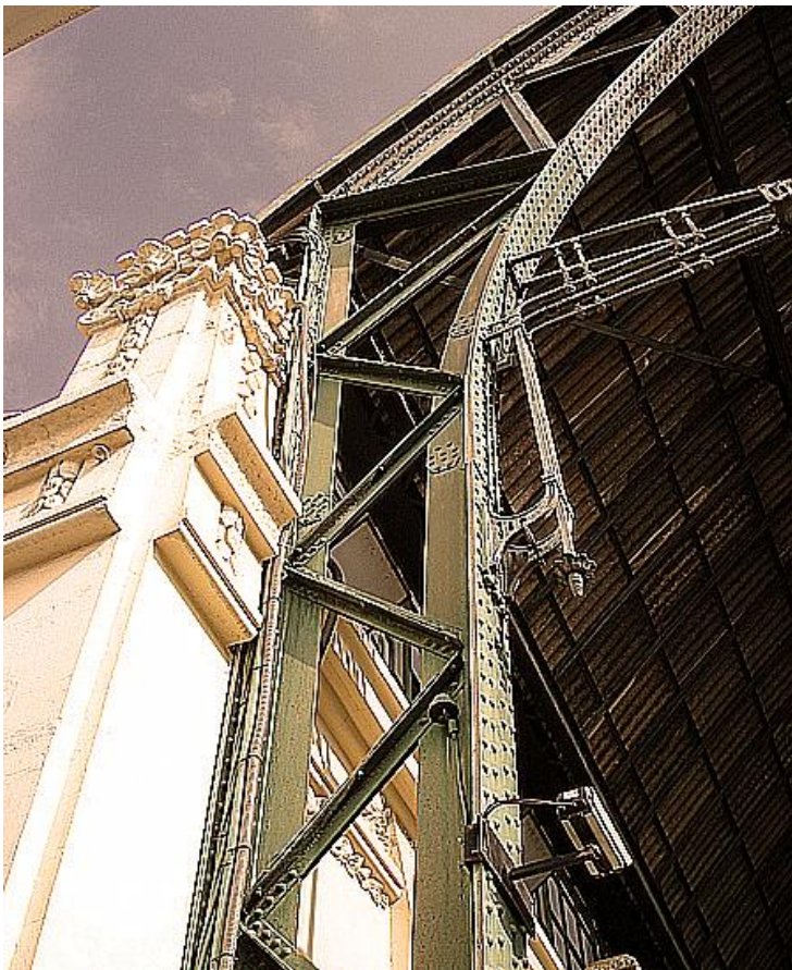
Fig. nº 238.- Detalle soporte estructura metálica. E. andenes y vías. E. de Valencia. A. propio (2007).
