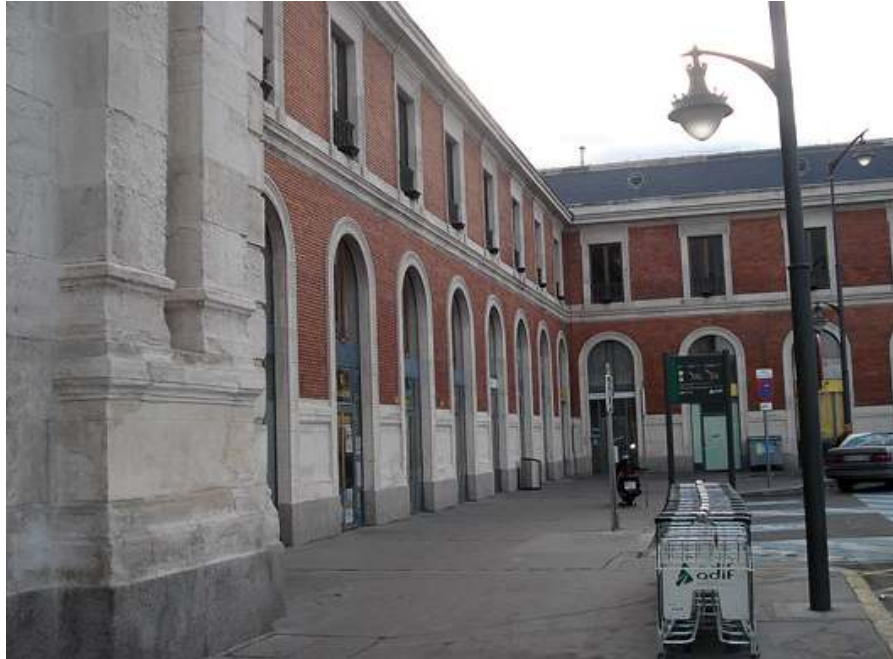
Fig. nº 126.- Detalle de materialidad de la fachada. E. de Valladolid. A. Propio.(2010).
