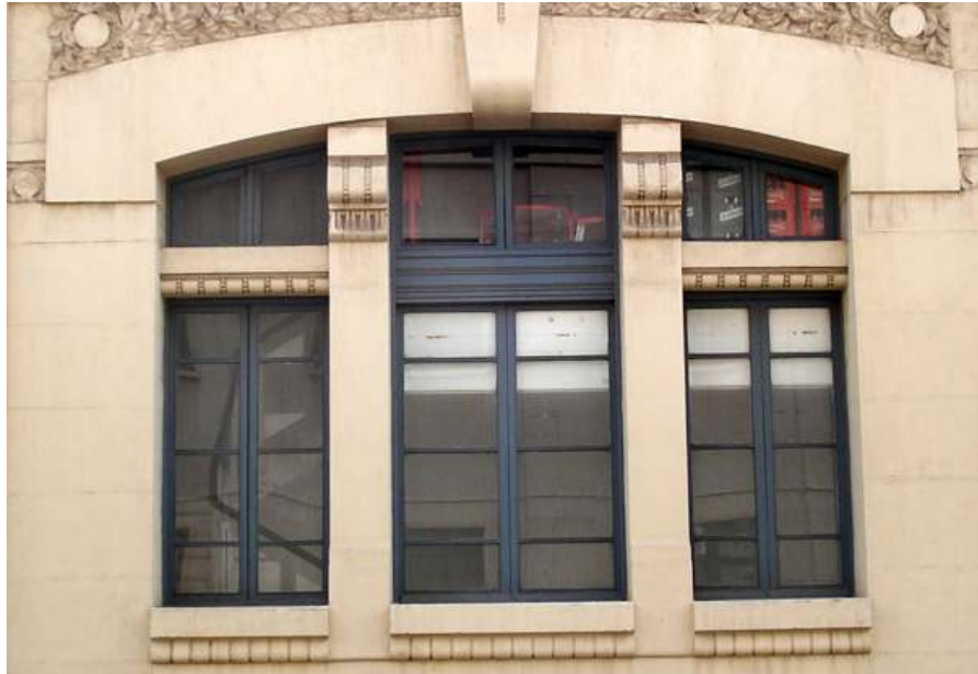
Fig. nº 230.- Detalle hueco f. lateral (C/ Bailén), E. de Valencia. A. Propio (2007).
