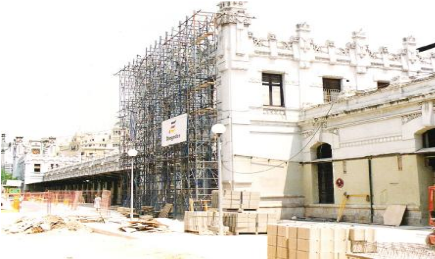
Fig. nº 524.- Vista de fachada lateral en reparación. E. de Valencia. R. Moreno Tomás (2005).
