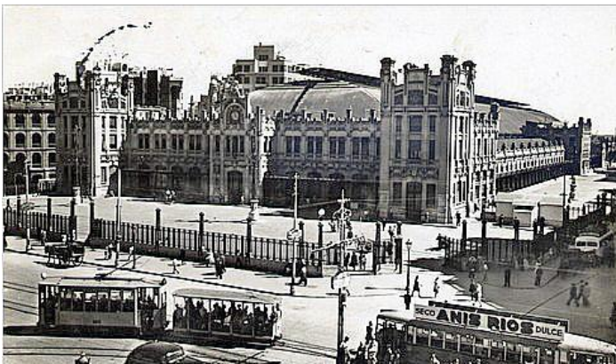
Fig. nº 118.- Vista antigua E. de Valencia. La estación de tren.
