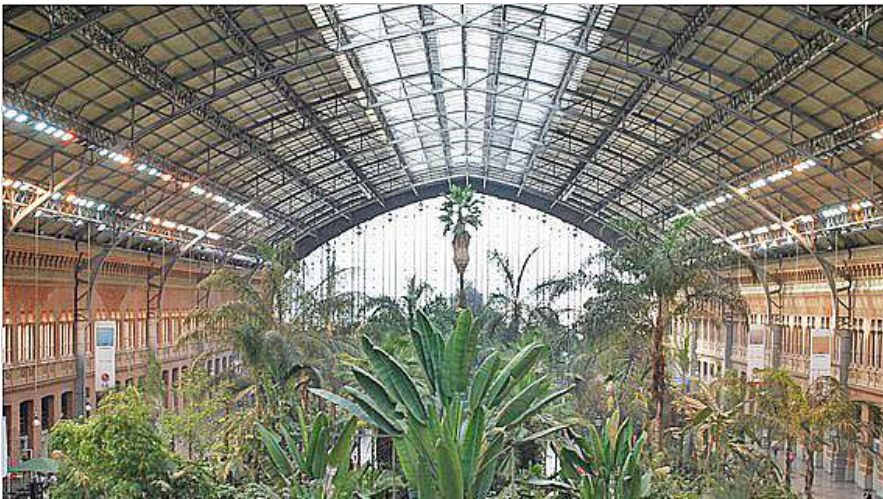
Fig. nº 4.- Cubierta E. de Atocha. A. propio (2010).
