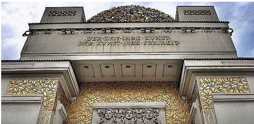
Fig. nº 407.- Fachada principal pabellón Secession. Exposición AZW (2008).
