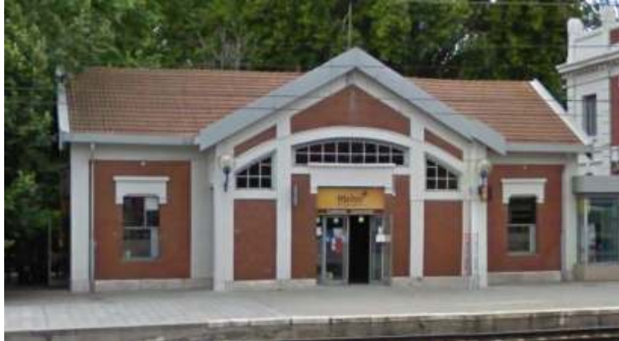
Fig. nº 229.- Ed. anexo (actual cafetería), E. de Palencia. A. Propio (2011-2010).
