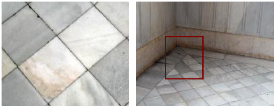
Fig. nº 358 y 359.- Detalle de solado de la zona de acceso al torreón izquierdo. (A. Propio 2011).
