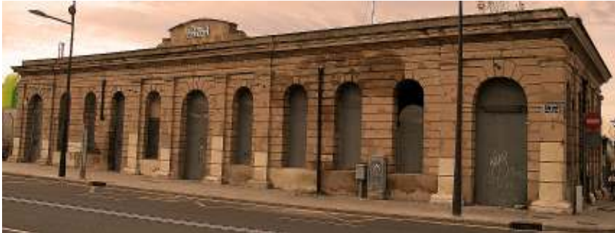
Fig. nº 1.- Estación del Grao. A. Propio (2010).
