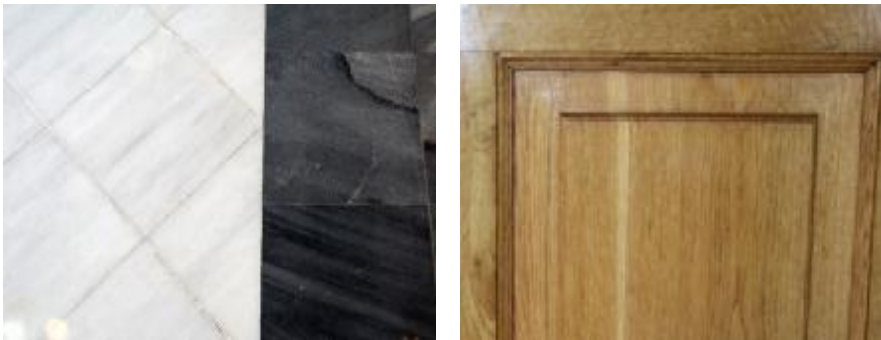
Fig. nº 315 y 316.- .Detalles de suelo y zócalo del antiguo café. Estación de Valencia. (A. Propio 2007-2011).
