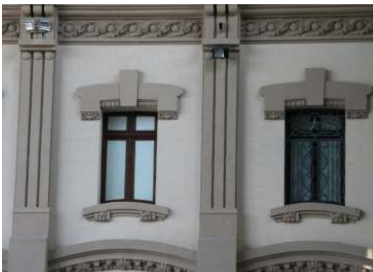
Fig. nº 176.- Detalle de huecos interiores. Obsérvese el diseño de la reja del hueco de la parte derecha. Parte central ampliación. Archivo propio (2010).
