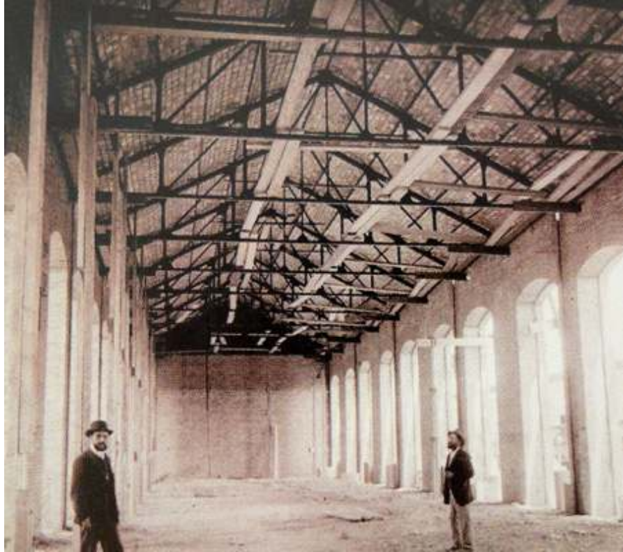
Fig. nº 164.- Vista interior de uno de los muelles de mercancías. "La mirada de l'arquitecte "
