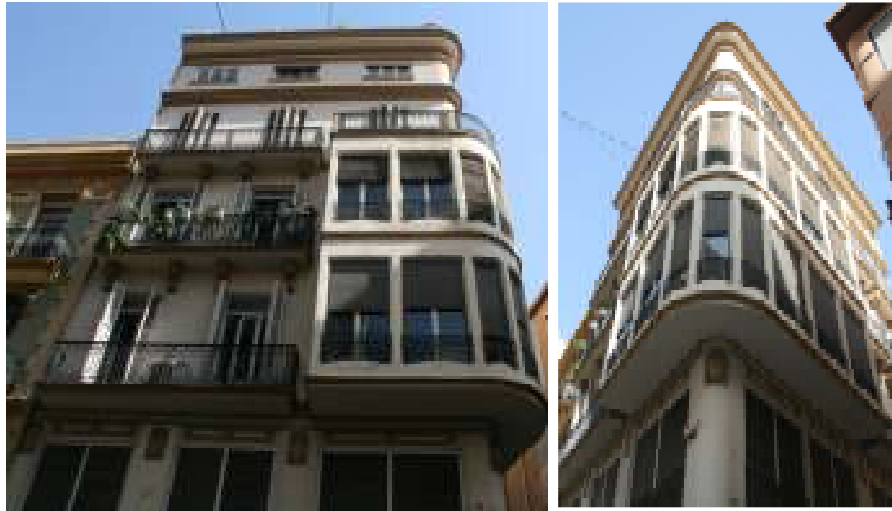
Fig. nº 118 y 119.- Vista del alzado recayente a C. Adressadors y vista de la esquina. A. propio (2010).
