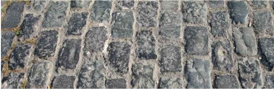
Fig. nº 605.- Vista del adoquinado actual de los carriles del patio de salidas. Estación de Valencia. (A. Propio 2007– 2011).
