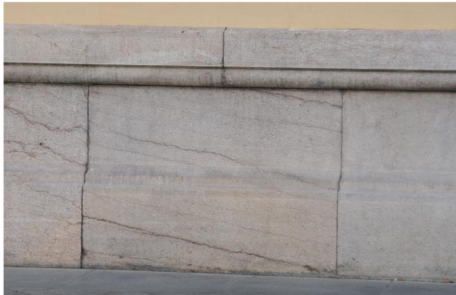
Fig. nº 510.- Detalle aparejo zócalo f. exteriores. Estación de Valencia. (A. Propio 2007-2011).
