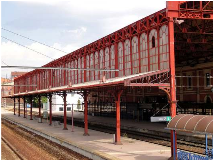
Fig. nº 108 y 109.- Vistas interior y exterior de la cubierta. Estación de León. A. propio (2011). Destacar la sección de la cubierta con la prolongación de alero para protección de los andenes (figs. 109 y 110).
