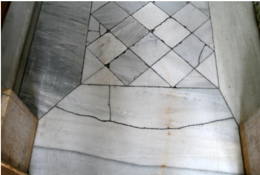
Fig. nº 394.- Detalle de la modulación del solado de uno de los rellanos de la escalera. Núcleo escaleras torreón izquierdo. (A. Propio - 2007-2011).
