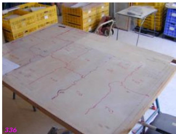
Fig. nº 334 a 336.- Detalles diversos restauración techo Antiguo café. Estación de Valencia. (Archivo propio 2007-2011).
