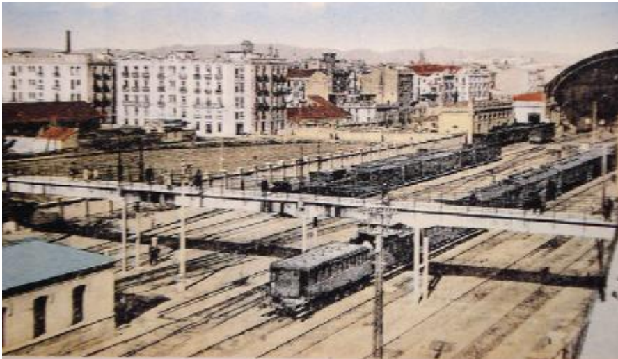
Fig. nº 160.- Vista de la pasarela de San Vicente. Postal anónima. (FFE-2007).
