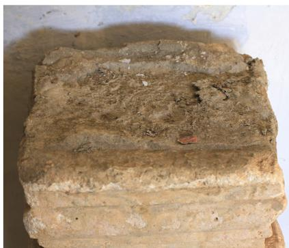
Fig.31 Estado de la parte superior del pilar con la capa de cemento. (Fotografía del autor)
