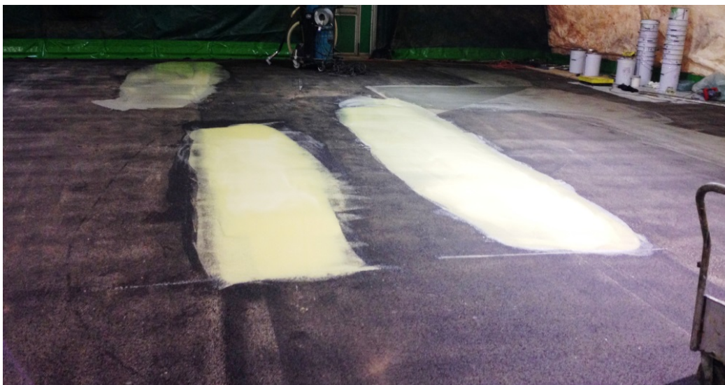
Fig.e. Reparació del clot amb Mapecoat TNS Base Coat
