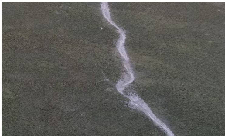
Fig.a. Reparació de fissura
