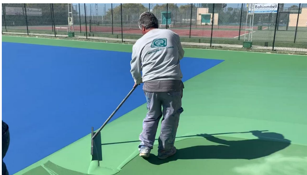
Fig. h: Aplicació de capa base de Mapecoat TNS Color
