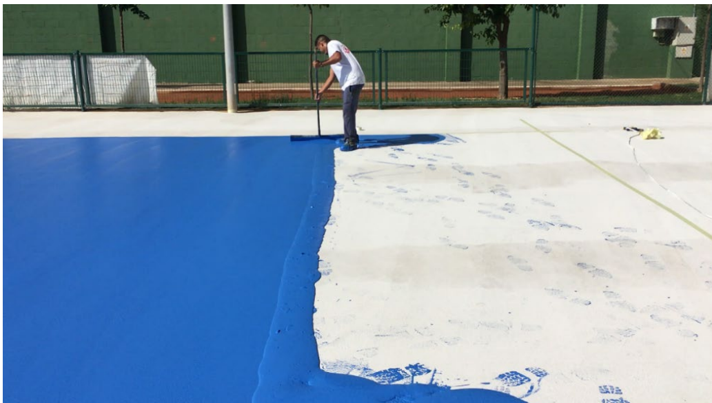
Fig. g. Aplicació de capa base de Mapecoat TNS Finish 1.3.4
