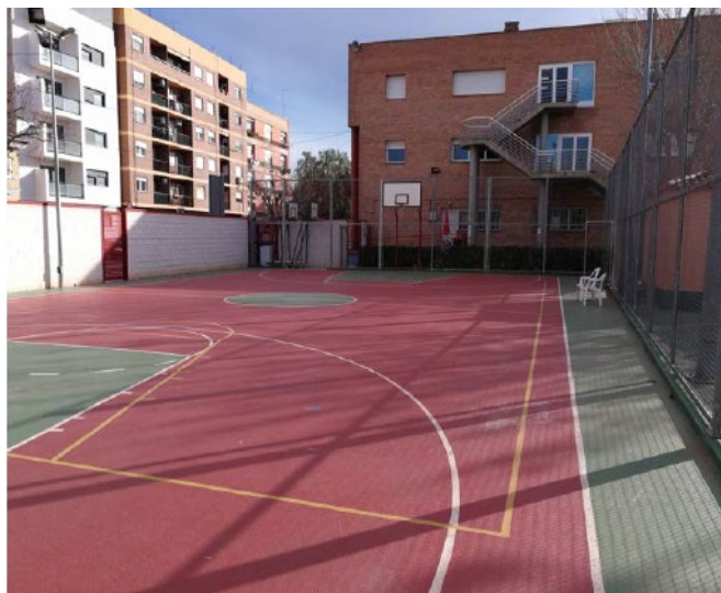
Imatge 1. Pista poliesportiva de formigó drenant
