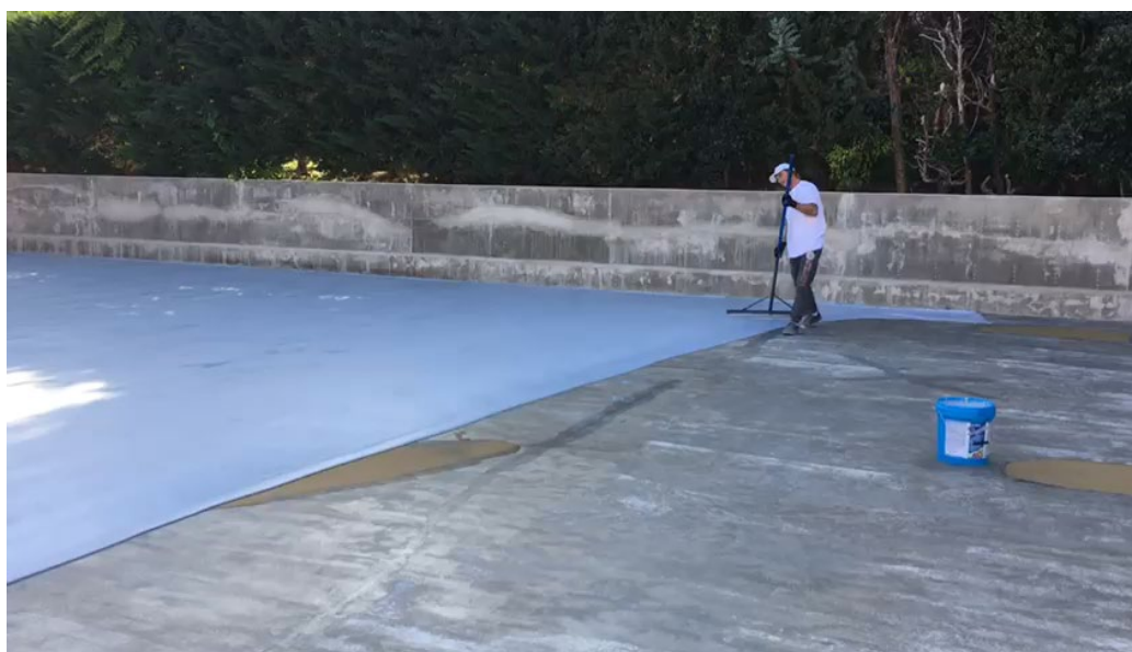
Fig.f. Aplicació de capa base de Mapecoat TNS Base Coat
