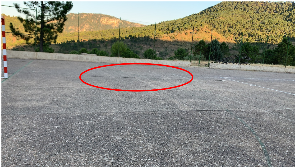
Imatge 7. Pista poliesportiva amb afonament d'unes pastilles respecte de les altres
