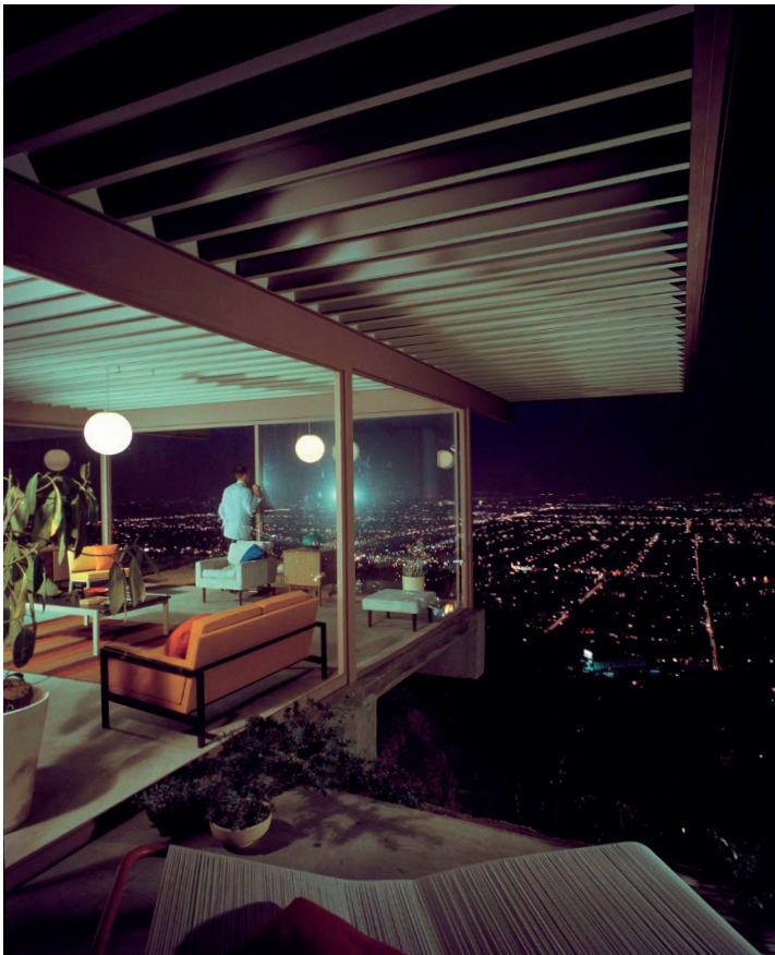
Figuras 10A y 10B. Pierre Koenig, Casa Stahl (CSH #22), Los Angeles, 1959-1960. Relación interior exterior (sup.) y vista nocturna sobre Los Ángeles (inf.).
